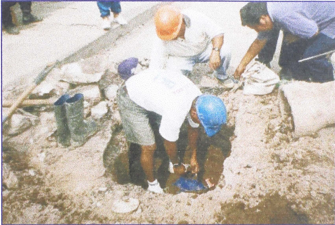
Foto N° 12: Se observa los trabajos de mantenimiento de redes de agua que se ejecutaron. Estos trabajos también incluyen el cambio de válvulas debido a su antigüedad.
