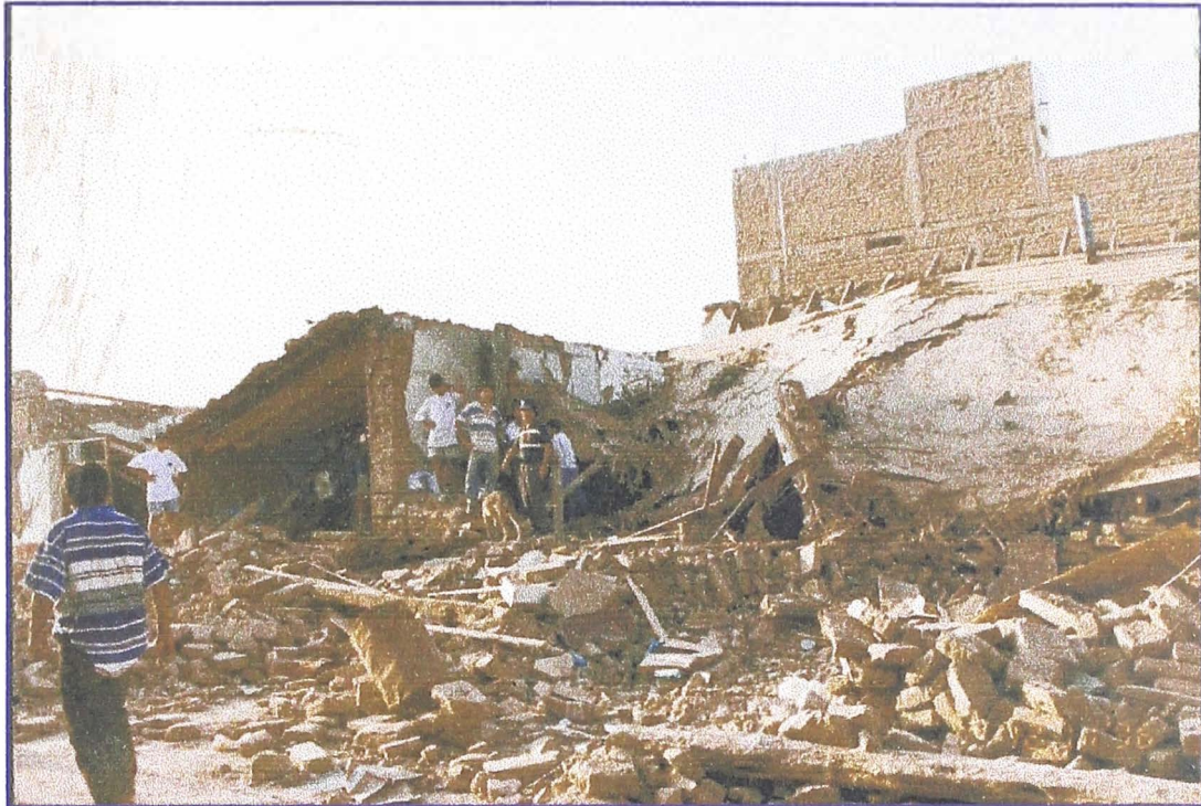
Foto N° 11: Se observa el estado en que ha quedado una casa y la cantidad de desmonte vertido sobre la vereda, siendo totalmente imposible ver el estado de las conexiones domiciliarias.
