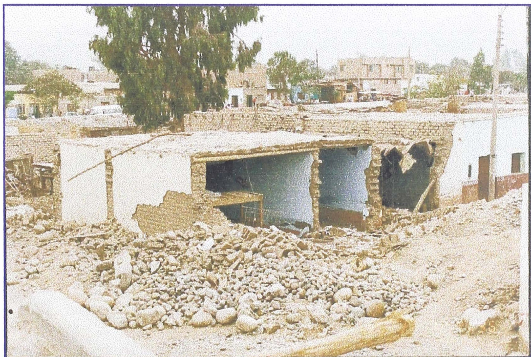
Foto N° 8: Vista panoramica del sector de San Carlos, se observa que practicamente las calles estan intransitables, siendo dificultoso el reparto de agua por calles, sino se opto por reparto de agua por esquinas.
