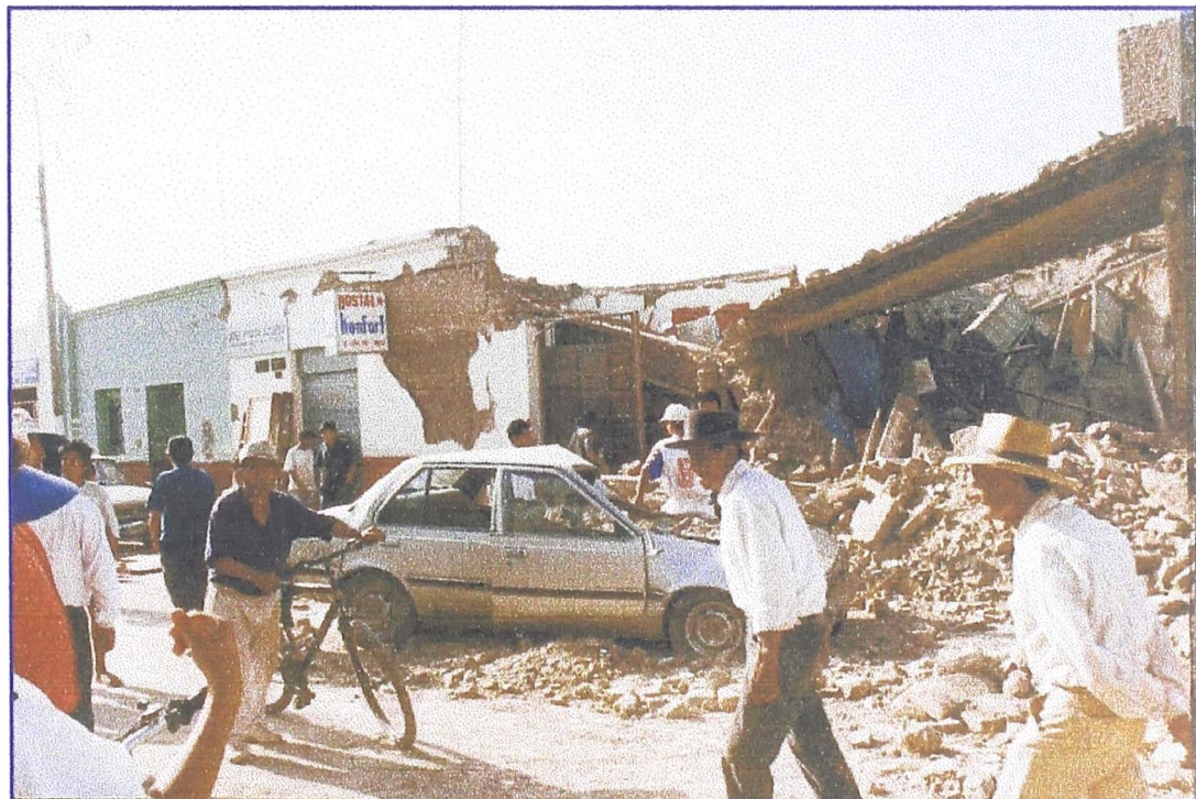
Foto N° 10: Otra vista de la calle Lima, Arteria principal de la ciudad de Nasca, observandose la magnitud de los daños ocasionados por el terremoto.
