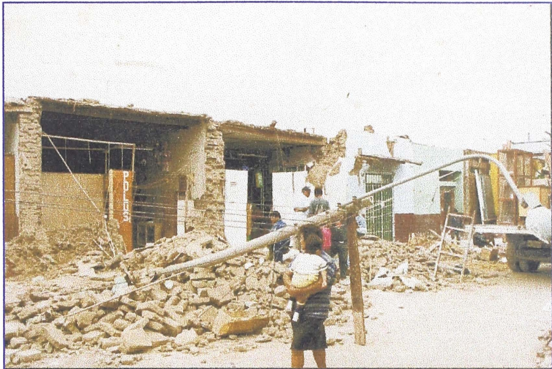
Foto N° 1: Se observa la destrucción de varias casas de adobe incluido poste de alumbrado publico
