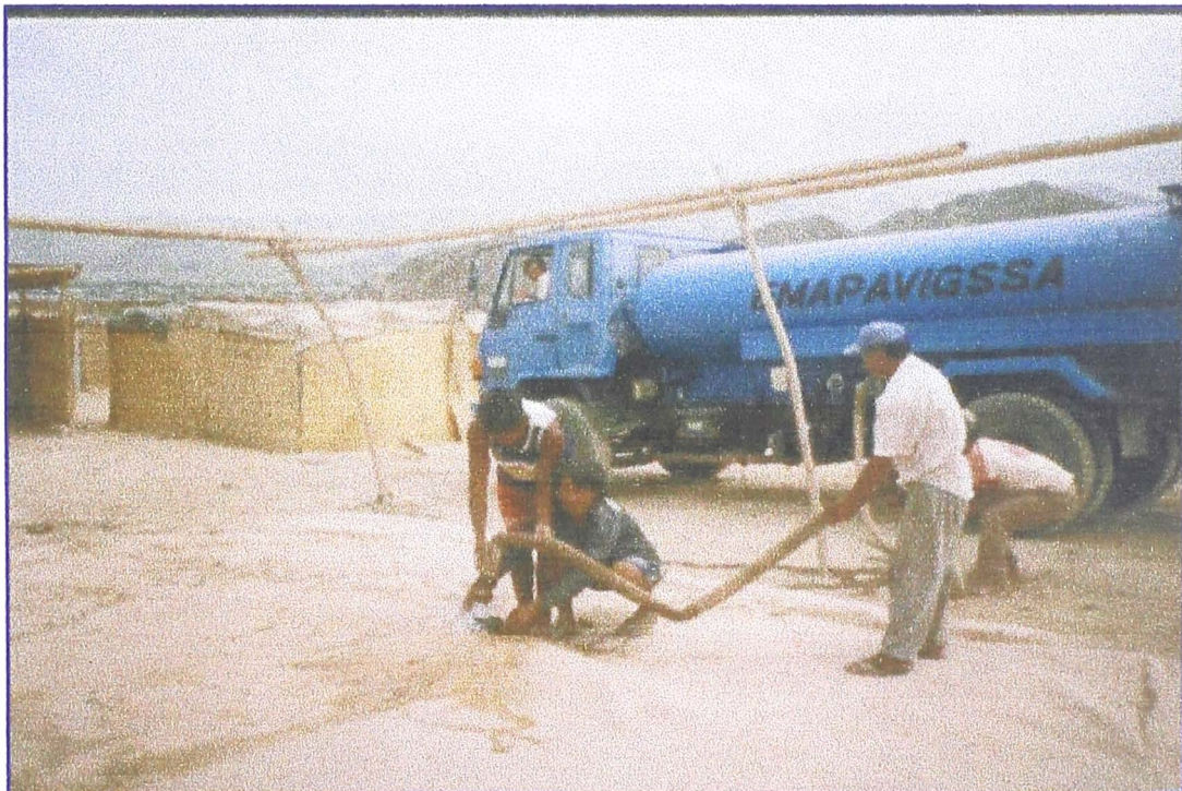
Foto N° 13. Se muestra cómo después del terremoto se abastecía el agua potable por medio de bolsas de PVC de 20M 3 , al cual la EPS de Nasca apoyó diariamente.
