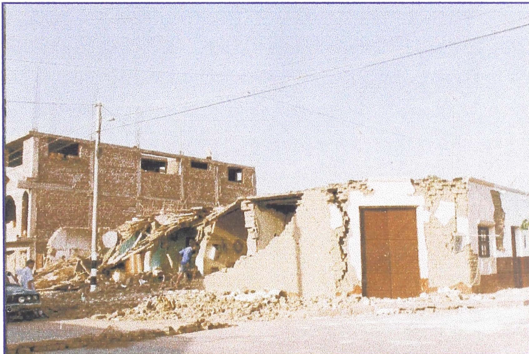
Foto N° 4: Se observa el estado de una de las esquina principal de la calle Fermin Castillo con Juan Mata siedno intransitable las calles para reparto de agua potable por cisternas.
