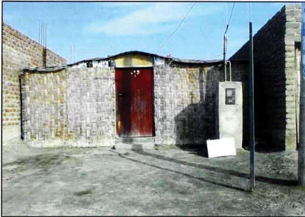
Figura No 4.8 Viviendas provisionales construidas a base de estera y/o madera.
