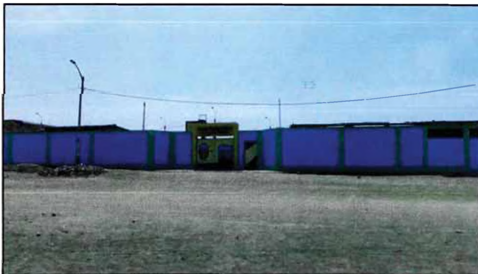
Figura No 4.10 Estructura de concreto armado Centro Educativo I.E.I. 647 – I.E.P No 21003 – San Isidro – Végueta.
