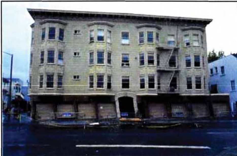
Figura No 4.2 Problema de piso blando (baja rigidez en el piso inferior).
