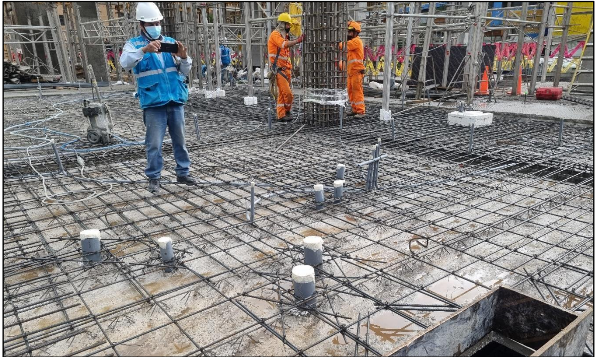
IMAGEN N°9: Para el sistema de desagües, al haberse ejecutado mediante el uso de pre-losas, fue importante determinar la ubicación de los pases a través de estas por donde se instalarán las tuberías de desagües y reforzar estos, antes del colado de concreto.
