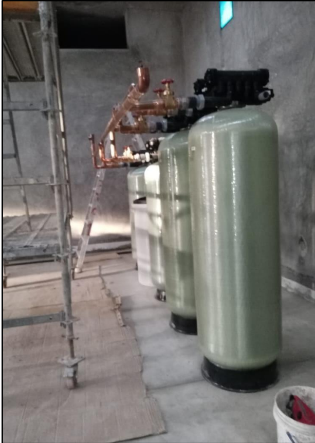
IMAGEN N°17: Se verificó la instalación de los filtros multimedio automático y de los tanques ablandadores automáticos comprobando la correcta instalación de las tuberías de cobre que unen a estas para poder realizar el filtrado del agua dura y poder obtener el agua blanda para el centro de salud.
