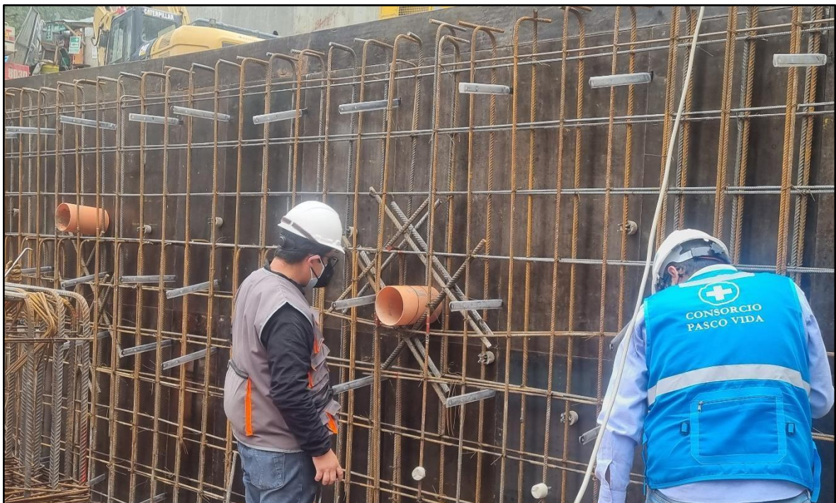
IMAGEN N°10: Al igual que las pre-losas, también se tuvo en consideración la ubicación de los pases a través de los muros de contención, tanto su diámetro y las cotas, de manera que no se tenga inconvenientes al momento de realizar la instalación de las tuberías.
