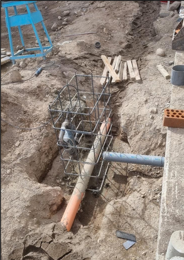
IMAGEN N°13: La instalación de la estructura de acero de una caja de registro tiene que realizarse tal como lo establece los planos, con la profundidad y dimensiones establecidas en los planos sanitarios.
