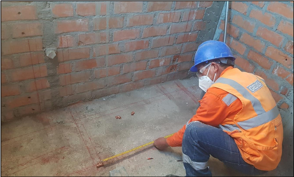
IMAGEN N°1: Para la realizar la instalación de las tuberías de cobre tipo “L” (sistema de agua) es importante medir los tramos en donde se ha proyectado instalar estos, dentro de los ambientes.
