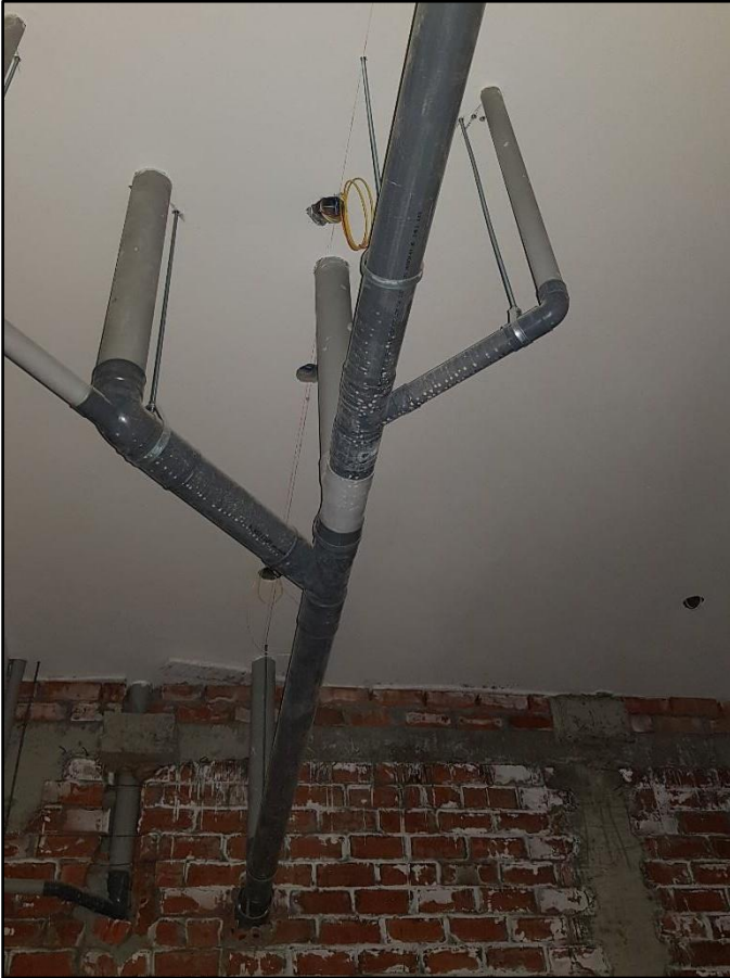
IMAGEN N°11: La instalación de las tuberías de desagües en un centro de salud se realiza de manera colgada, con el uso de colgadores tipo gota de acero pre-galvanizado, verificándose que cada tramo cuente con la pendiente establecida en el Reglamento Nacional de Edificaciones.
