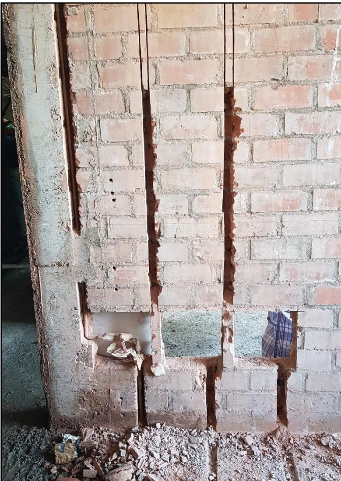
IMAGEN N°1: Para la realizar la instalación de las tuberías de cobre tipo “L” (sistema de agua) es importante medir los tramos en donde se ha proyectado instalar estos, dentro de los ambientes.
