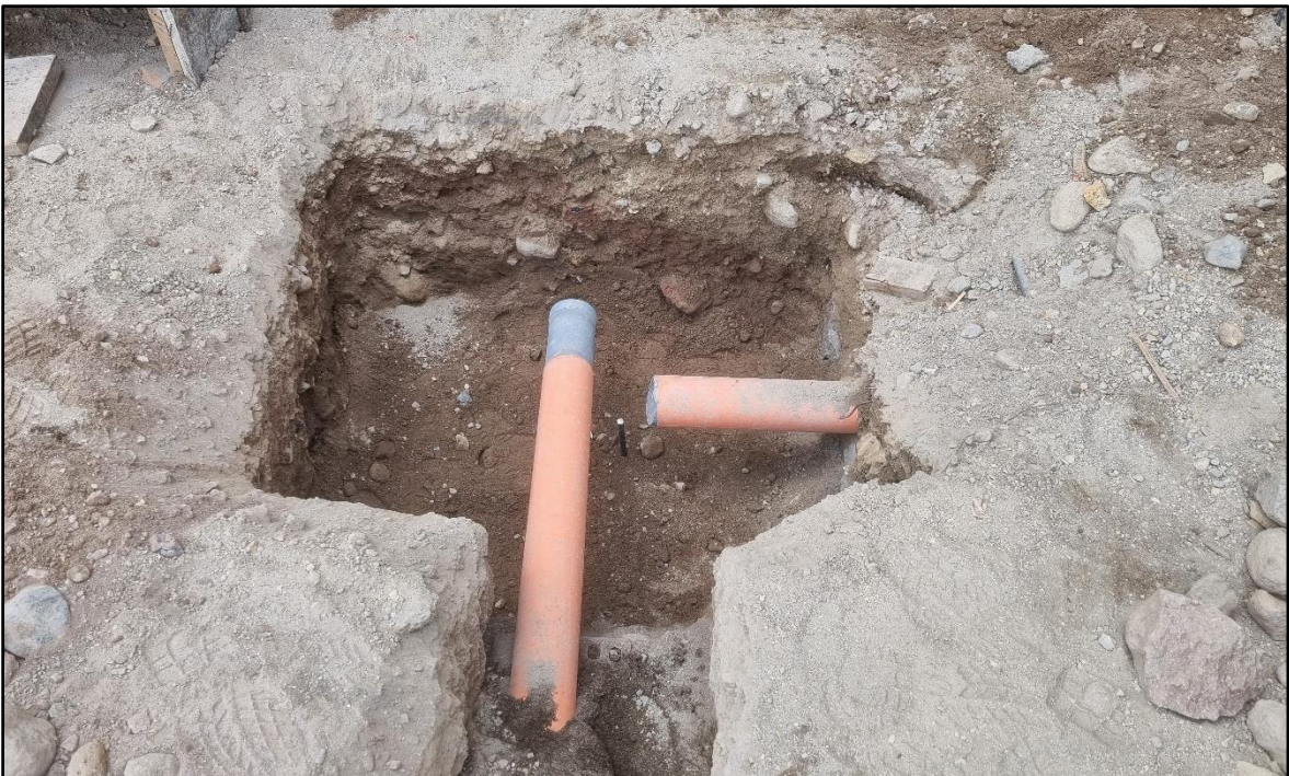
IMAGEN N°12: Para la instalación de la caja de registro el principal dato en campo es la cota de fondo que tiene que ser señalado por el topógrafo, de acuerdo al plano de aprobado, a partir de este punto se realizó la instalación de tuberías.
