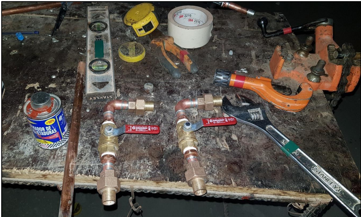
IMAGEN N°3: En la mesa de trabajo se realiza la instalación de segmentos completos del sistema a instalar, como se puede apreciar se realiza el soldado de las tuberías de cobre tipo "L" con las válvulas de bronce y sus respectivas uniones universales.
