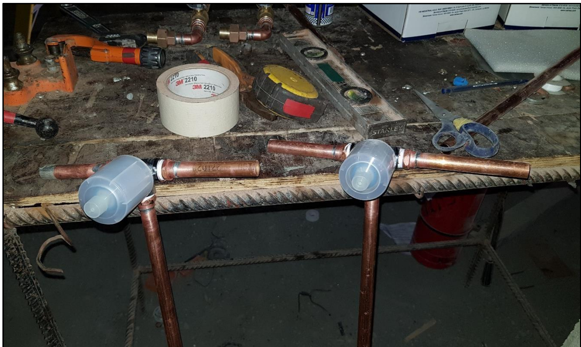
IMAGEN N°4: Para la instalación de tuberías y accesorios se realizará la unión de estas mediante soldadura, para ello se utilizará soldadura de estaño (90%) plata (5%) y cobre (5%), así como fundente para soldar.
