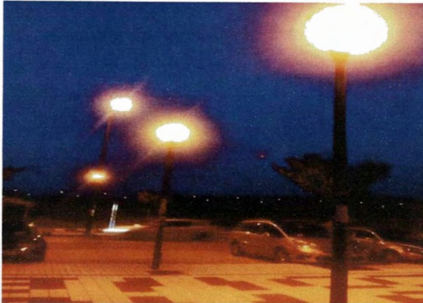
Figura 6. Uso inadecuado de lámparas.
