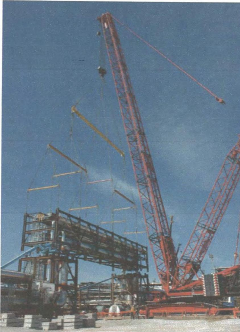
Figura 16: Montaje de módulo con 14 puntos de izaje. [9]
