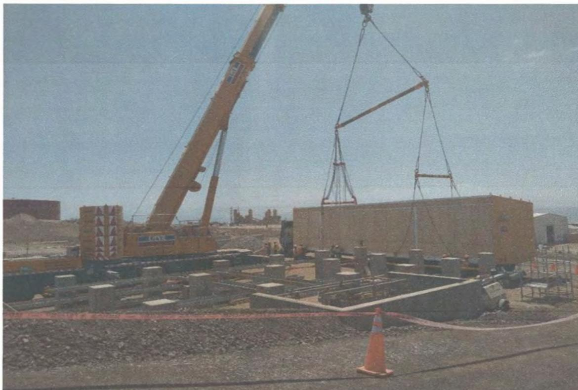
Figura 29: Sala eléctrica modular con 8 puntos de izaje ubicados en su base.
