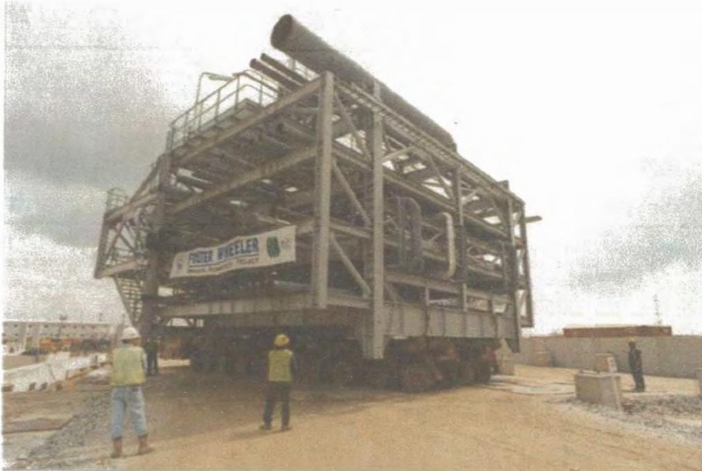
Figura 8: Transporte de modulo mediante remolque modular autopulsado (SPMT). [19]
