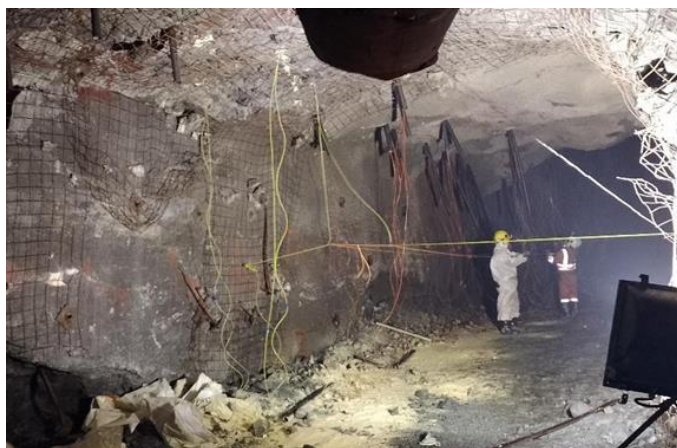
CaVoladura de la chimenea Slot de 2.0 x 2.0 m
