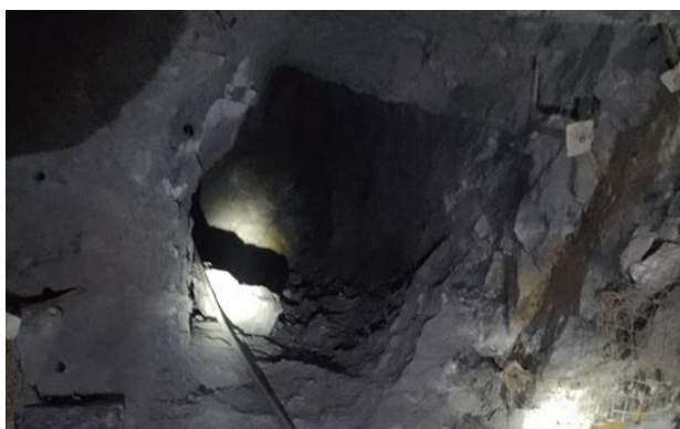
Voladura de la chimenea Slot de 2.0 x 2.0 m
