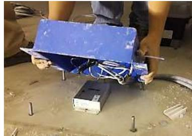
Figura 3.10 Instalación de los sensores ITK-002.
