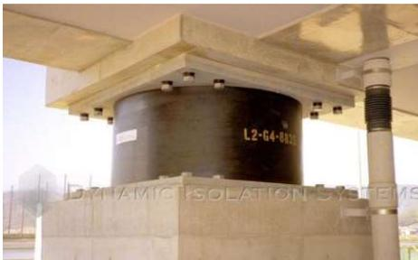
Figura 3.7 Ejemplo de aisladores empleados en el CIIFIC.
