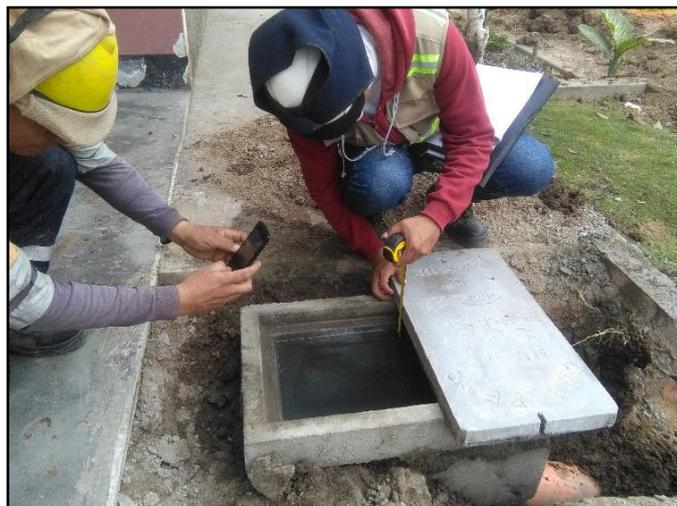
Figura N° 55 Prueba hidráulica en conexiones domiciliarias
