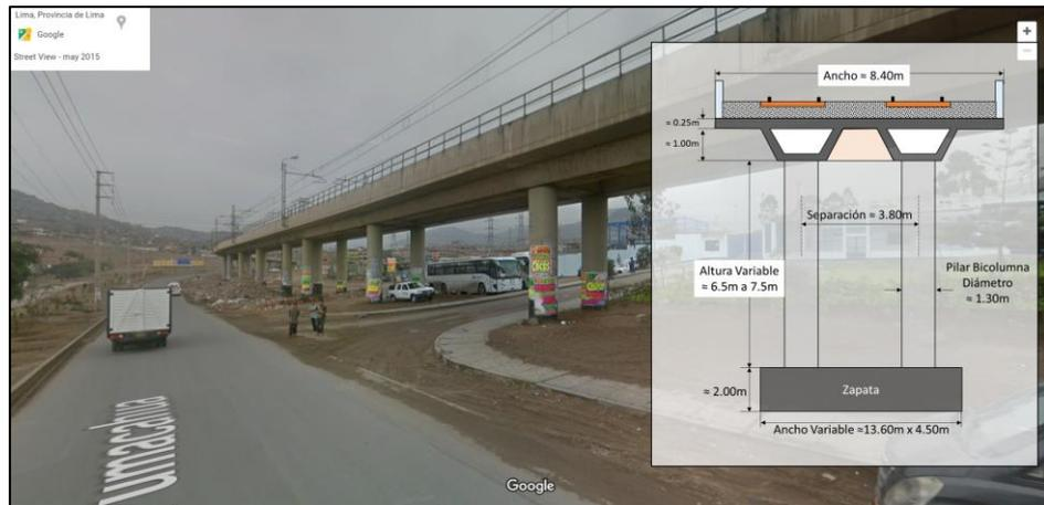
Figura N°25: Esquema del viaducto típico del tramo Antiguo.
