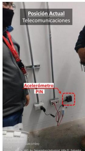
Figura N°85: Fotografía de acelerómetro PIN.
