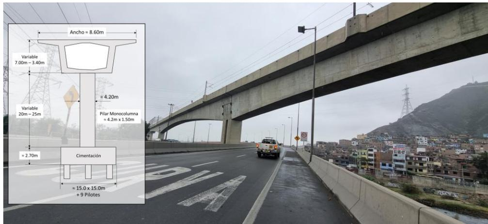
Figura N°32: Fotografía del puente de Vía Evitamiento de la Línea 1.
