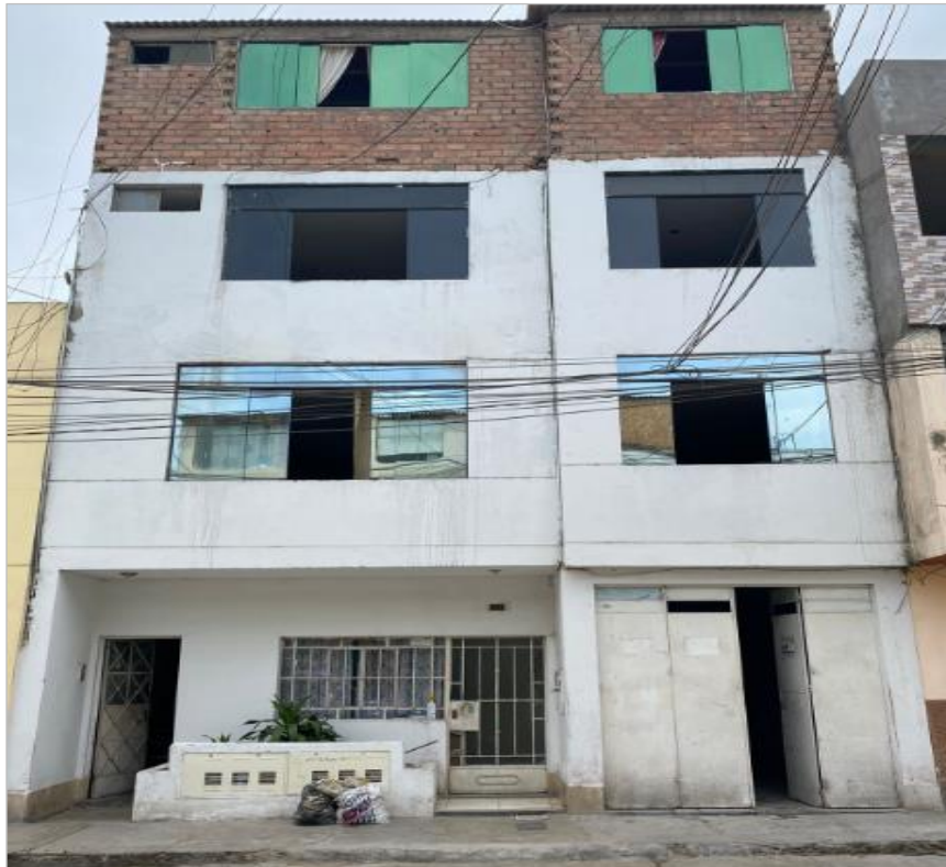
Figura N° 34. Fachada del inmueble.
