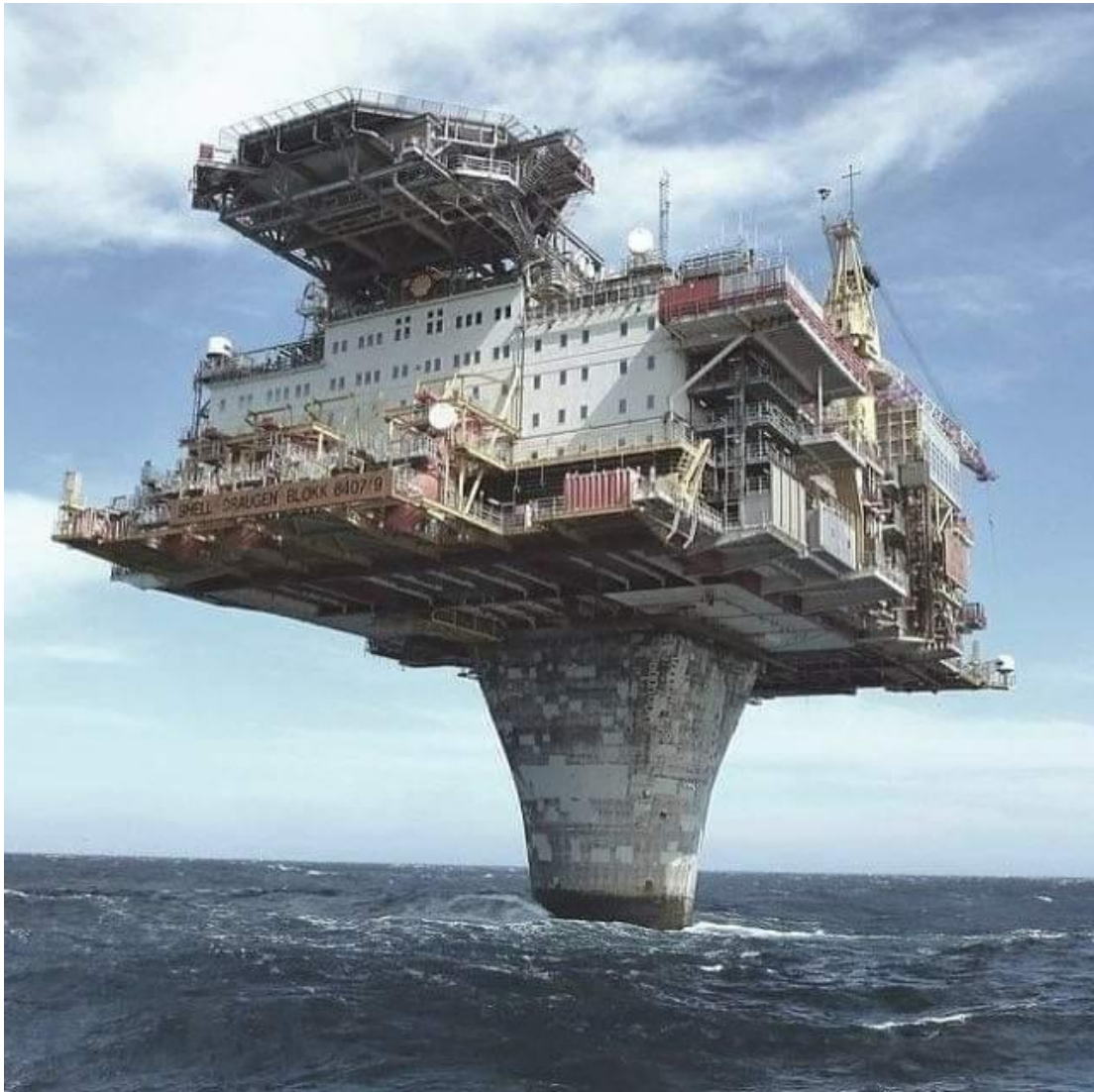
Fotografía 18.-Estructura de concreto armado sometida al ataque de las sales.
