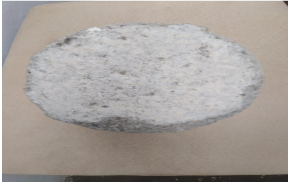
Imagen 10. Desprendimiento de los bordes en el concreto armado
