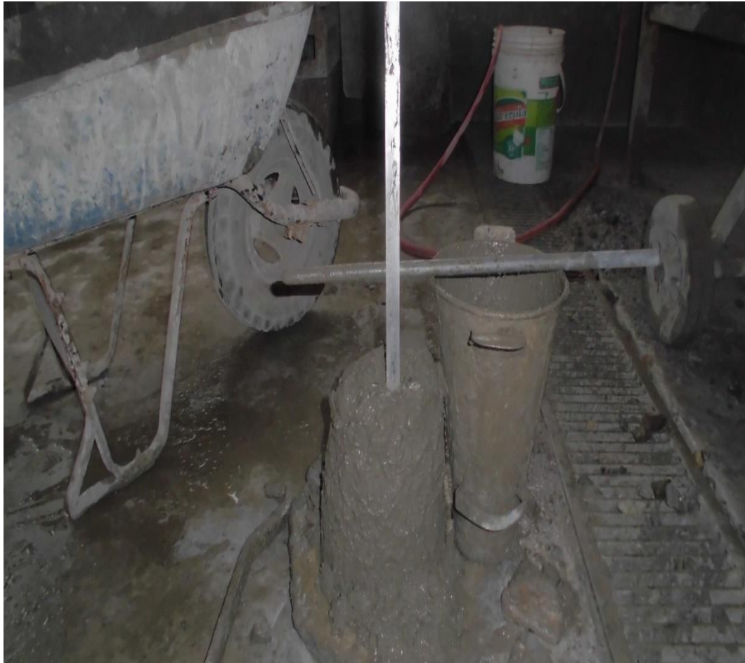
Fotografía 11.-Ensayo de asentamiento. Concreto trabajable (slump 4")
