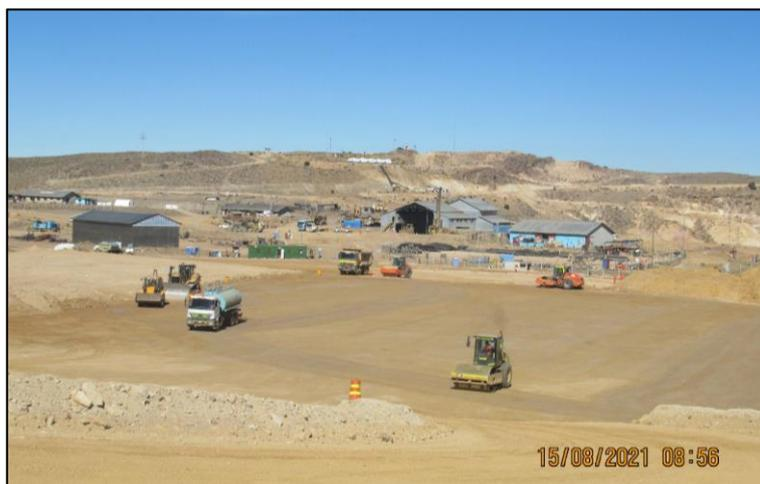
Figura N°67: Movimiento de tierras – relleno con material estructural.
