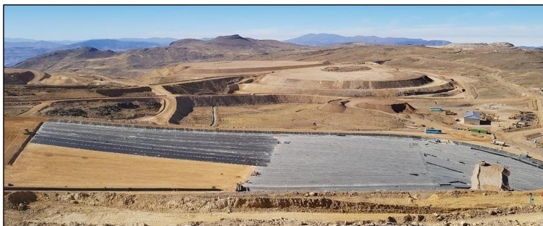
Figura N°69: Sistema de revestimiento – instalación de geomembrana.
