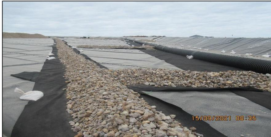
Figura N°70: Sistema de colección de solución.
