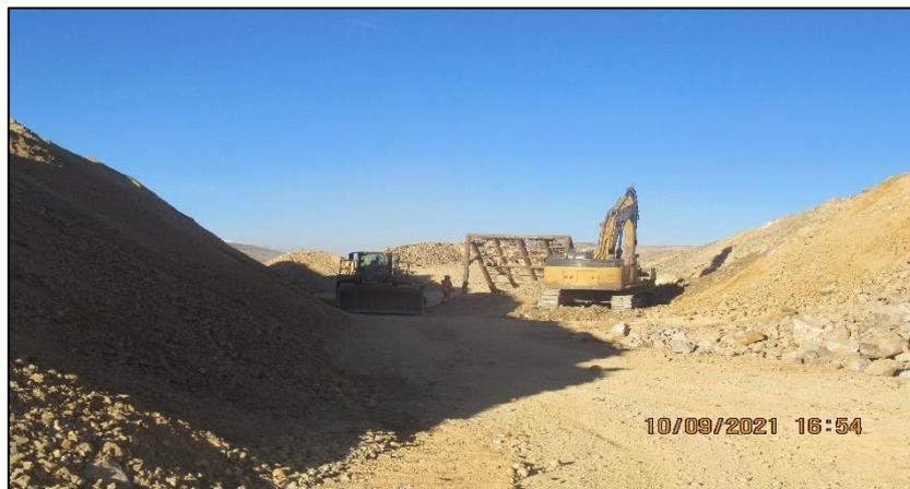
Figura N°71: Sistema de revestimiento – producción de material Over Liner.
