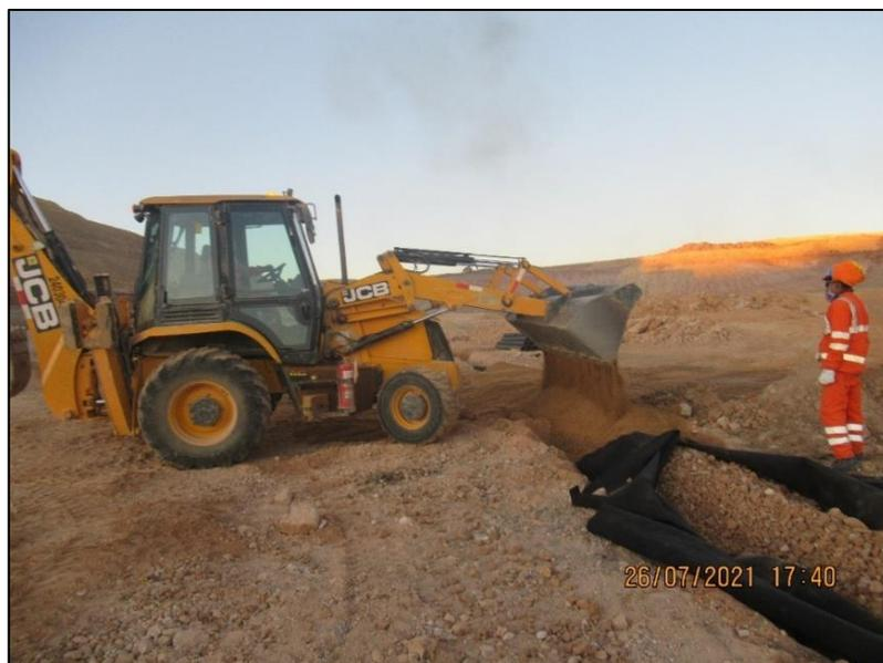
Figura N°31: Colocación de tuberías HDPE para sistema de drenaje.
