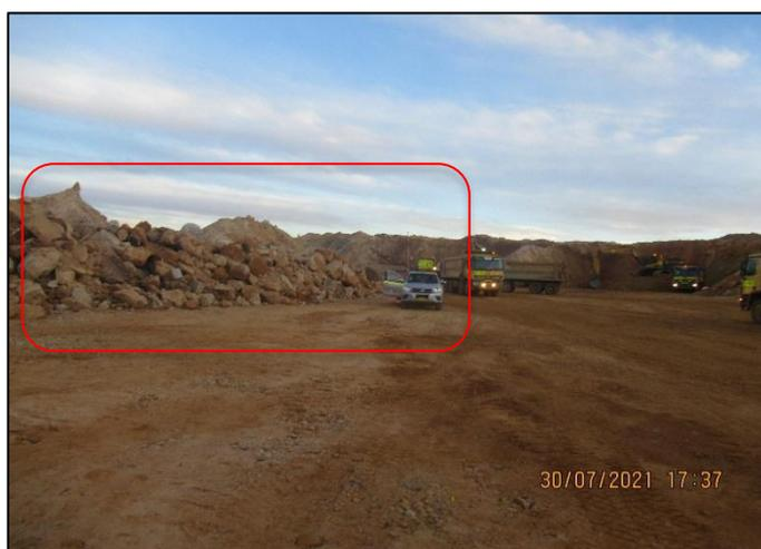
Figura N°26: Presencia de bolonería en material para relleno estructural.
