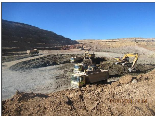
Figura N°11: Movimiento de tierras – trabajos de excavación y eliminación.
