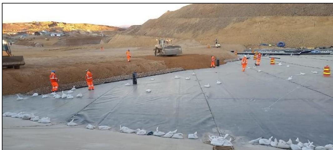
Figura N°72: Sistema de revestimiento – conformación de Over Liner.
