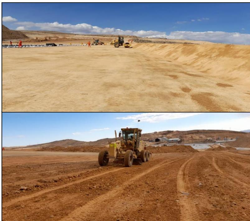
Figura N°68: Sistema de revestimiento – impermeabilización con clay.
