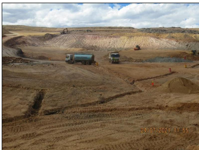
Figura N°30: Trabajos de excavación para sistema de drenaje.
