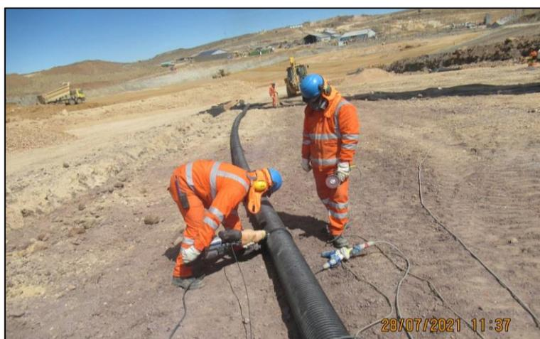
Figura N°66: Sistema de subdrenaje, instalación de tubería HDPE perforada.
