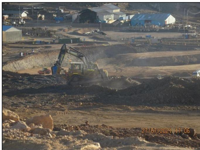
Figura N°25: Excavación de material ripeable.
