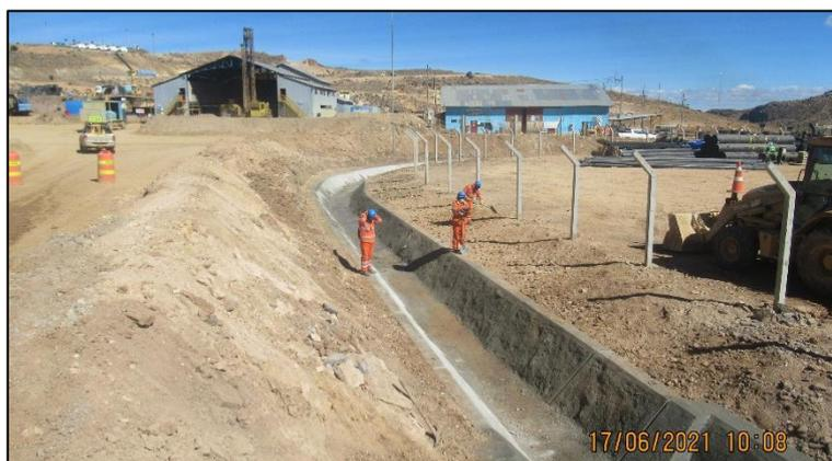
Figura N°63: Obras provisionales – Construcción de canal colector.
