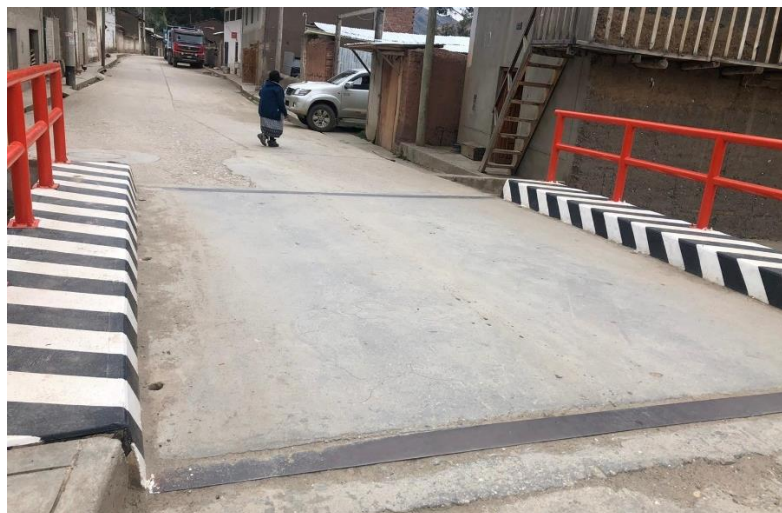
Figura N° 6.26. Puente tipo losa sobre el riachuelo Oshgo Ragra
