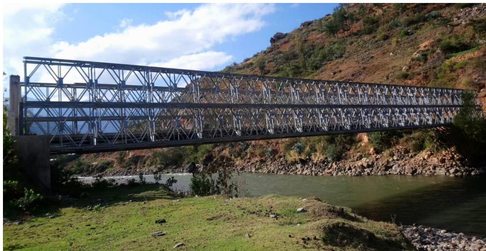
Figura N° 6.25. Puente tipo Bailey que conecta Quivilla con Pachas
