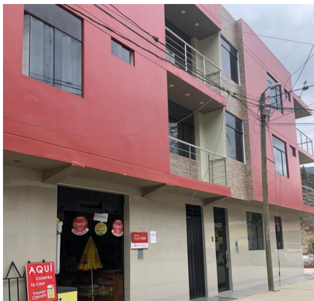
Figura N° 6.39. Hotel en el distrito de Quivilla
