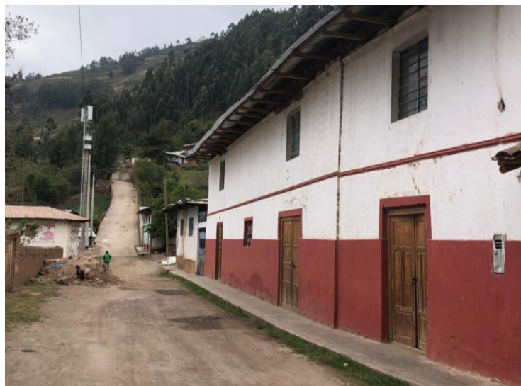
Figura N° 6.3. Viviendas en el Jr. Agustín Gamarra del distrito de Quivilla
