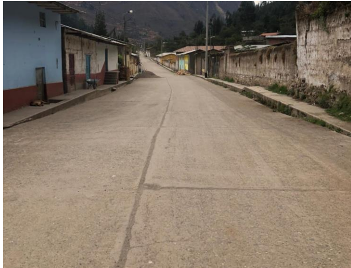
Figura N° 6.21. Tramo con pavimento rígido de la red vial departamental en el barrio de Aynán
