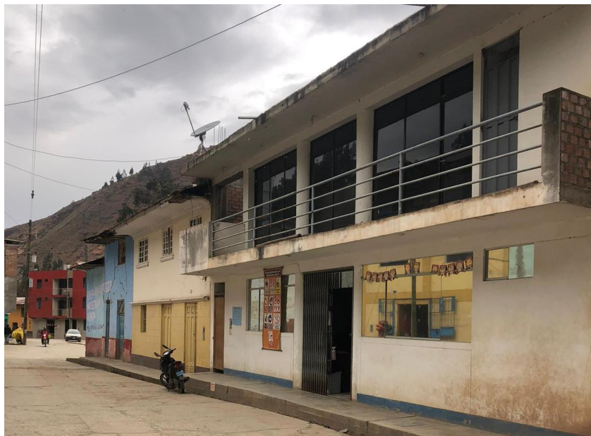
Figura N° 6.9. Local comunal del distrito de Quivilla
