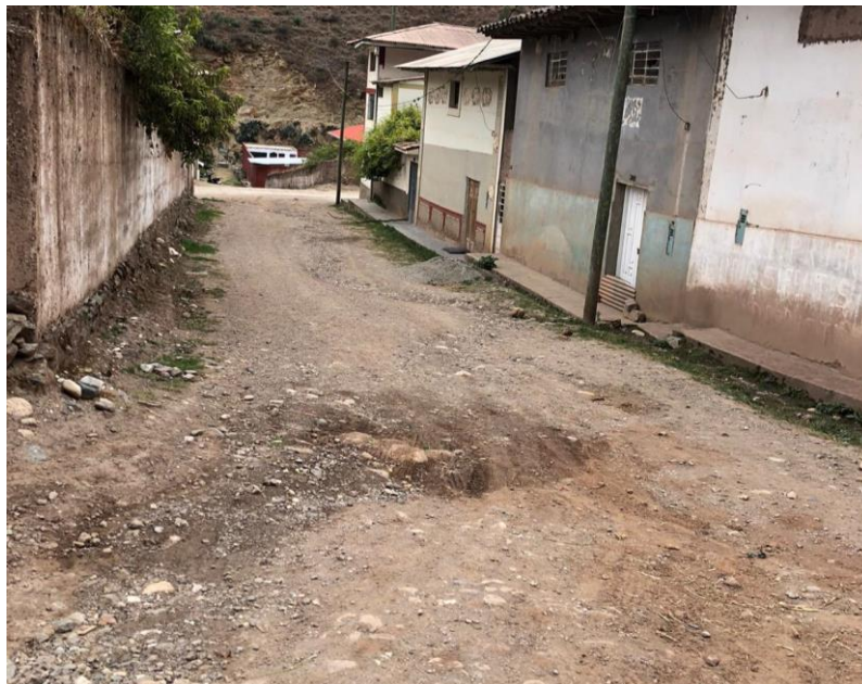
Figura N° 6.24. Tramo de vía del Jr. San Martín
