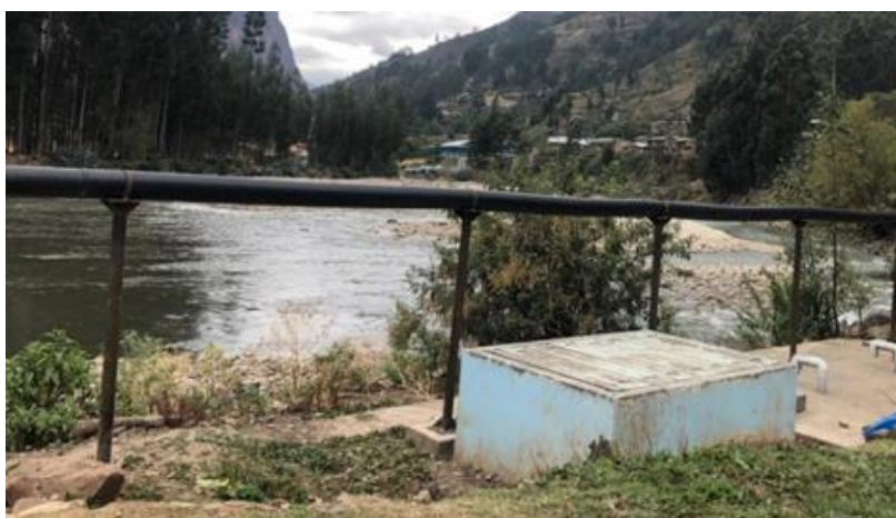
Figura N° 6.28. Alcantarillado del distrito de Quivilla
