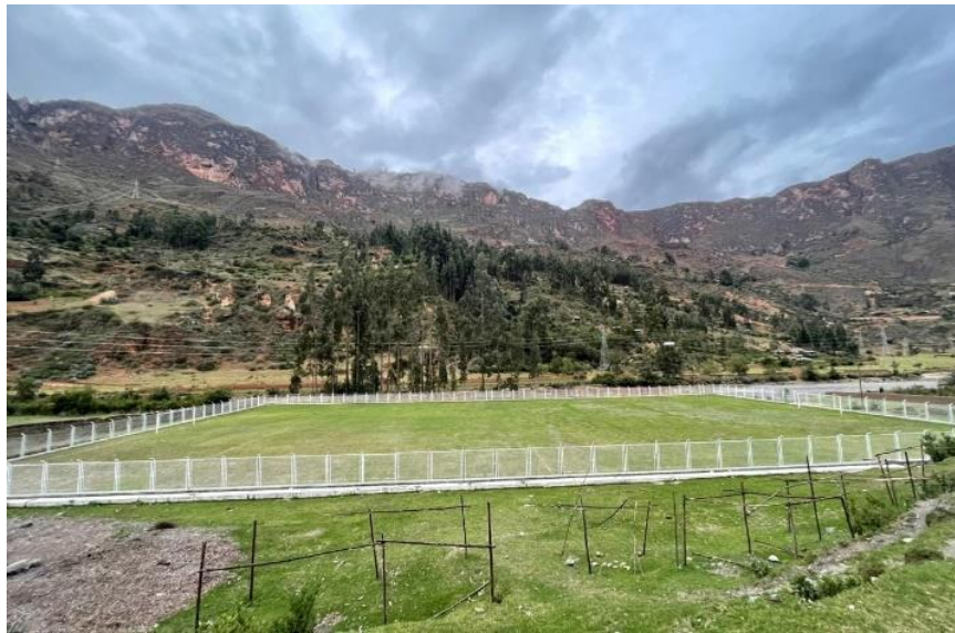
Figura N° 6.10. Estadio de Puka Rumi en el distrito de Quivilla
