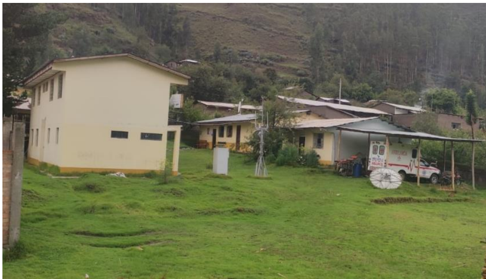
Figura N° 6.12. Patio de la posta del distrito de Quivilla
