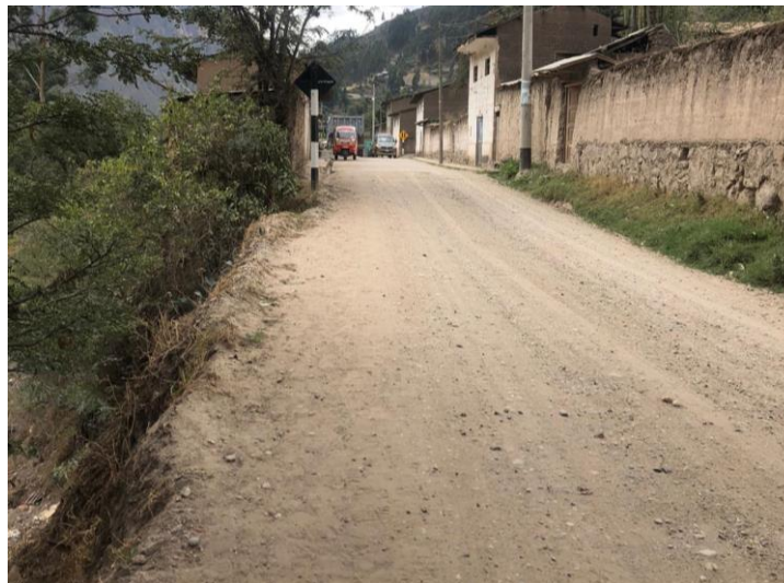
Figura N° 6.22. Tramo con pavimento de afirmado de la red vial departamental
