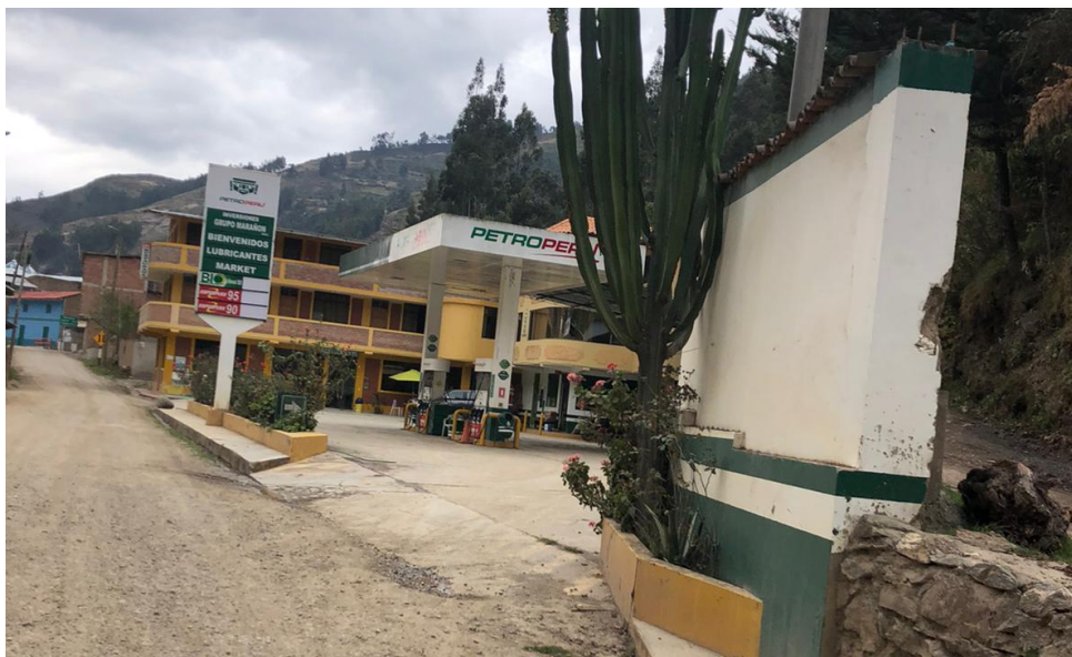
Figura N° 6.5. Grifo en el distrito de Quivilla
