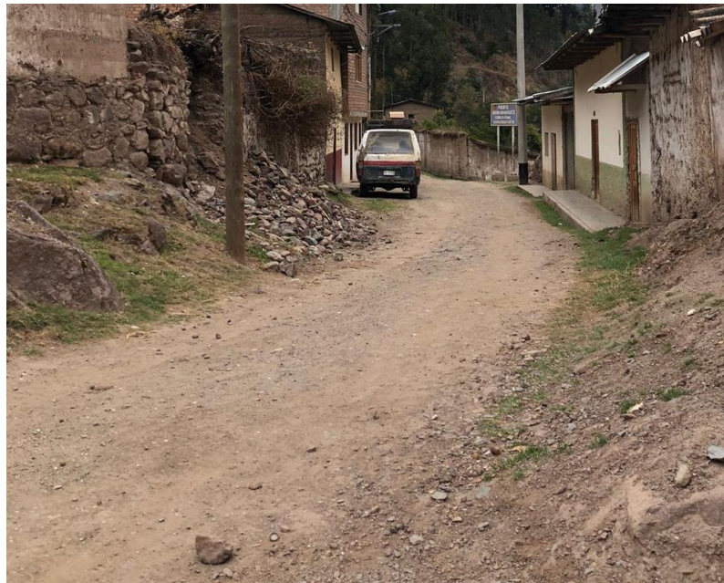
Figura N° 6.23. Tramo de vía del Jr. Agustín Gamarra
