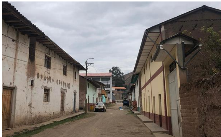
Figura N° 6.2. Viviendas en el Jr. Marañón del distrito de Quivilla
