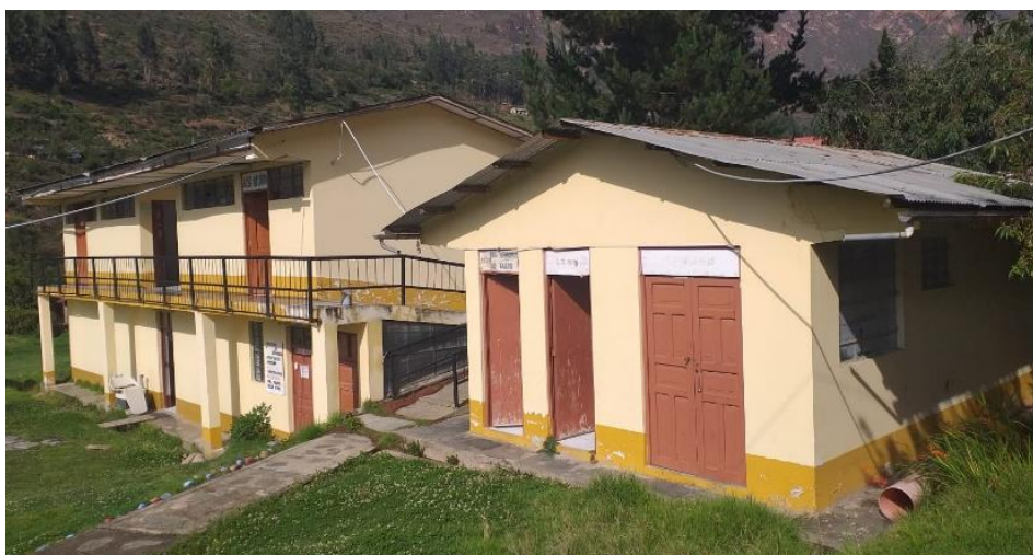
Figura N° 6.34. Pabellón del centro de salud del distrito de Quivilla
