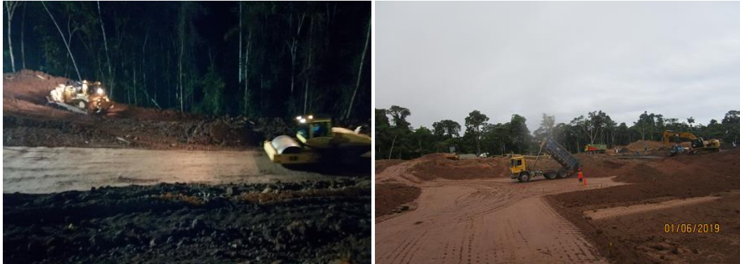
Anexo A.1.26. Corte y Relleno Masivo – Sector A-1 y A5 – Trabajo Diurno y Nocturno
