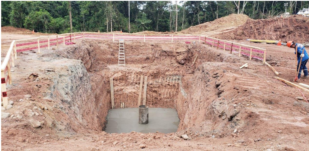
Anexo A.1.54. Vaciado de Solado de Cellar
