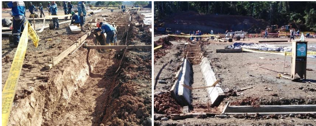
Anexo A.1.46. Canal Externo – Reforzamiento de Taludes
