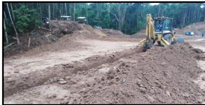
Zanja para tendido de cable de cobre.
