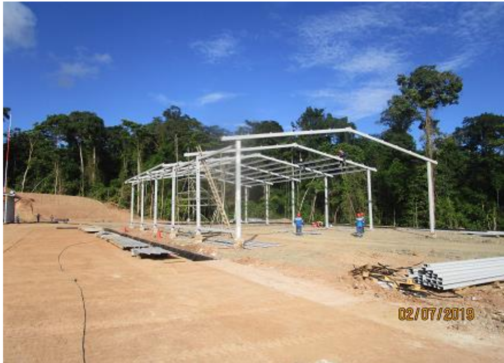
Anexo A.1.64. Montaje e Instalación de Pórticos
