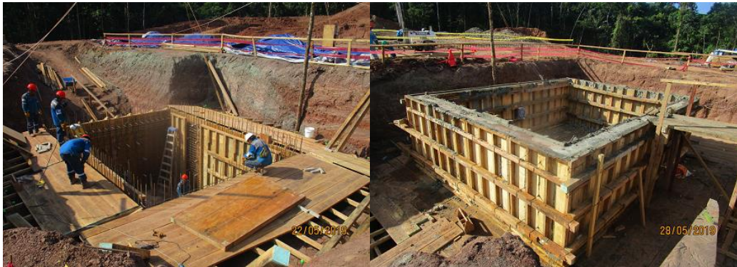
Anexo A.1.35. Obras de Concreto - Cellar
