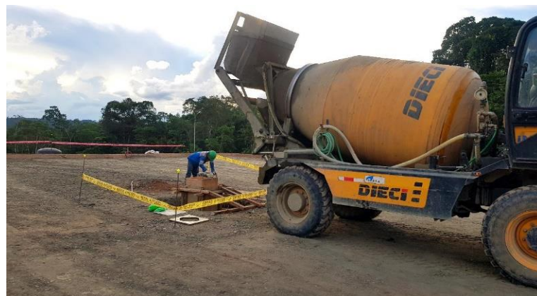
Anexo A.1.41. Vaciado de Pedestales
