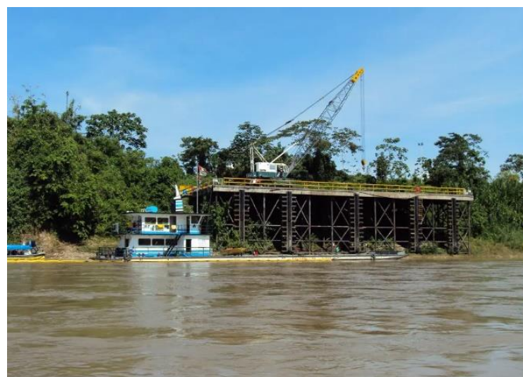
Anexo A.1.5. Carga y Descarga de Equipos y/o Materiales
