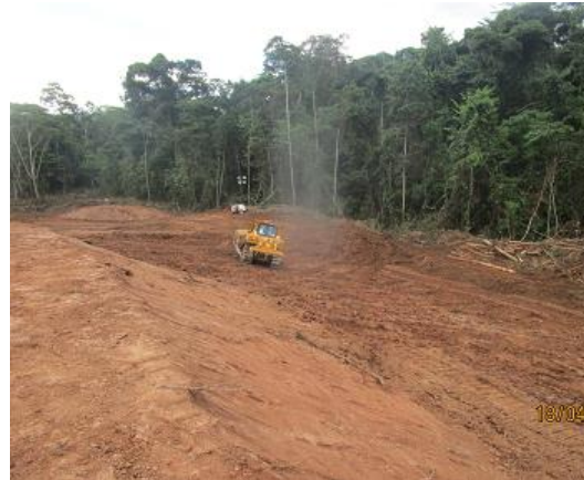
Anexo A.1.16. Retiro y Acopio de Top Soil
