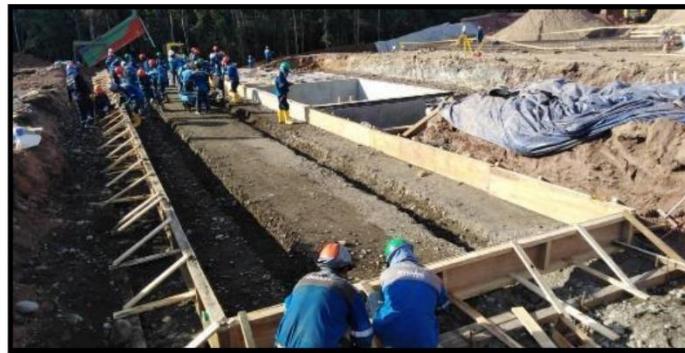
Encofrado de patines en cellar.
