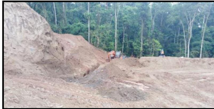
Apertura de zanja para dren francés cuadrante A.8
