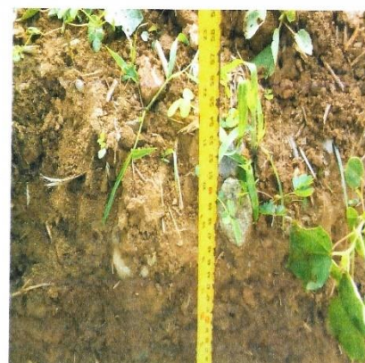
Foto 10: Verificación de profundidad de Zanja, 0.5 metros
