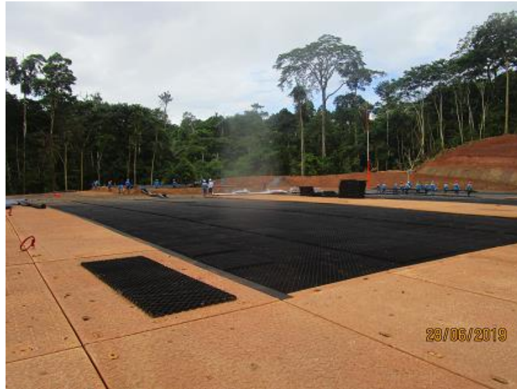
Anexo A.1.61. Instalación de MAT DURABASE y Diamond Grid
