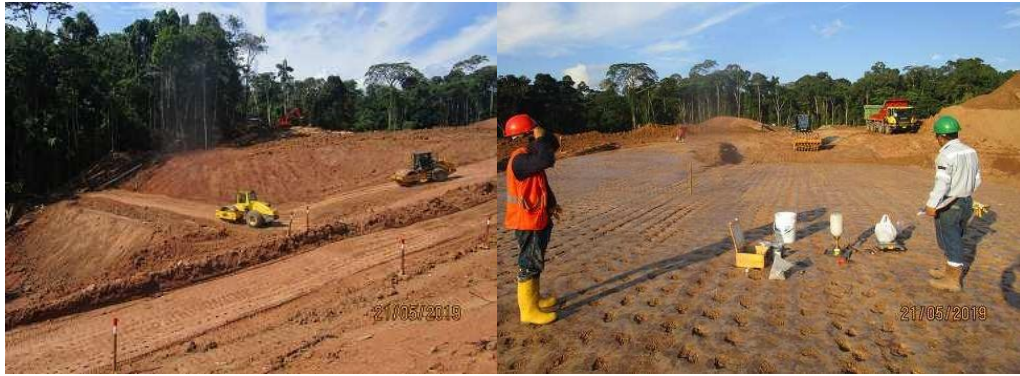
Anexo A.1.22. Relleno Masivo y Pruebas de Densidad de Campo – Sector A-2
