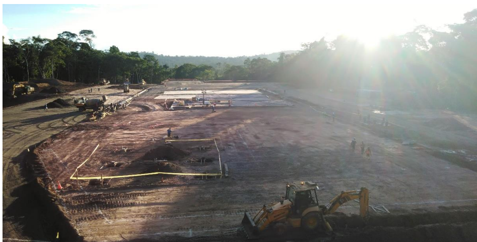
Anexo A.1.28. Vista General de Plataforma Culminada
