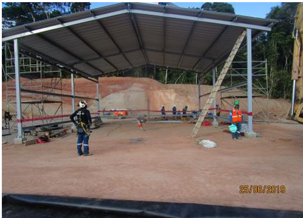
Anexo A.1.65. Instalación de Cobertura de Techo y Lateral
