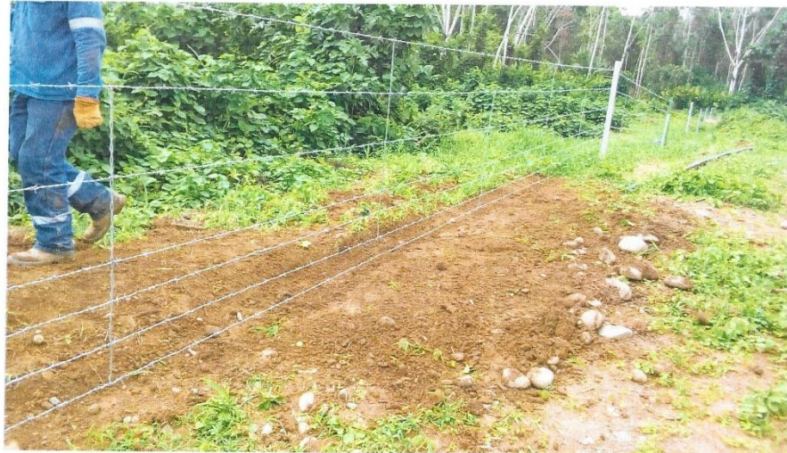
Foto 11: Enterrado y aplanado de superficie donde se encuentra la tubería HDPE 2" con "casing"
