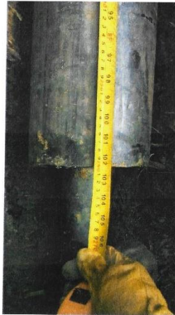
Foto 7: Verificación de longitud "casing" 2.6 metros.
