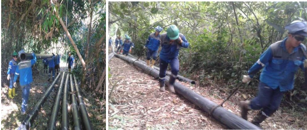
Anexo A.1.78. Desfile de Tuberías y Soldadura por Extrusión
