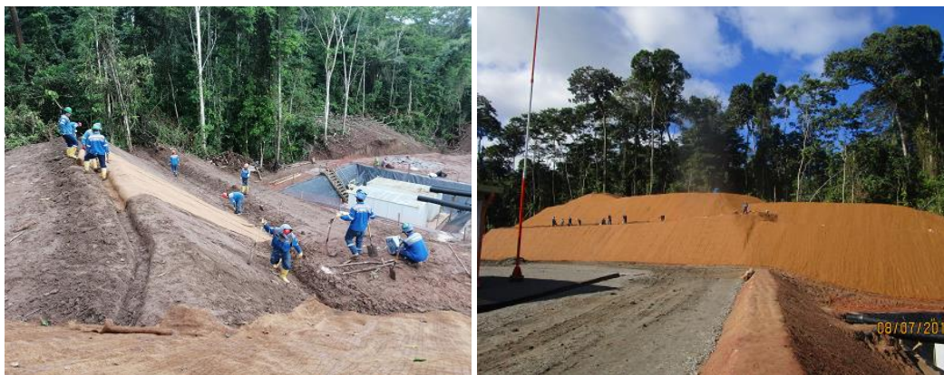
Anexo A.1.77. Instalación de Geomanta de Coco
