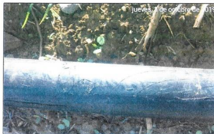
Figuras 3 y 4: Daños superficiales (ralladuras) de la tubería HDPE Ø2"
