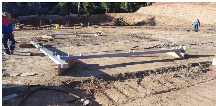
Anexo A.1.63. Armado de Pórticos y Pre Montaje
