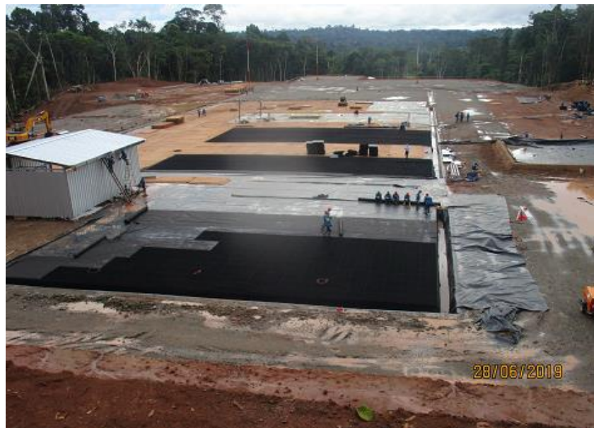
Anexo A.1.62. Vista de Trabajos de Acabados en Superficie
