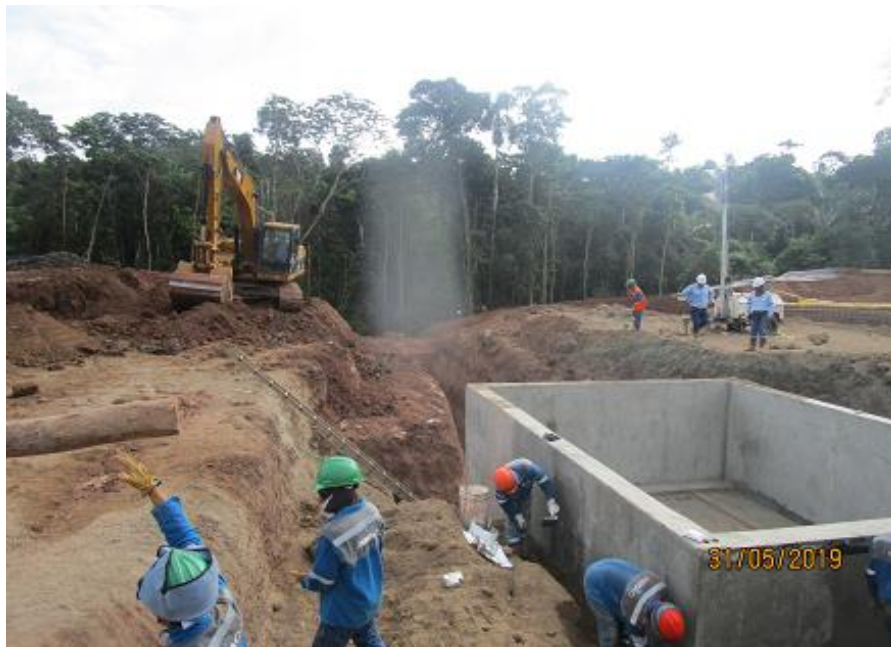
Anexo A.1.36. Desencofrado - Cellar
