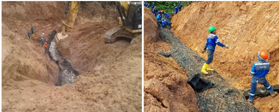
Anexo A.1.73. Construcción de Drenes Franceses
