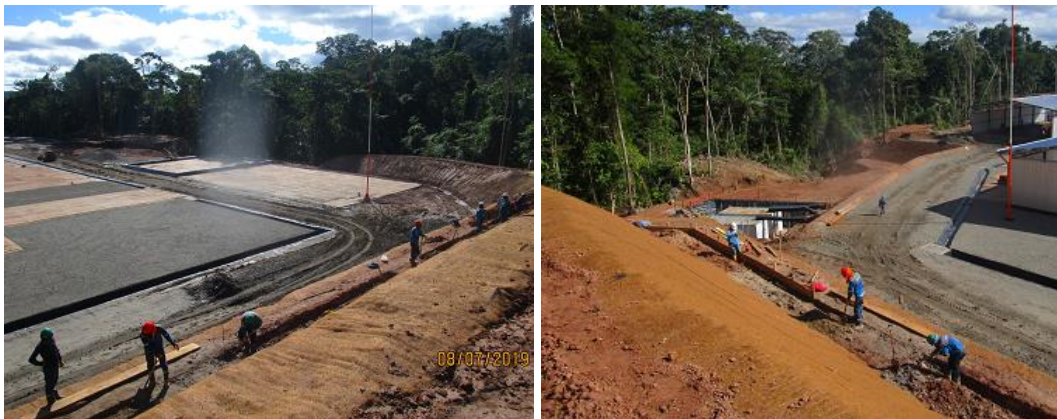
Anexo A.1.76. Construcción de Trincheras y Acueductos
