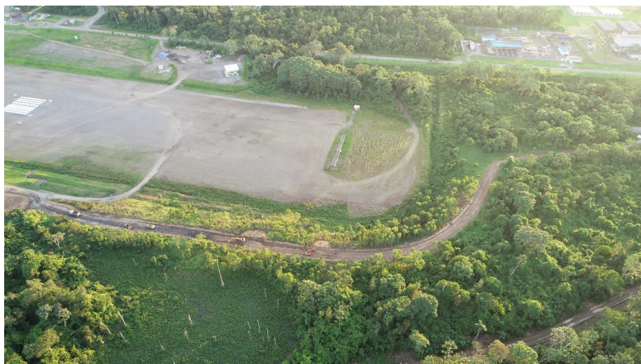
Anexo A.1.34. Vista Área de los Accesos de Ingreso a la Plataforma
