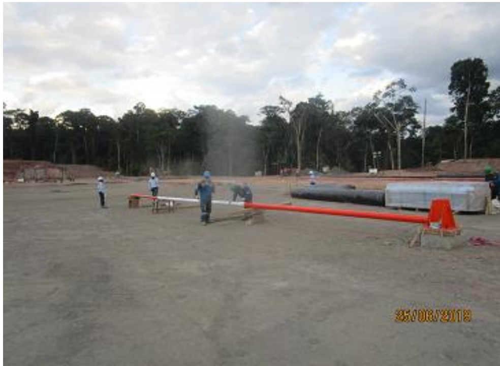
Anexo A.1.68. Instalación de Postes para Montaje
