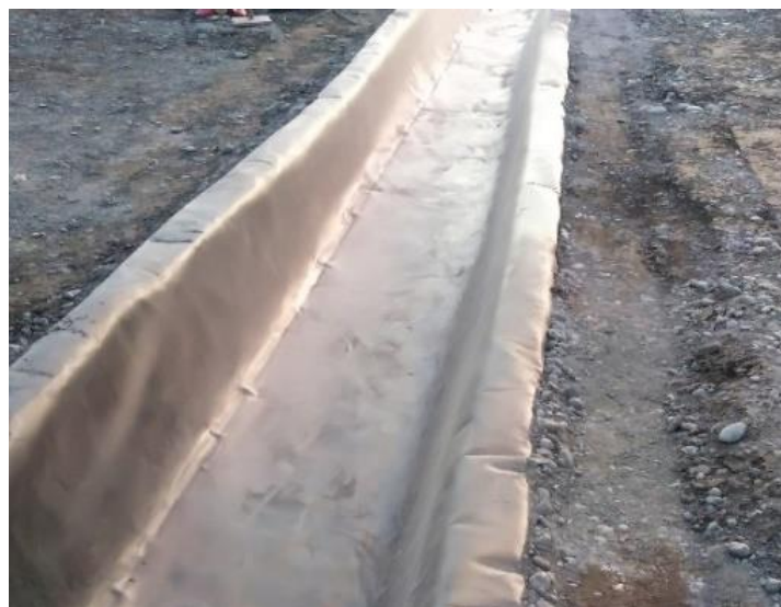
Anexo A.1.47. Canal Externo – Recubrimiento con Geomembrana
