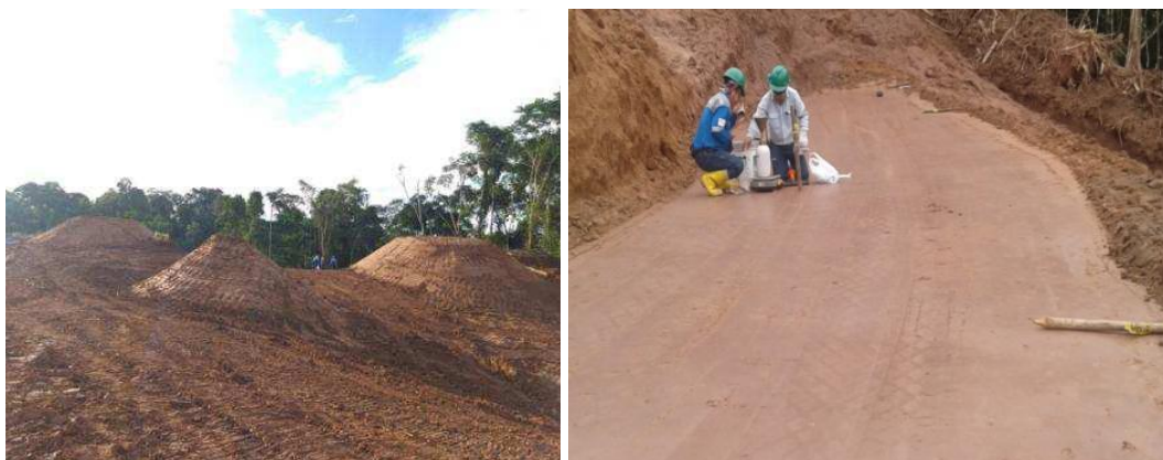
Anexo A.1.21. Acopio de Material para Relleno y Pruebas de Densidad de Campo – Sector A-8
