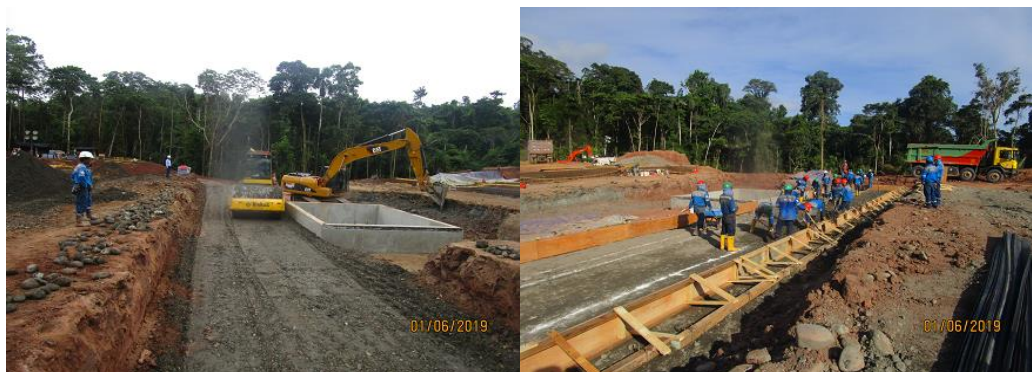
Anexo A.1.37. Mejoramiento de Fondo de Cimentación y Encofrado – Losas del Taladro
