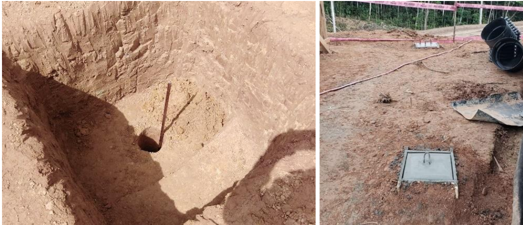
Anexo A.1.72. Pozos a Tierra
