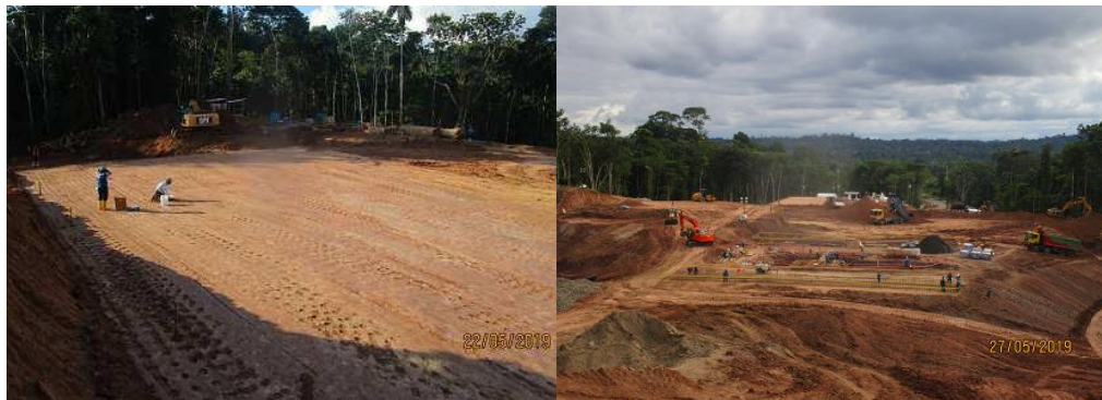
Anexo A.1.24. Corte y Relleno Masivo – Sector A-6, A-7 y A-10
