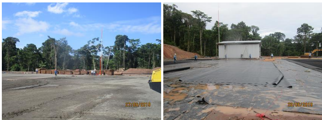
Anexo A.1.59. Mejoramiento de Suelo y Tendido de Geomembrana
