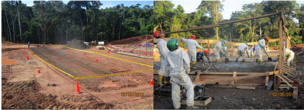
Anexo A.1.38. Vaciado – Losas del Taladro
