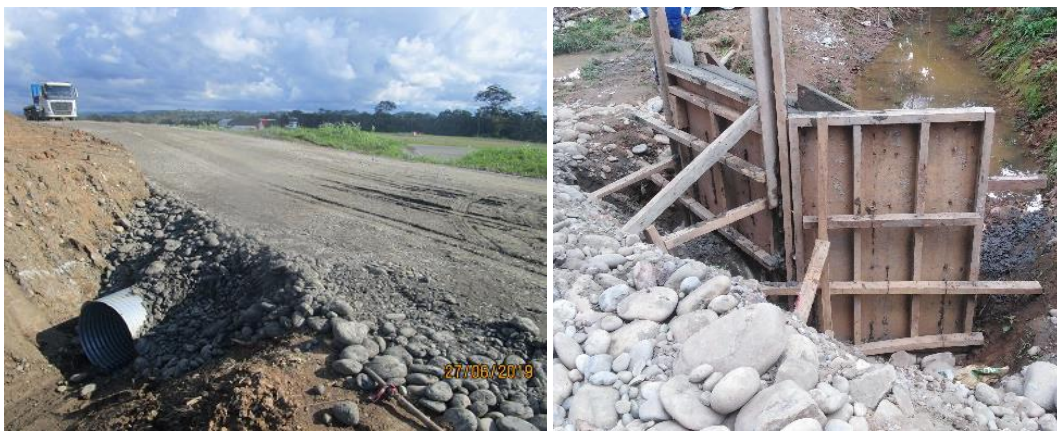
Anexo A.1.52. Instalación y Construcción de Alcantarillas - Accesos
