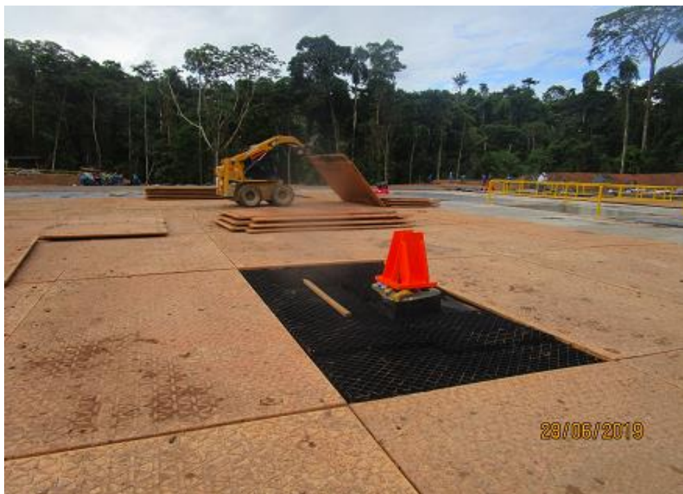
Anexo A.1.67. Instalación de Base de Pararrayos
