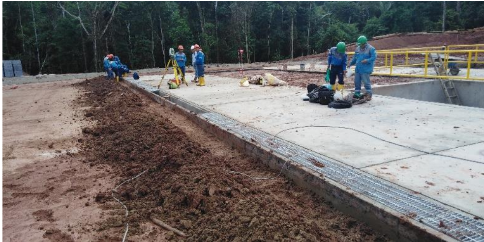
Anexo A.1.45. Canal Interno para Zona de Perforación – Instalación de Matting
