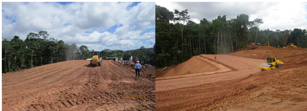
Anexo A.1.25. Corte y Relleno Masivo – Sector A-6, A-7 y A-10
