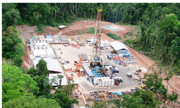
Figura 3. Locación Exploratoria - Lote 57
