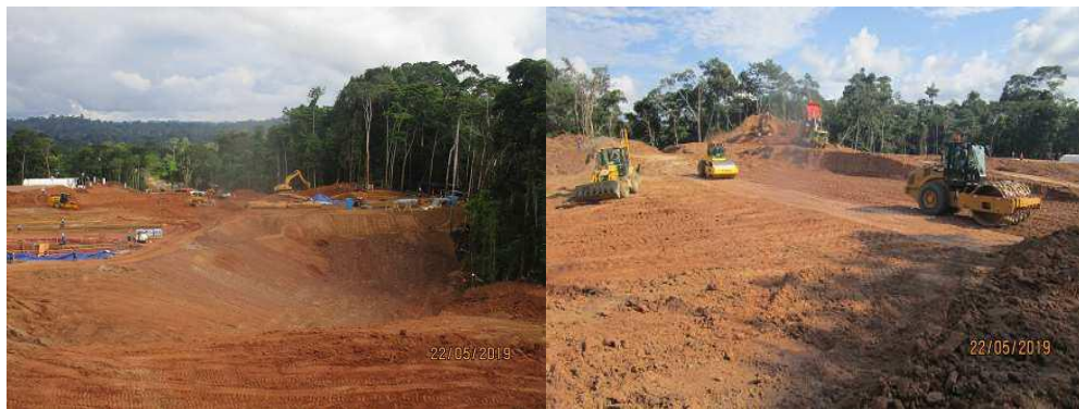
Anexo A.1.23. Corte y Relleno Masivo – Sector A-3 y A-4
