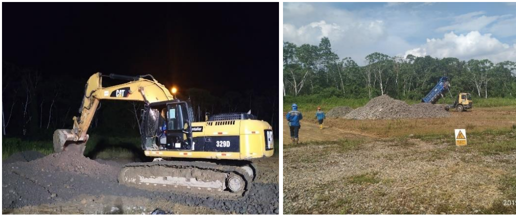
Anexo A.1.19. Zona de Acopio Plataforma 1006
