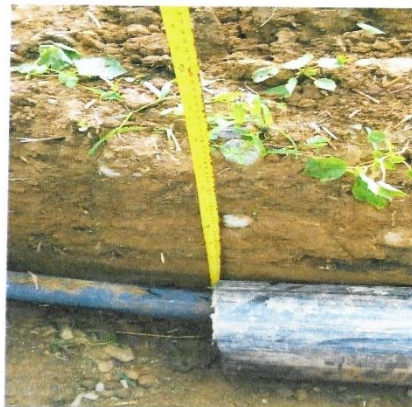
Foto 9: Verificación de Profundidad de zanja, 0.5 metros.
