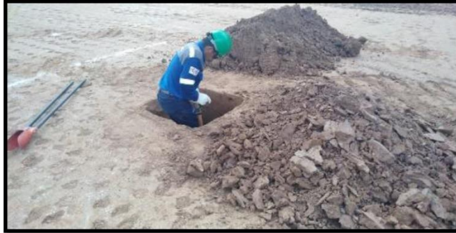
Cavado para pozo a tierra.
