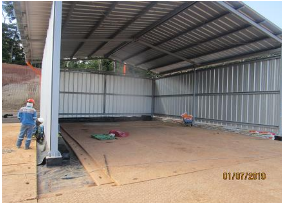
Anexo A.1.66. Vaciado de Grouting
