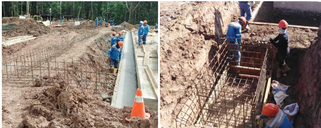
Anexo A.1.43. Canal Interno para Zona de Perforación
