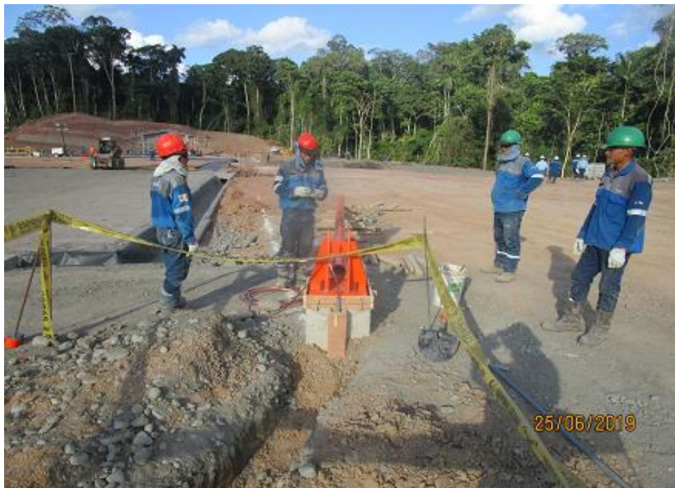
Anexo A.1.69. Vaciado de Grouting
