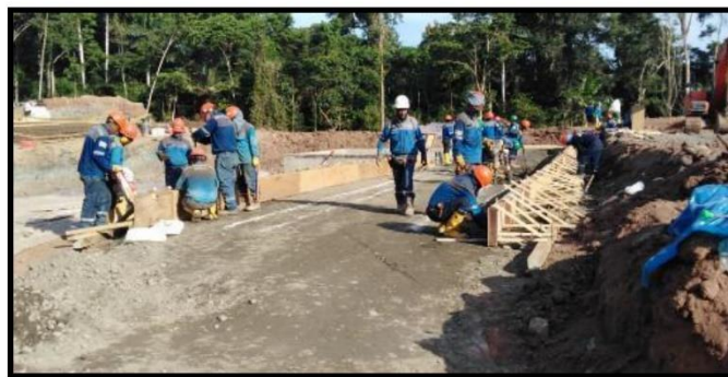
Encofrado de patín para cellar
