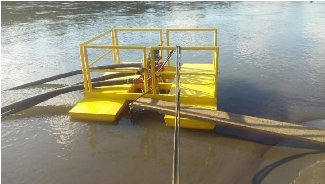
Anexo A.1.84. Pontón de Captación
