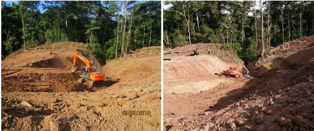
Anexo A.1.51. Encausamiento de aguas superficiales
