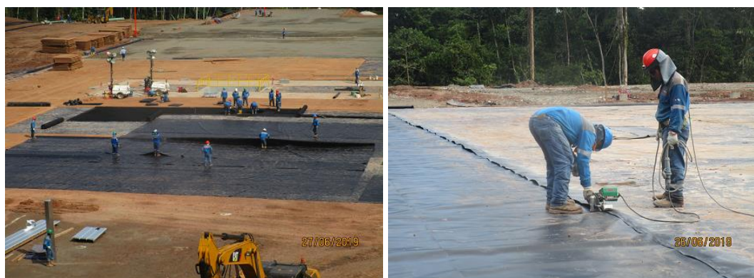
Anexo A.1.60. Tendido y Soldadura de Geomembranas
