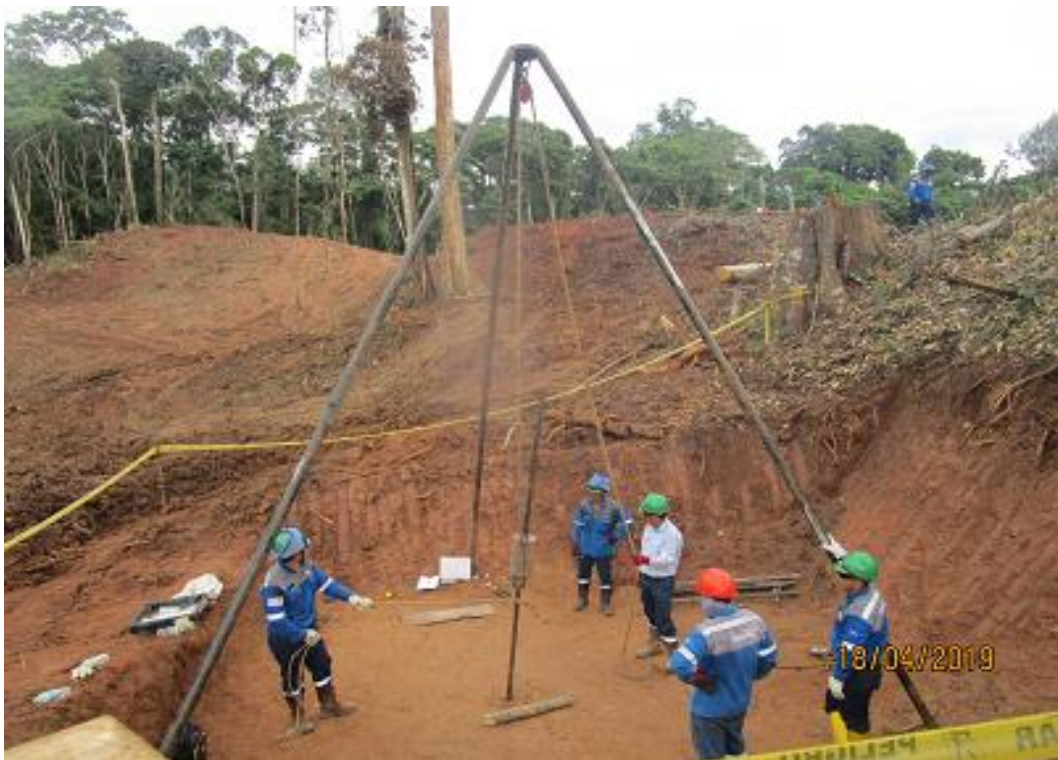
Anexo A.1.2. Estudios Complementarios – Ensayo SPT
