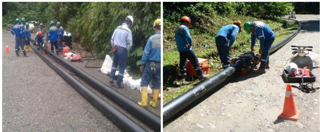
Anexo A.1.79. Capacitación de Personal y Desfile de Tuberías
