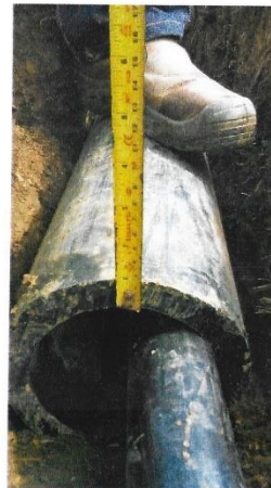
Foto 8: Verificación de espesor "casing" 22mm.
