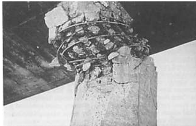
Figura 2.12. Falla por corte dentro de la región plástica. Sismo de San Fernando de 1971 (Priestley et al., 1996)
