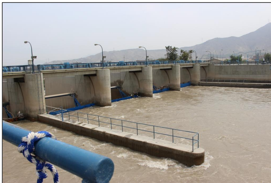
Figura 2.2 Obra de captación (bocatoma del río Rímac) de la Planta de Tratamiento de Agua Potable La Atarjea (PTAP La Atarjea). Fuente: (Kuroiwa, 2017).
