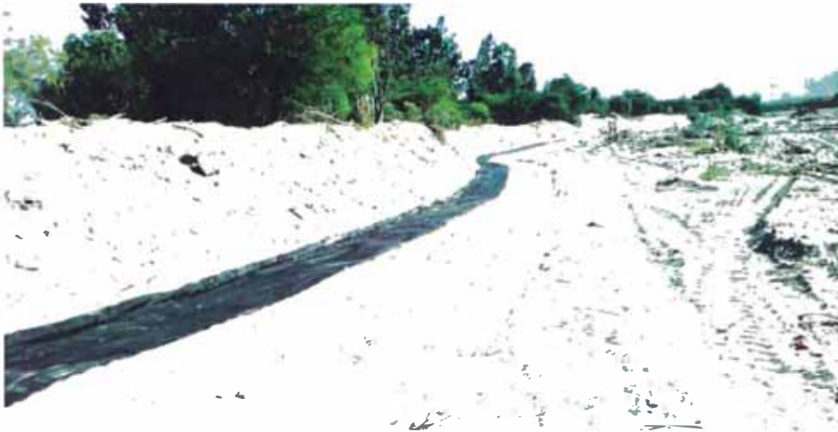
Figura N°3.9 Tendido del geotextil de separación para el primer nivel de geocontenedores. Fuente, Cortesía de Andex del Norte.
