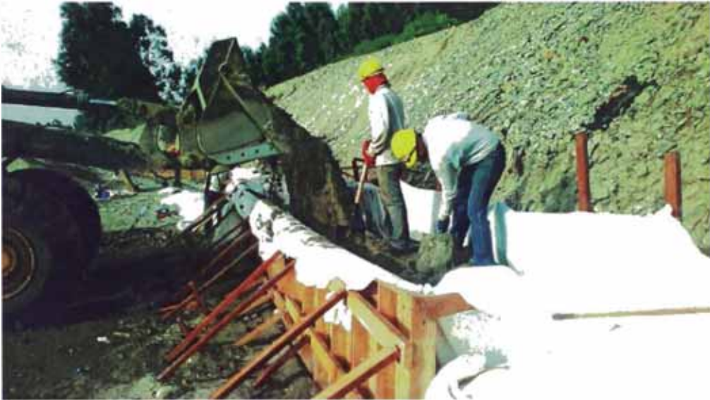
Figura N°3.13 Llenado de geocontenedor con maquinaria pesada. Fuente, Cortesía de Andex del Norte.
