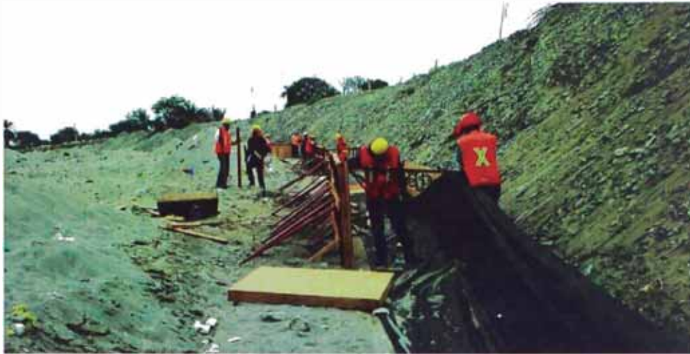
Figura N°3.11 Habilitado de encofrado de madera. Fuente, Cortesía de Andex del Norte.
