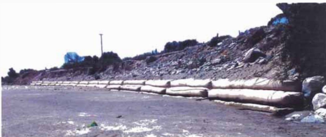
Figura N°4.1 Vista del Tramo I desde aguas abajo, Cortesía de Andex del Norte.
