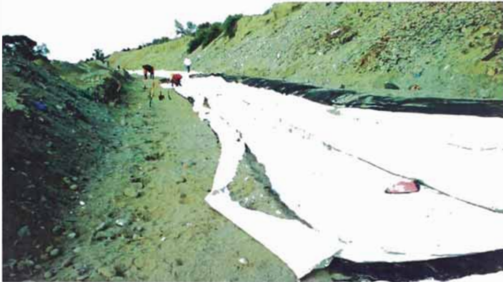
Figura N°3.15 Habilitado del manto antisocavante. Fuente, Cortesía de Andex del Norte.
