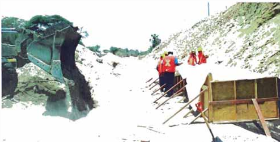
Figura N°3.12 Habilitado de geocontenedor vacío con encofrado de madera. Fuente, Cortesía de Andex del Norte.
