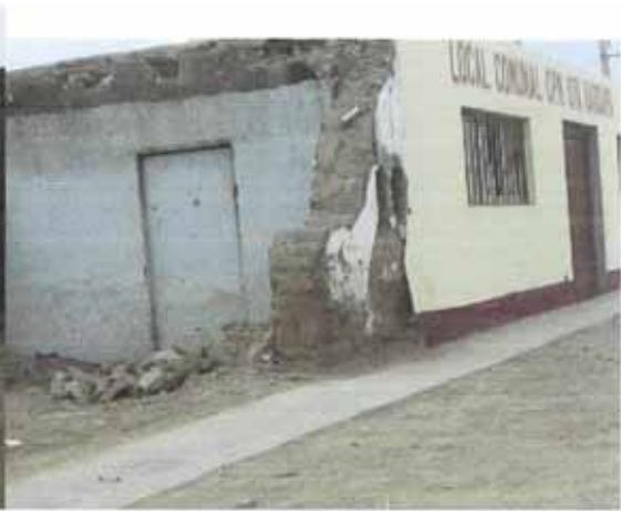
FIGURA Nº 2.16 LOCAL COMUNAL EN EL C.P. SANTA BÁRBARA
