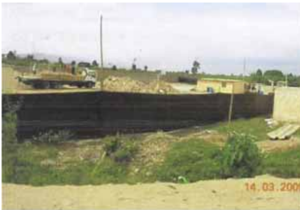
FIGURA Nº 2.05 CONSTRUCCIÓN DE NUEVO CENTRO EDUCATIVO
