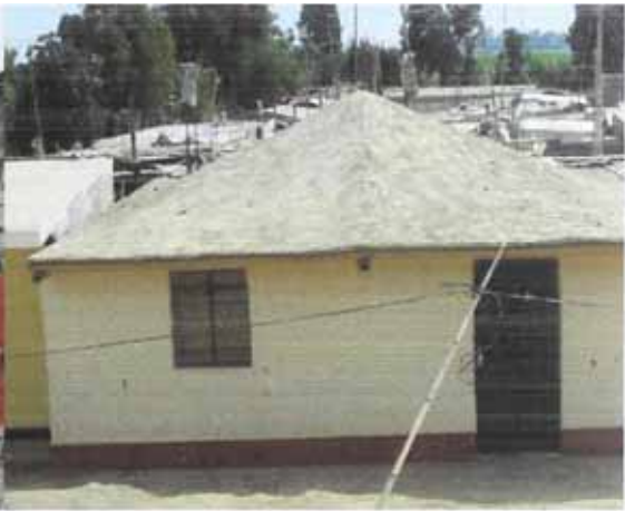
FIGURA Nº 2.18 MODULO DE VIVIENDA DE ADOBE REFORZADA EN EL C.P. LA QUEBRADA
