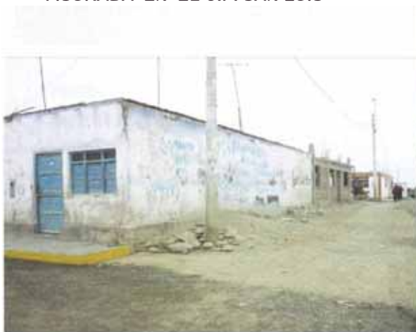
FIGURA Nº 2.19 VIVIENDA DE ADOBE EN MAL ESTADO EN EL C.P. SANTA CRUZ
