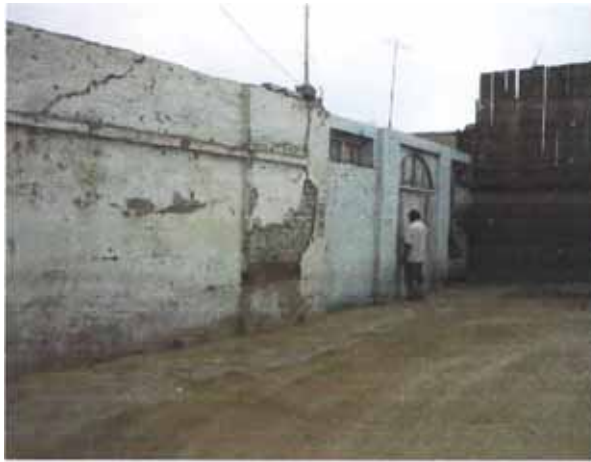
FIGURA Nº 2.15 LOCAL COMUNAL EN EL EL C.P. LA QUEBRADA
