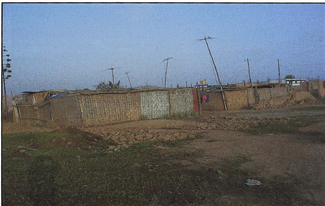
Fotografía N° 20: Viviendas en el asentamiento humano Nuevo Cerro Azul, aún en reconstrucción después del sismo del 2 007.
