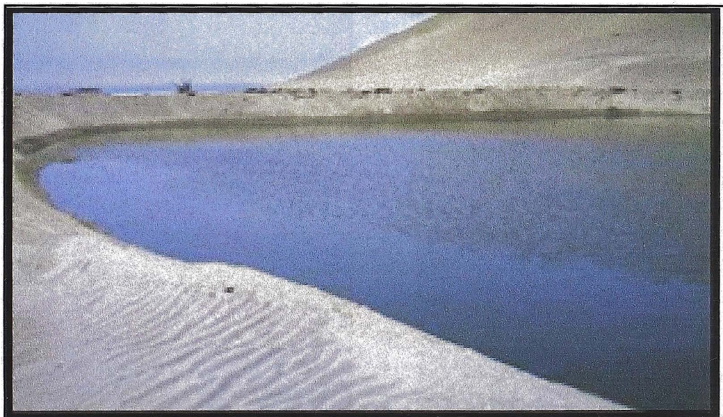
Fotografía N° 12: Laguna de estabilización, que recibe las aguas servidas del distrito.
