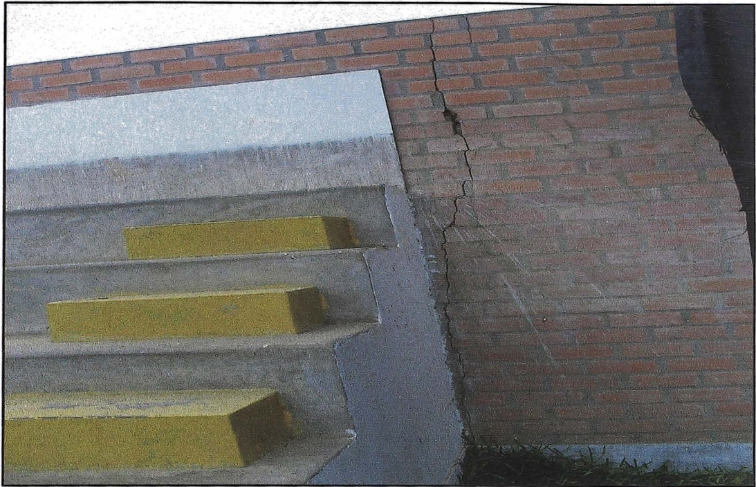
Fotografía N° 23: Fallas estructurales por asentamiento del suelo de fundación, en el complejo deportivo “José Pain”
