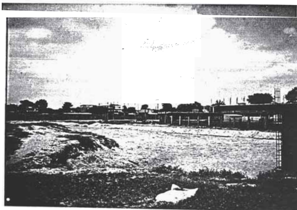
Foto 5.2: Colegio y muro interrumpiendo el cause de la quebrada Cola del Alacrán
