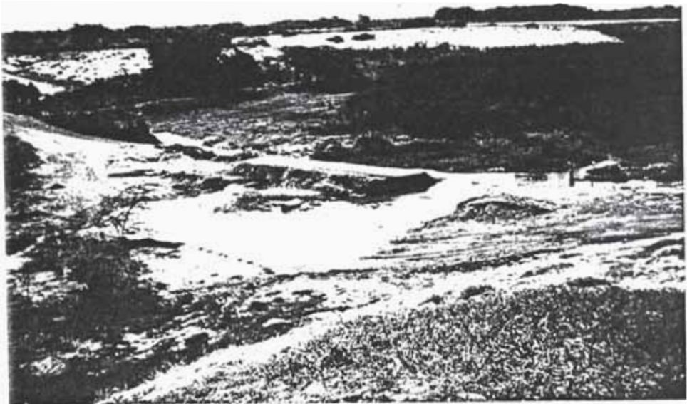
Foto 5.4: ENSO 1992, Carretera a la Tina interrumpida por las aguas del Boquerón
