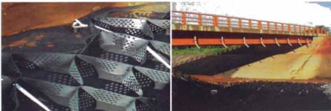
Foto N° 2.1 Protección de estribos con geoceldas de cemento-arena
