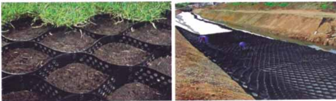
Foto N° 2.2 Protección riberas con geoceldas revegetadas.
