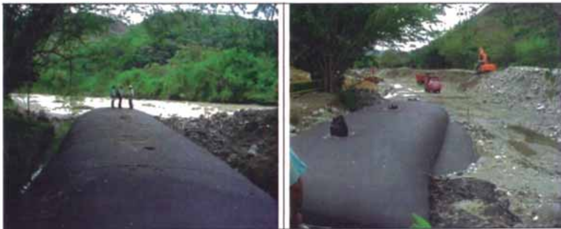
Foto N° 2.4 Encauzamiento de ribera con espigones de tubos de geotextil.
