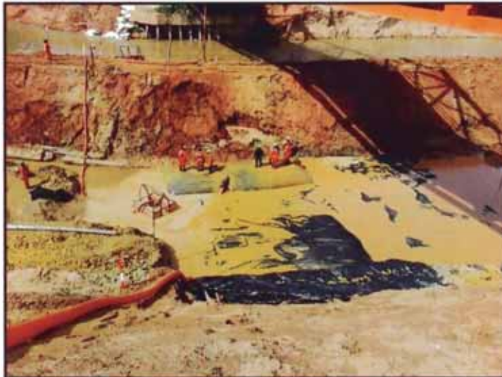
Figura N° 2.5.- Se muestra el llenado de la geoestructura de anclaje del manto anti socavación.
