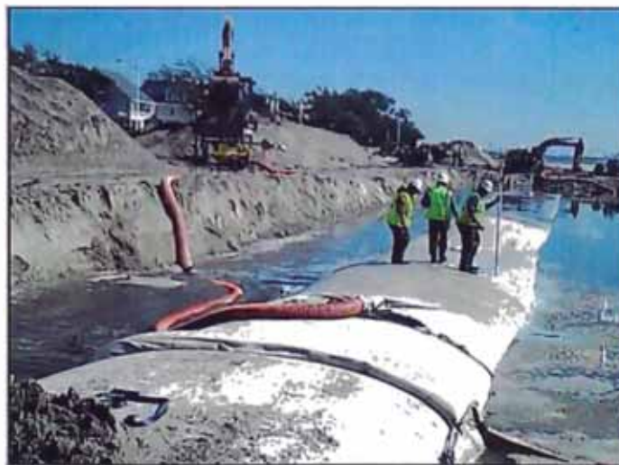
Figura N° 2.8.- Llenado de la geoestructura.
