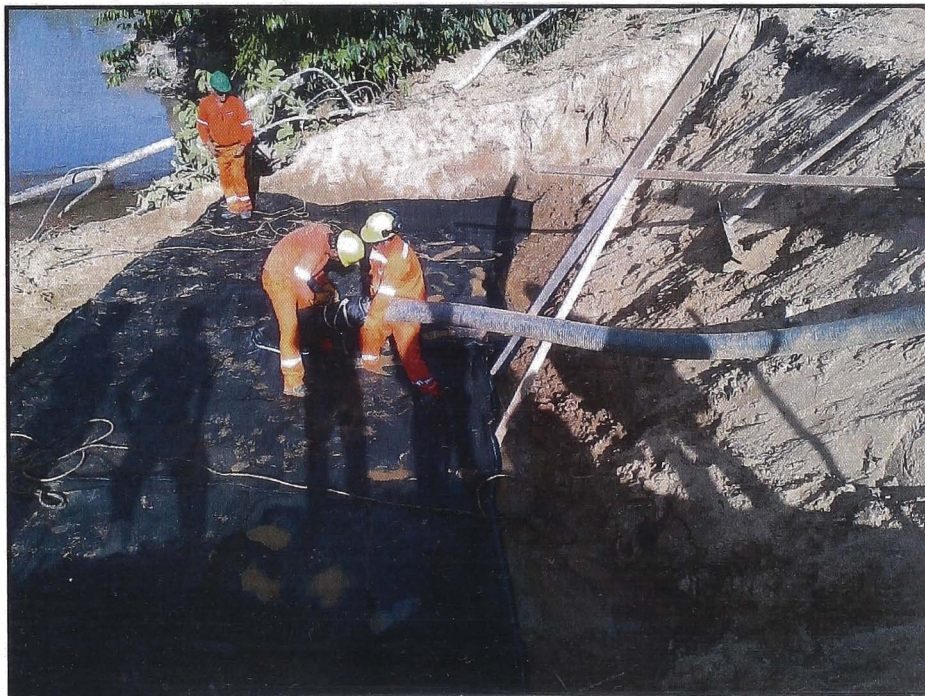
Figura N° 2.- Colocación de la tubería flexible a la boquilla de la geoestructura.
