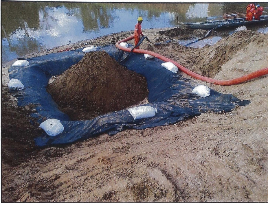
Figura N° 3.- Poza provisional para la prueba que servirá para la mezcla del slurry.
