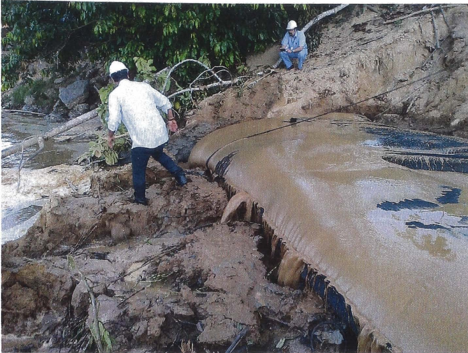
Figura N° 5.- Procedimiento de Llenado de la Geoestructura, escurrimiento del agua de la geoestructura.
