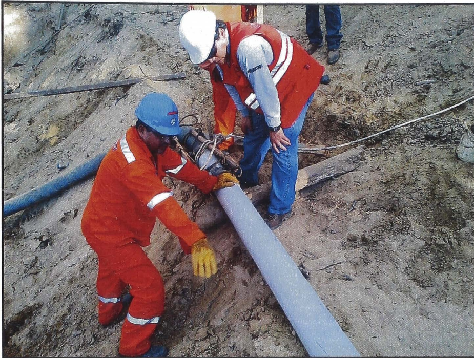
Figura N° 1.- Colocación de la Tubería que servirá para el llenado geoestructura.
