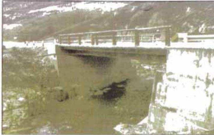
El puente Moche 4 fue construido en el cuarto cruce del río Moche con la carretera, en la progresiva Km. 52+807; la pendiente del cauce es de 11.2% y se ha estimado un caudal  $Q_{100} = 36.7 \text{ m}^3/\text{s}$ .
