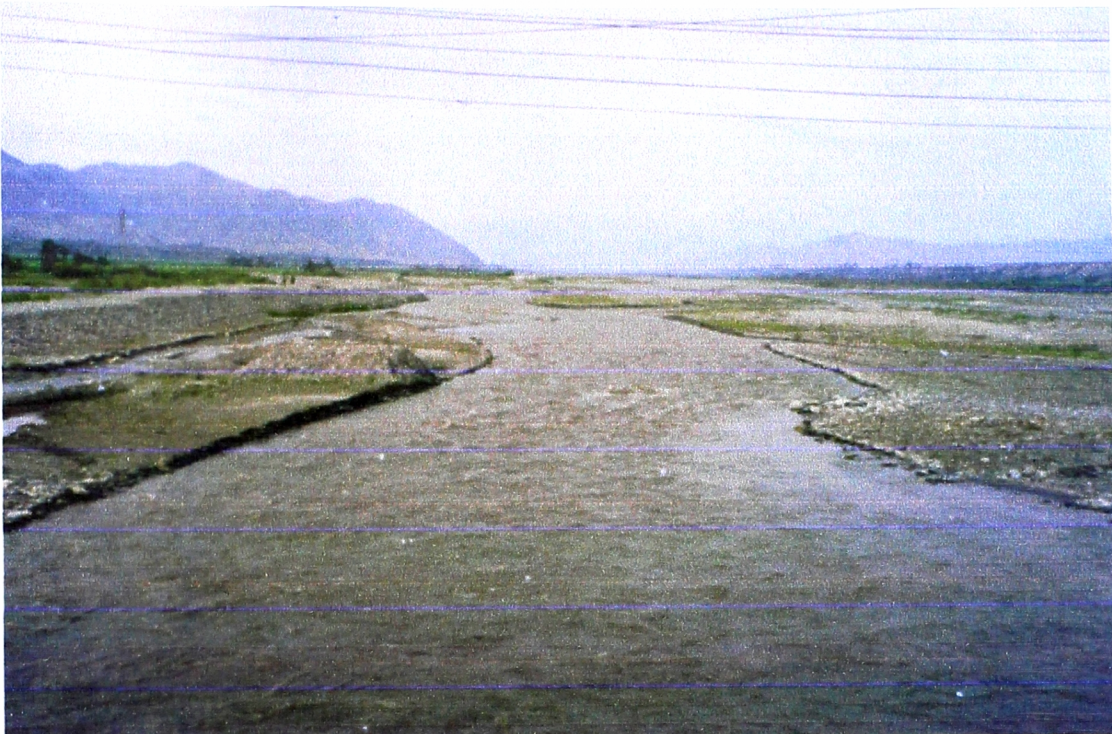
FOTO 05.- Vista del río Pativilca, aguas abajo, del puente Simón Bolívar
