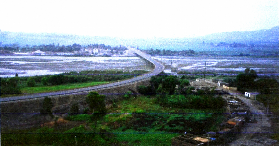
FOTO 01 Vista General, Carretera Panamericana Norte , Puente Simón Bolívar, Río Pativilca
