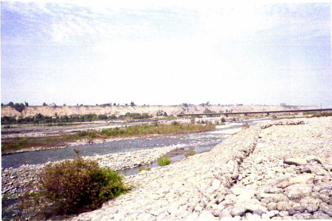
FOTO 11 Otra Vista. Protección existente
