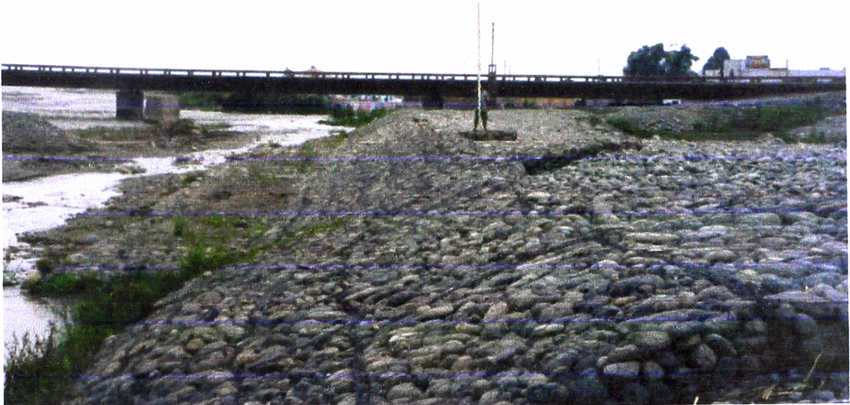
FOTO 09. Margen Derecha, aguas arriba protección existente.
