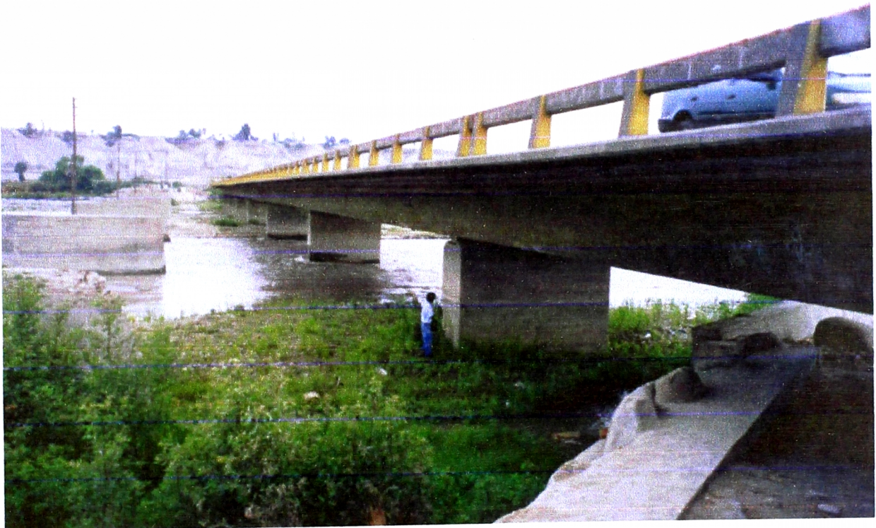
FOTO 14. Puente Simón Bolívar (Margen Derecha)
