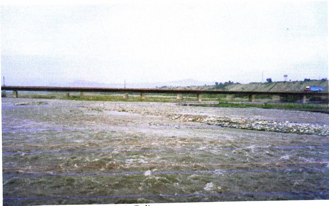
FOTO 04. Vista del Puente Simón Bolívar.
