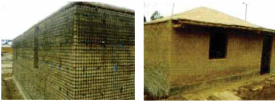
Fig. 3.13: Viviendas de adobe reforzado
