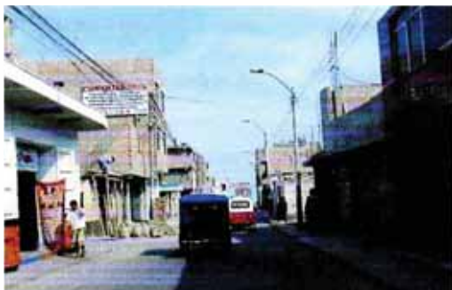
Fig. 3.6: Viviendas de más de 1 piso - Mala
