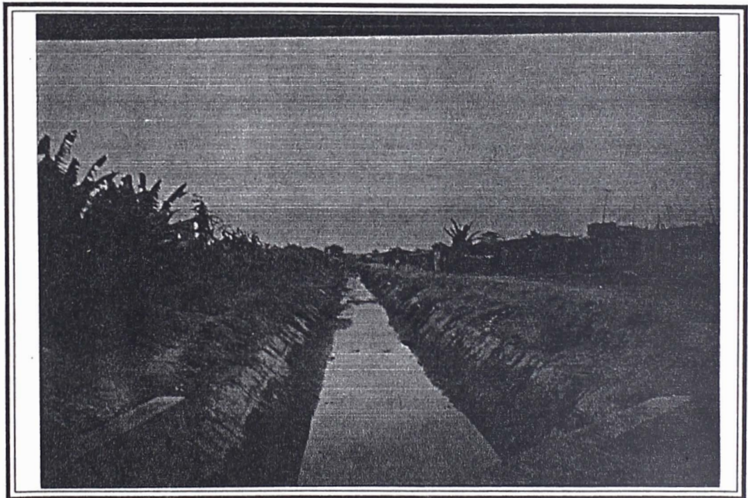
Foto 26: Inundación producida por las lluvias y desborde del río en la margen derecha del río Tumbes. Las zonas más afectadas fueron los A.A.H.H ubicados en la zona baja de la ciudad y los que están adyacentes al canal de irrigación agrícola "La Tuna".
