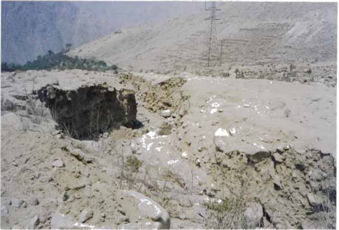
Foto 22: Quebrada Cashahuacra: Zona de transporte, mirando aguas abajo. Obsérvese la profundidad del cauce (6 m.) y los andenes pre-incaicos abandonados en la ladera.
