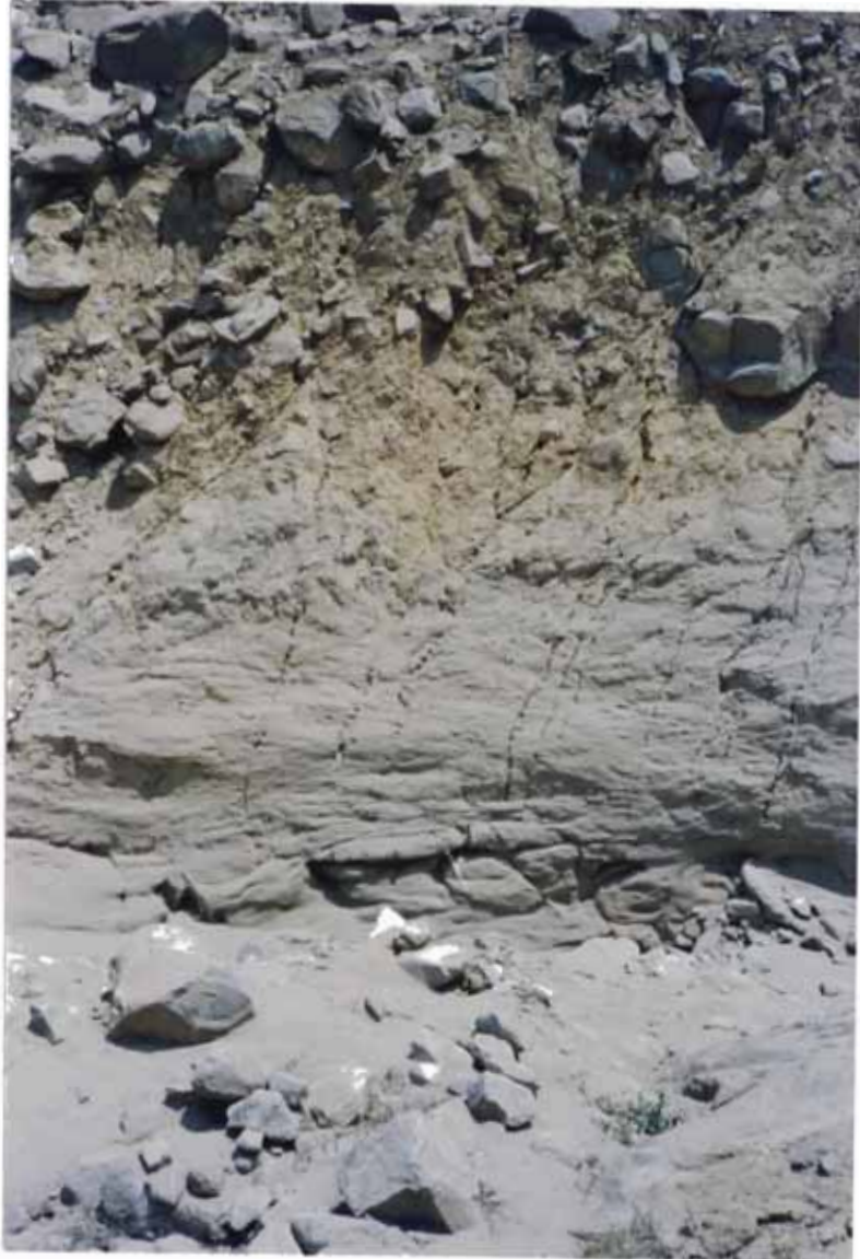
Foto 14: Quebrada Pedregal. Aquí se observa con claridad, las huellas del último huayco, y la altura que alcanzó el flujo. Arriba, otro depósito colgado.
