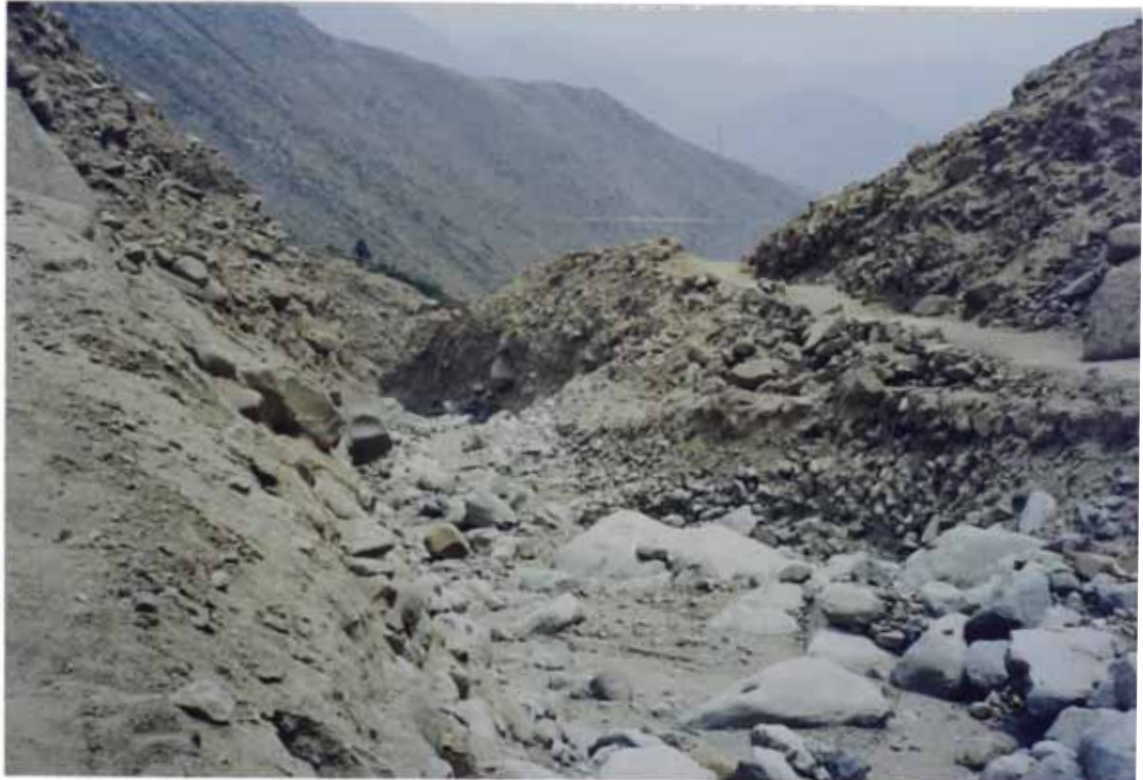
Foto 9: Quebrada Pedregal. Material acumulado en el talweg. Aquí nace el canal principal. Al fondo, tubería que une el canal UTAPP.
