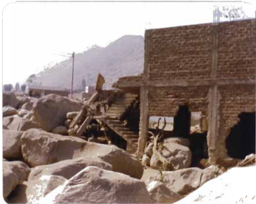
Foto 21: San Miguel de Pedregal. Vivienda fuertemente dañada. El huayco la atravesó.
