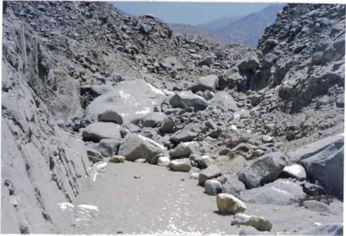
Foto 11: Quebrada Pedregal: Bloques de gran tamaño obstruyen el paso a futuros huaycos y son un peligro potencial.
