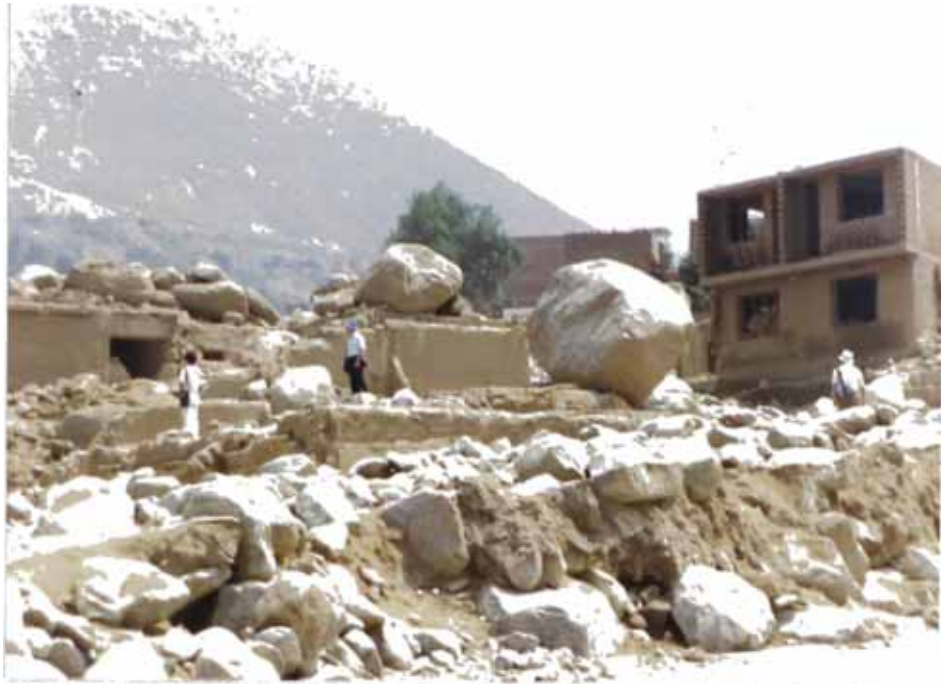
Foto 17: San Miguel de Pedregal: Viviendas aplastadas (foto a 6 días del evento). La roca de la derecha tiene 3 m. de diámetro.
