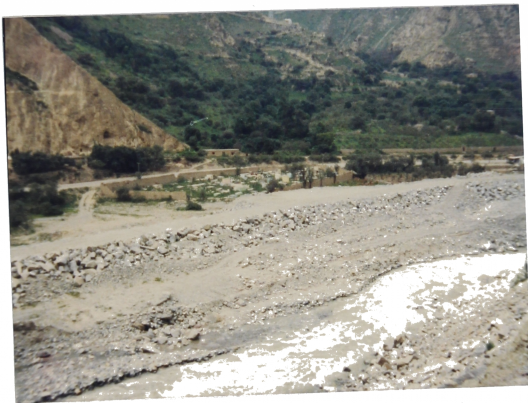
Foto N° 26. Km. 68+000. Zona de Surco. La Carretera Central transcurre por el lecho de inundación del Río Rímac: el cementerio y parte del pueblo de Surco se hallan ubicados en el lecho de inundación, razón por la que fueron destruidos en las temporadas de lluvias torrenciales de 1983 y 1984.
