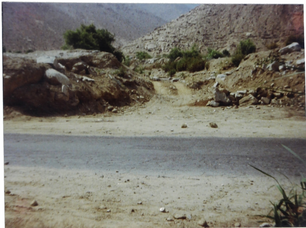
Foto N° 54. Km. 4I+900 . Qda. de Santa Ana , cruza a nivel la Carretera Central y el Ferrocarril Central. Por esta quebrada bajen huacos de lodo.
