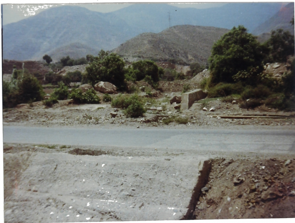
Foto N° 35. Km. 51+520. Qda. de Agua Salada, cruza a nivel a la Carretera Central. Zona de Carachaca.
