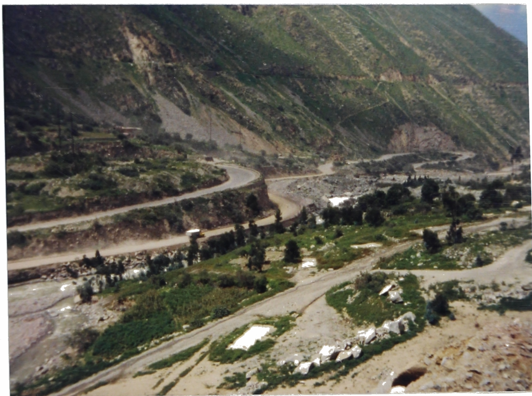
Foto N°17. Km. 72+900 .Vista de la Carretera Central y el Ferrocarril Central en la zona de Collana. Este tramo de la Carretera fue destruida por el Río Rímac en 1983 y 1984.
