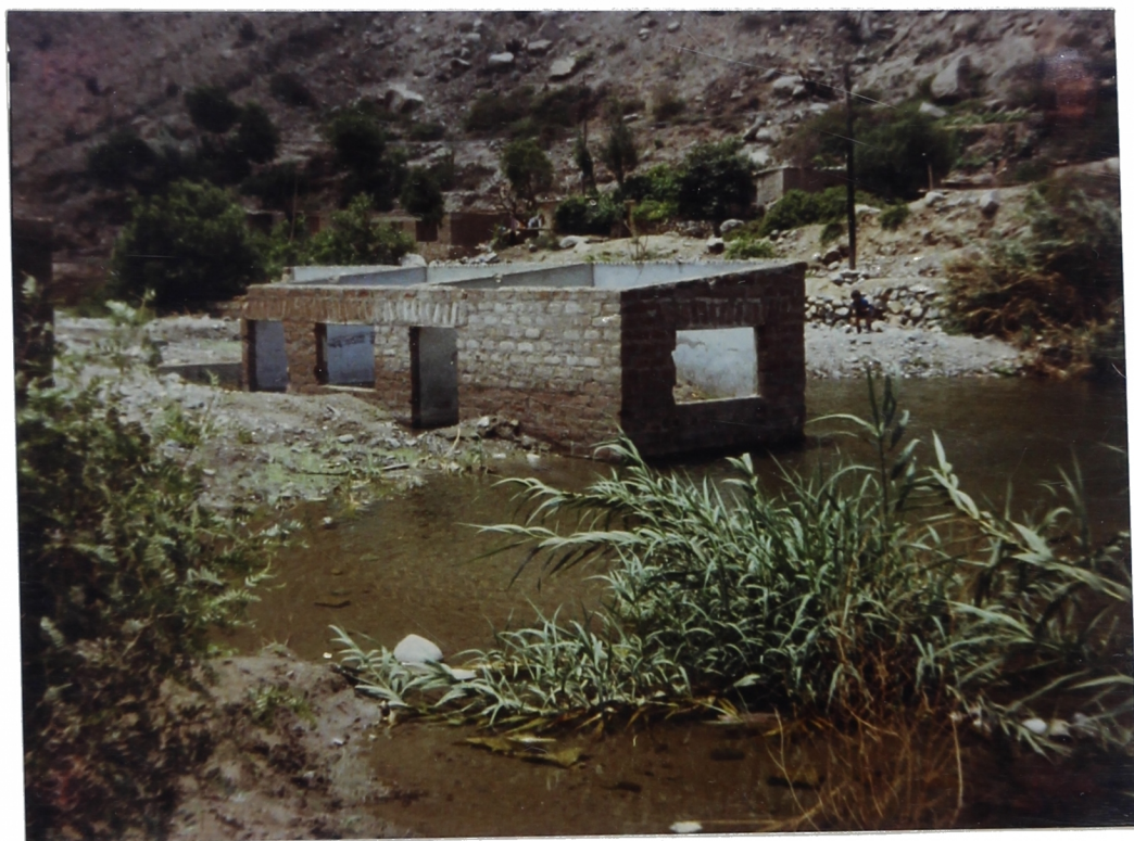
Foto N° 42. Km. 47+5000. Otro lugar de la zona baja de Corcona donde existe fuerte infiltración. La vivienda que aparece en la vista fue destruida por un husico en 1983.
