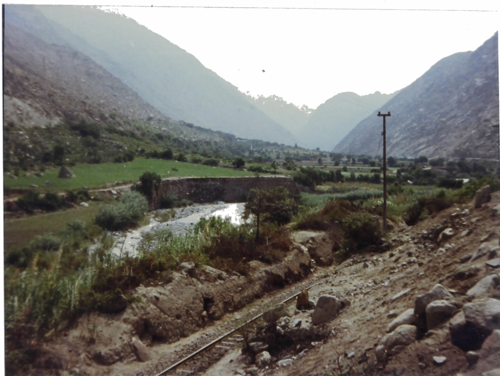
Foto N° 52. Km. 43+500 . Zona rural de Cupiche. El Río Rímac destruye por erosión tierras de cultivo, disminuyendo la frontera agrícola.
