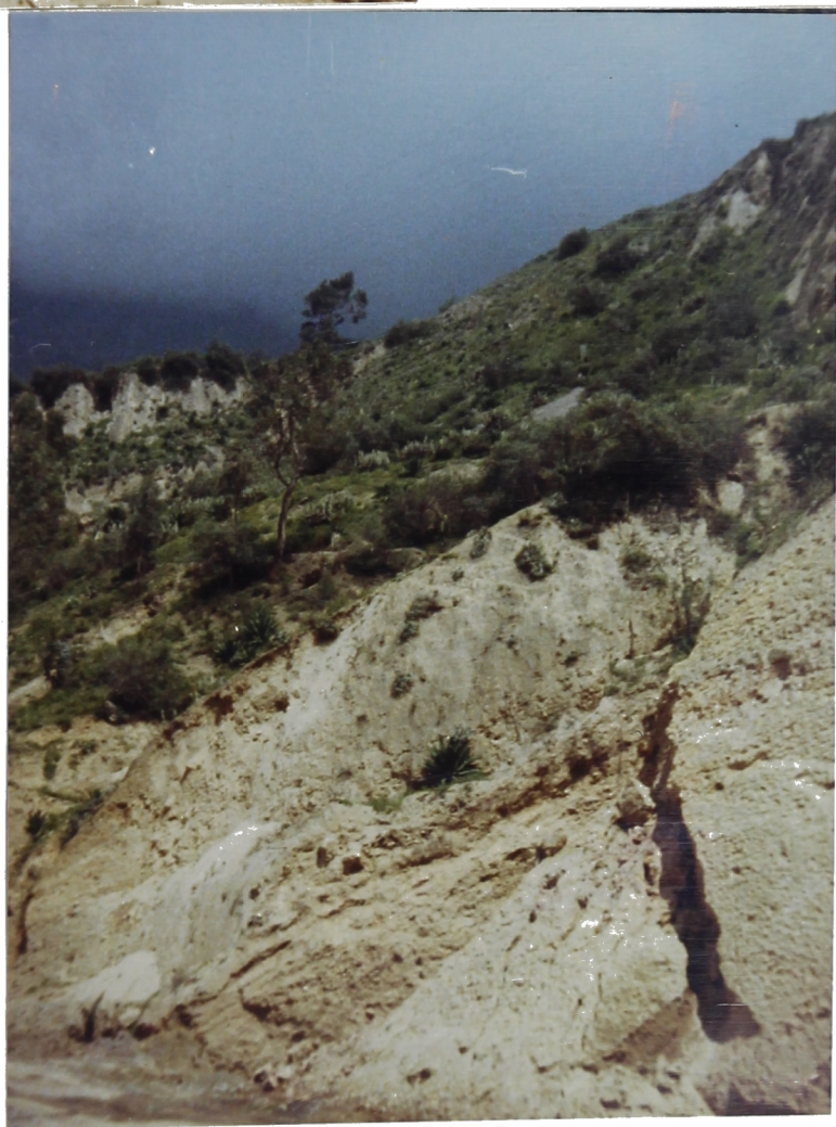
Foto N° 20. Km. 71+300 Zona media de Salón Blanco por donde transcurre la nueva Carretera Central, Tramo IV-B. Es zona de infiltración de agua. Suelo aluvional-coluviál.
