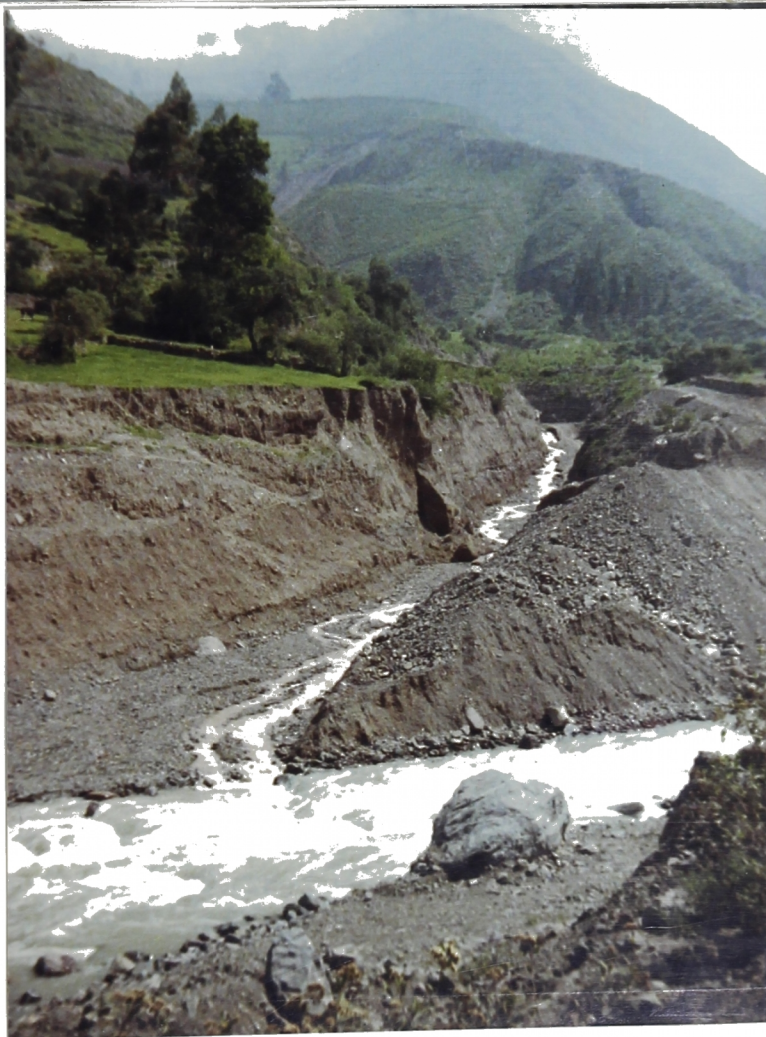
Foto N° 2. Km. 77+ 430 La Qda. Payhua, que desemboca en el Río Rímac frente a Matucana, trae huaicos mixtos.
