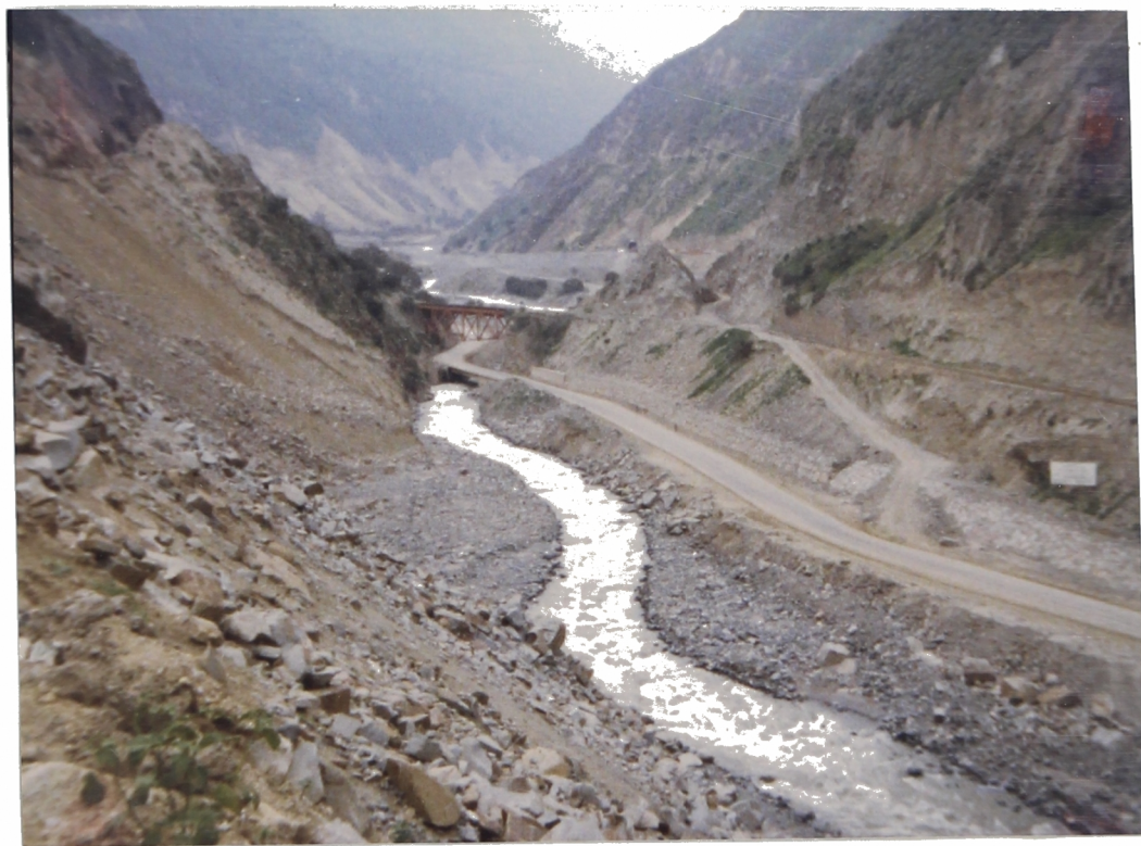
Foto N° 25. Km. 68+900. Zona de Huyupampa. La Carretera Central transcurre por el lecho de inundación del Río Rímac; el puente Quitasombbrero subdimensionada, y el Ferrocarril Central protegido por un enrocado. En la margen derecha la nueva Carretera Central (Tramos: IV-A, B y C.)
