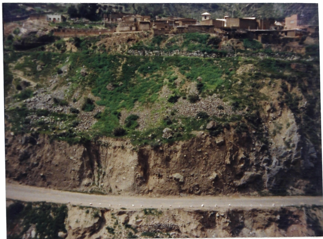
Foto N° 13. Km. 73+800 . El pueblo de Huariquiña ubicado sobre una terraza de suelo aluvional-coluviel. En la vista la Carretera Central.
