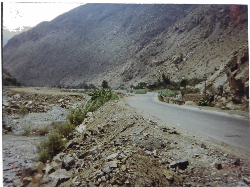
Foto N° 46. Km.47+250 . Otra vista del muro de encauzamiento del Río Rímac en la parte baja de Corcona. Antes esta zona se inundaba por desbordes del Río Rímac.
