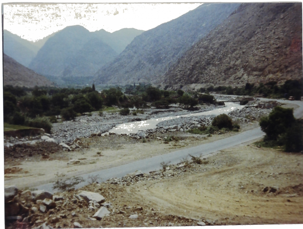
Foto. N° 49. Km. 44+500. Zona de Cupiche. Parte de la Carretera Central transcurre por el lecho de inundación del Río Rimac, por esta razón es zona de inundaciones. Al fondo la Qda. de Puruguey.
