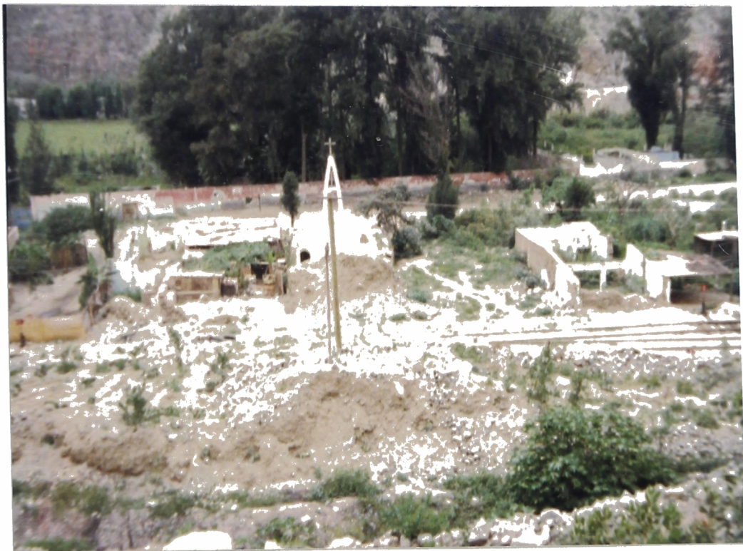
Foto N° 34. Km. 55+660. El pueblo de Tornamesa. La iglesia y parte del pueblo destruido por inundación en la temporada de lluvias torrenciales de 1983 y 1984. Ahora gran parte del pueblo se halla inundada por infiltración.
