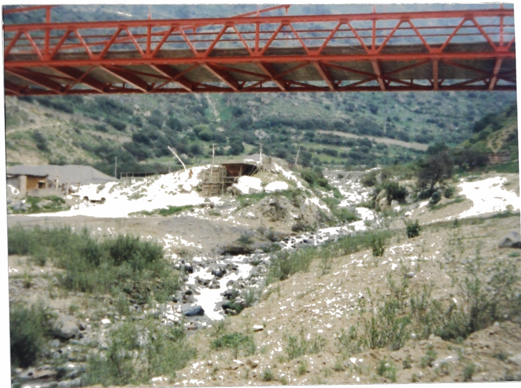
Foto N° 21. Km. 71+130 . Qda de Yanajune (Salón Blanco) y el Puente Eduardo de Habich. Esta quebrada trae huacicos de roca en mayor proporción.
