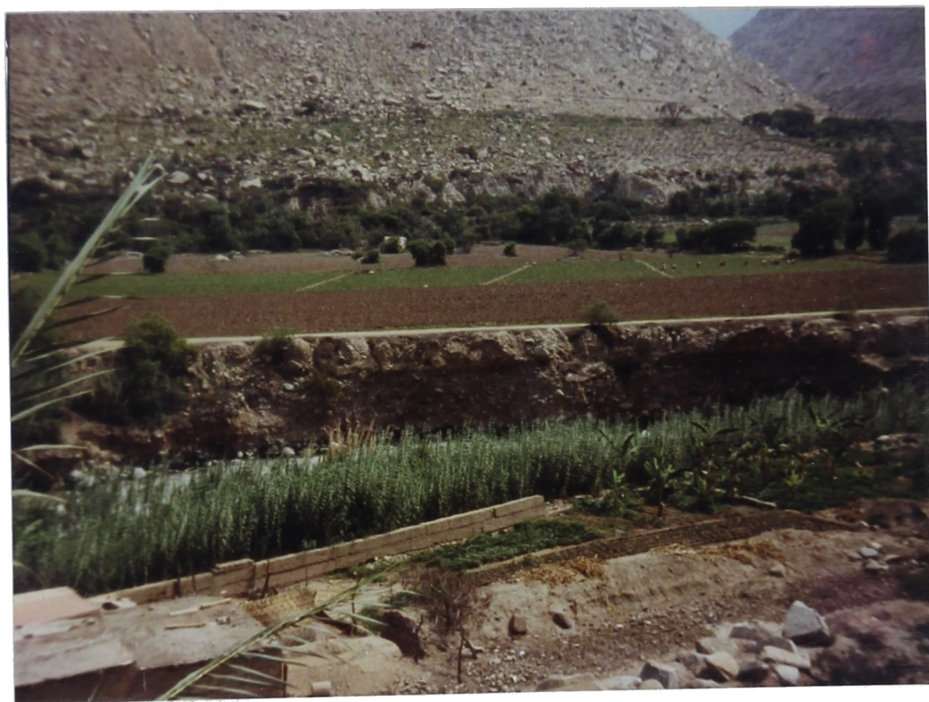
Foto N° 53. Km.43+200 . Otra zona de fuerte erosión de orillas, en las partes bajas de Cupiche.
