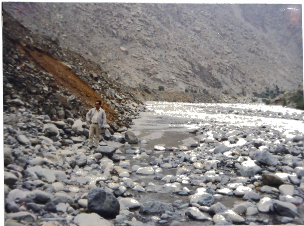
Foto N° 38. Km.49+000 . Zona de Corcona. El Río Rímac está encauzado por un muro de material suelto procedente de la mina de Baritina Perúbar. Este muro no resuelve el problema de infiltración.
