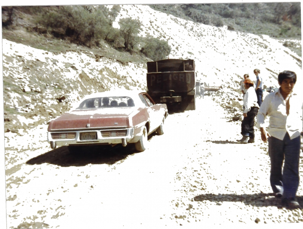
Foto N° 24. Km.71+200 . Zona Salón Blanco. Tramo de emergencia construido por el Ministerio de Transportes y Comunicaciones(Supervisión Proyecto Cupiche-Matucana) a raíz de la destrucción de la Carretera Central en la temporada de lluvias torrenciales de 1986(Febrero).
