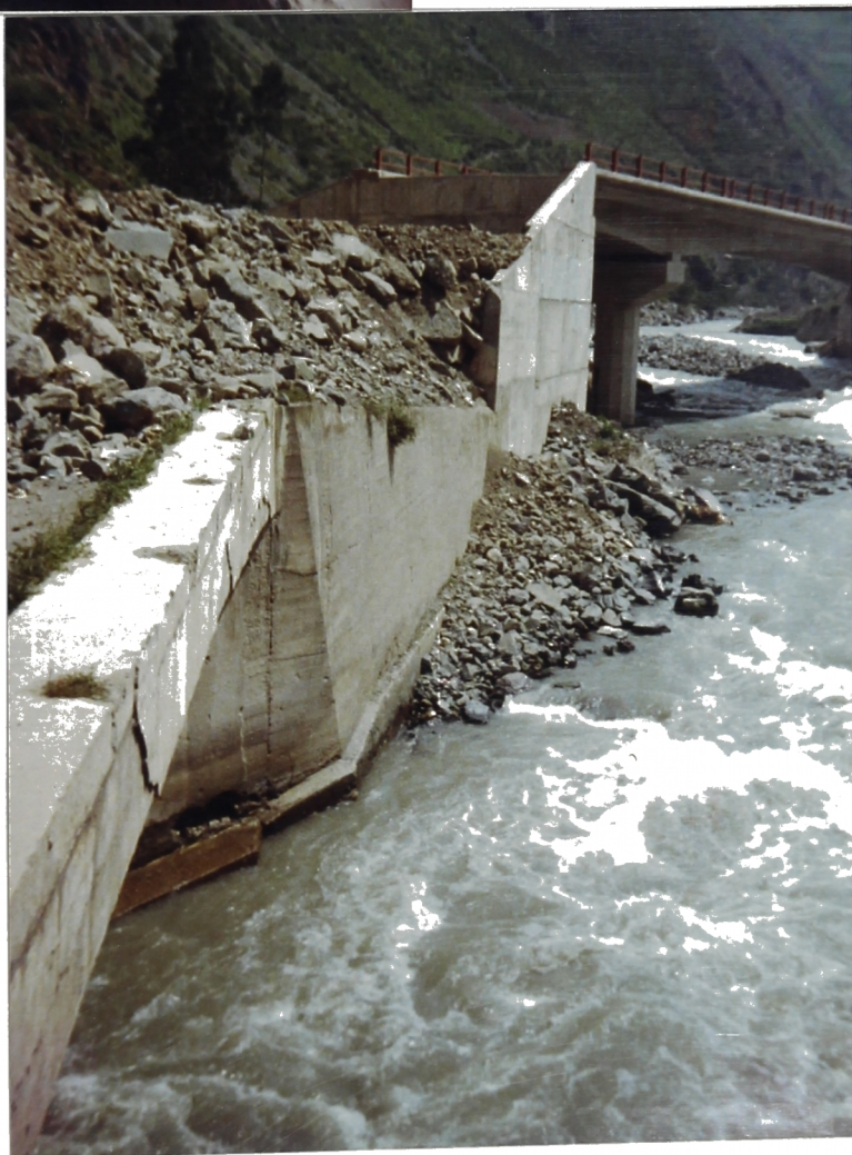
Foto N° 6. Km. 76+100 Antiguo puen- te de acceso en Matucana afectado por la erosión. En este punto termina el Tramo IV de la Nueva Ca- rretera Central. Al fon- do el nuevo puente Matu- cana.
