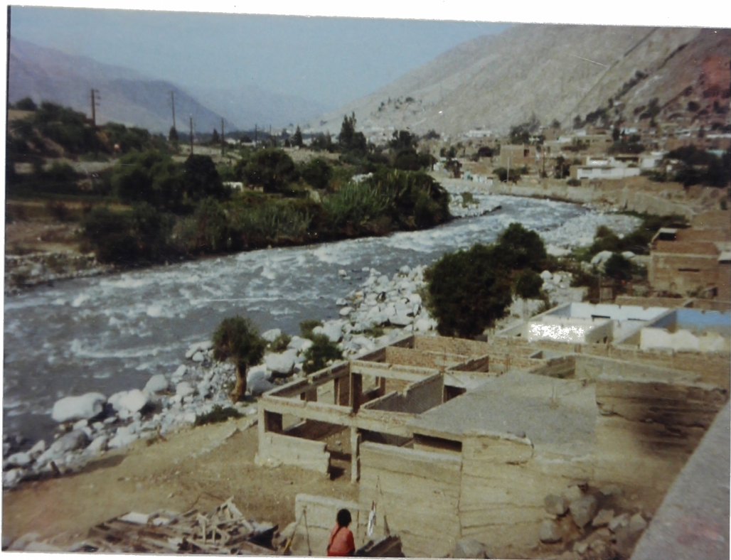
Foto N° 56. Km. Zona de Ricardo Palma. Viviendas destruidas por inundación en la temporada de lluvias torrenciales de 1983. Km. 37+500
