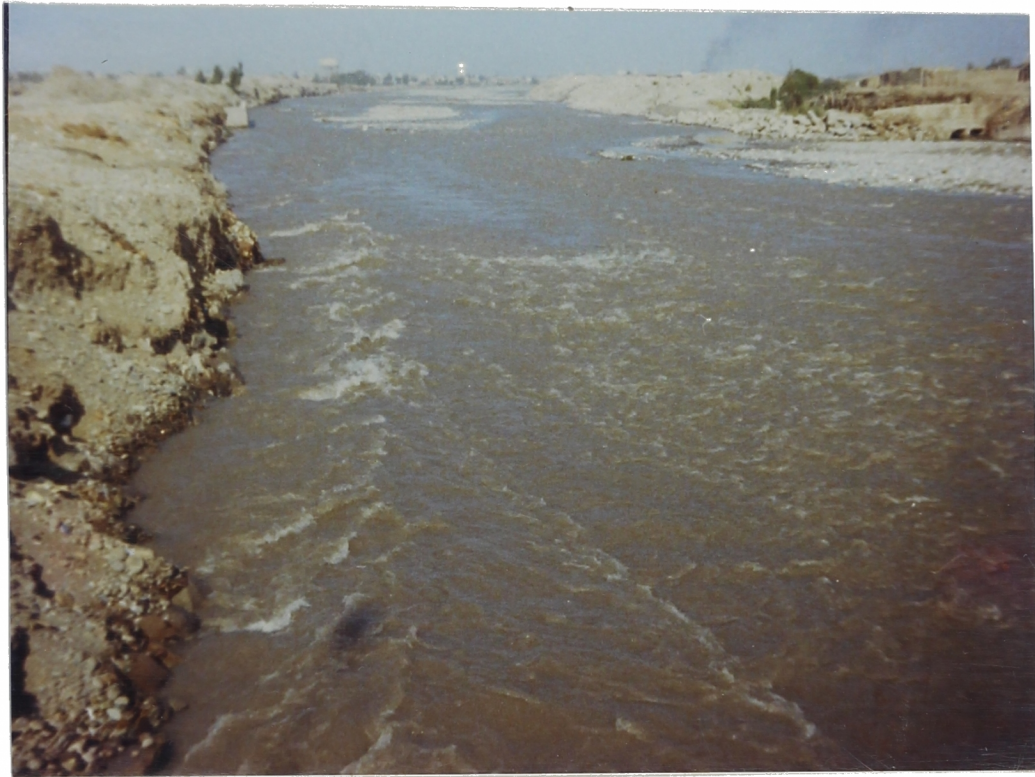
Foto N° 60. Zona del Callao. El Río Rímac tiende a ampliar su cauce bajo una fuerte sedimentación, esto permite que en temporada de avenidas, pueblos jóvenes como el de San Jorge y zonas industriales como el del SIMA sufran de inundaciones.
