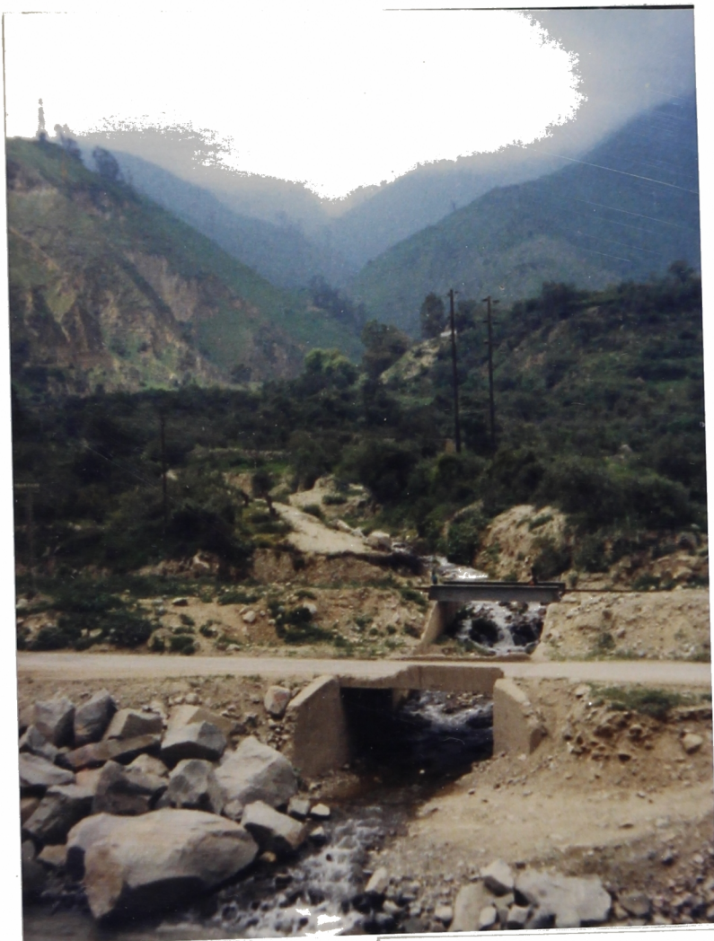
Foto N° 30. Km. 66+900 Qda. de Matala, cruza el pueblo de Surco en la parte baja. Los hueicos que bajan por su cauce son mixtos. Le alcantarilla se entierra al paso de un huai- co.
