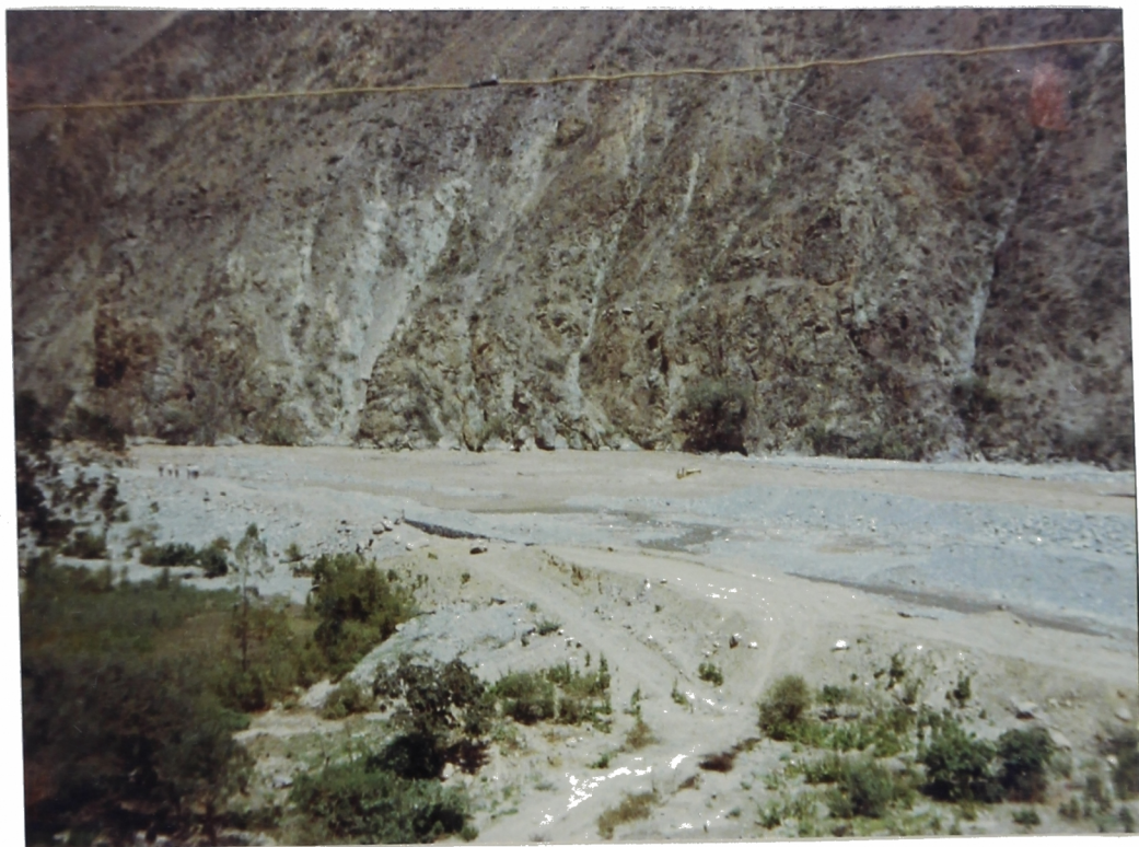
Foto N° 32. Km57+000 .Zona de Tornamesa.El Río Rímac amenaza de inundación al pueblo de Tornamesa ya que este pueblo se halla ubicado en el lecho de inundación del río con una cota inferior al pelo de agua. En la vista un tractor enterrado por el río.
