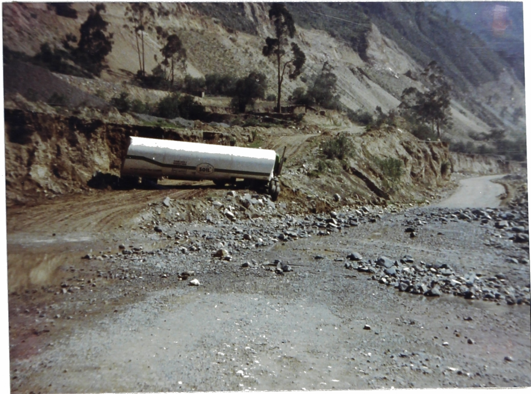
Foto N° 23. Km. 71+200 .Zona Salón Blanco. Otra vista de la Carretera Central destruida por el Río Rímac. Al fondo el Tramo IV-B de la nueva Carretera Central.Suelo aluvio-coluvial.
