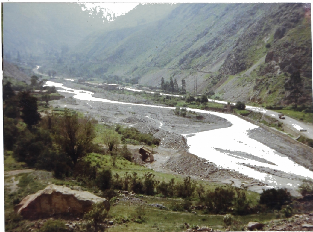
Foto N° 9. Km. 74+000 .Poblado de Monterrico, es zona de inundación; la Carretera Central está protegida por un muro de concreto subdimensionado.
