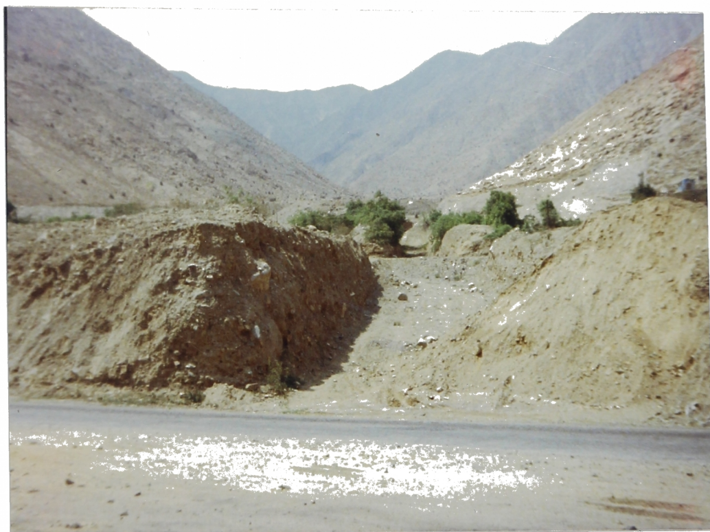
Foto N°50. Km. 44+400. Qda. de Cupiche, cruza la Carretera Central a nivel. Los huiscos que bajan por esta quebrada son mayormente mixtos.
