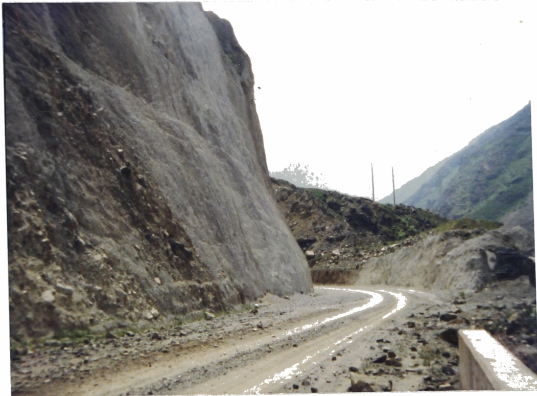
Foto N° 15. Km. 73+800 . Tramo IV-B de la Nueva Carretera Central en la zona de Huariquiña. En la vista un talud constituido por suelo friccionante (arena, arcilla y limo).
