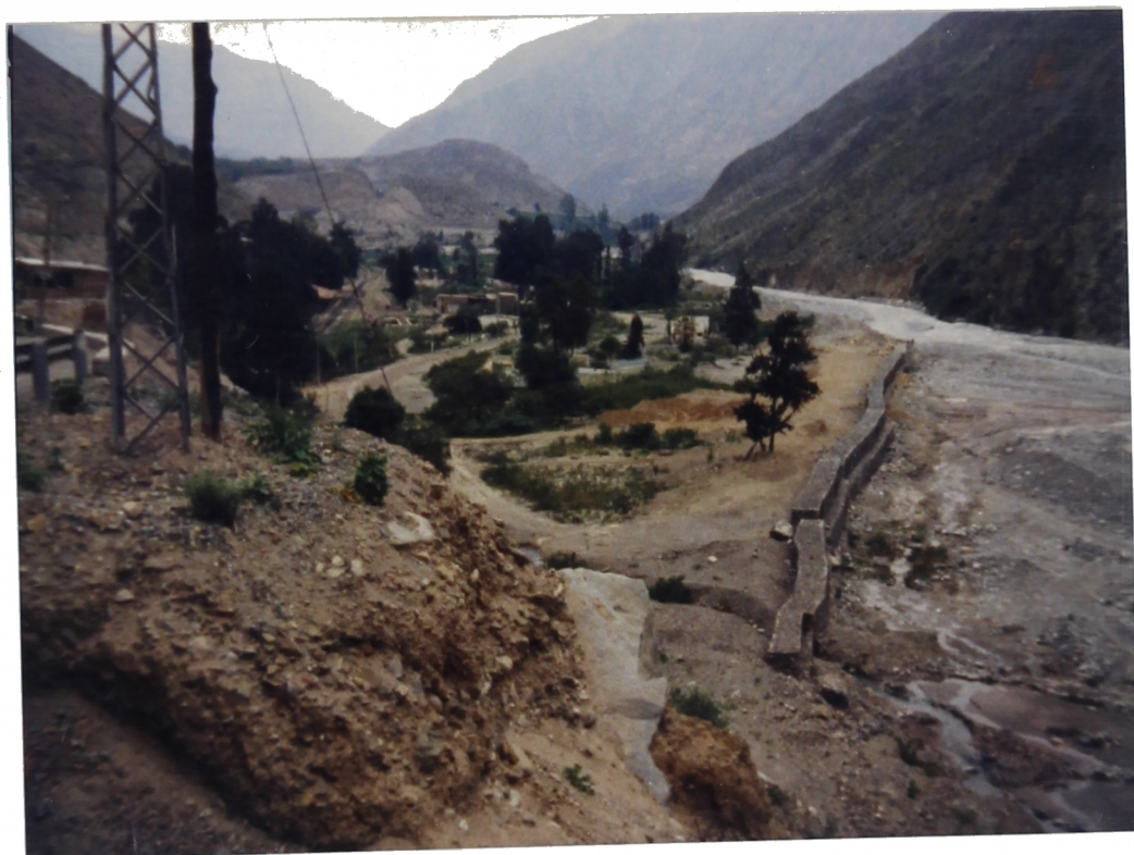
Foto N° 33. Km. 57+000 . El Río Rímac y el Pueblo de Tornamesa con una cota inferior que el pelo de agua del río. En la vista un muro de roca tipo gavión. No protegerá al pueblo ante una fuerte descarga del río ni de la infiltración que ahora existe.
