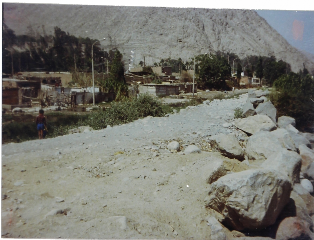
Foto N° 58. Km. 22+000. Zona ribereña de Morón inundada por el Río Rímac en Febrero de 1986.
