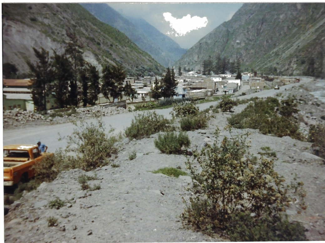
Foto N° 4. Km. 76+400 .Muro de protección y encausamiento del Río Rímac de material suelto de huaico procedente de la Qda. Payhua, de fácil erosión.
