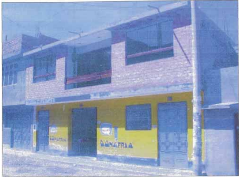
Figura 6.8: Mampostería con una buena calidad de su sistema resistente.
