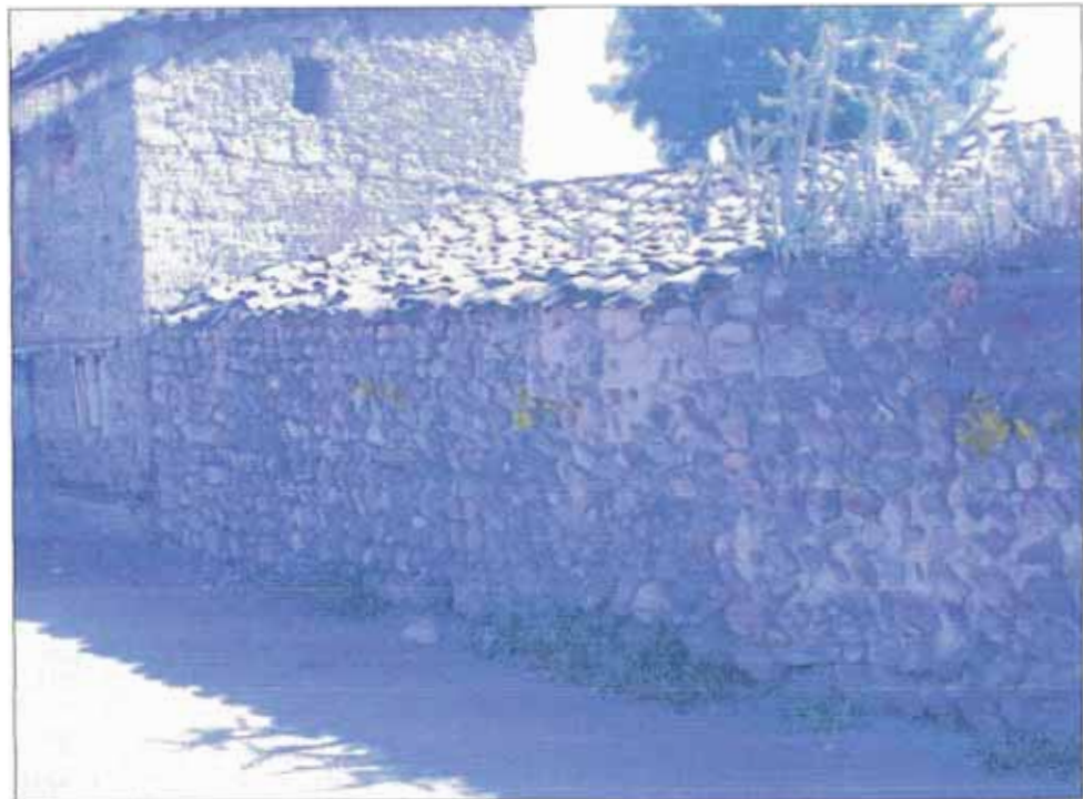
Figura 6.9: Mampostería de piedra.
