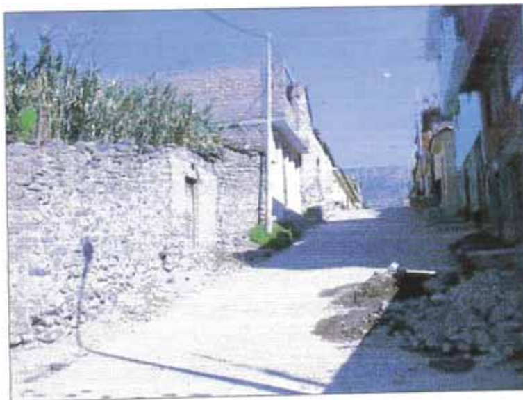
Figura 6.13: Viviendas emplazada sobre grandes pendientes.
