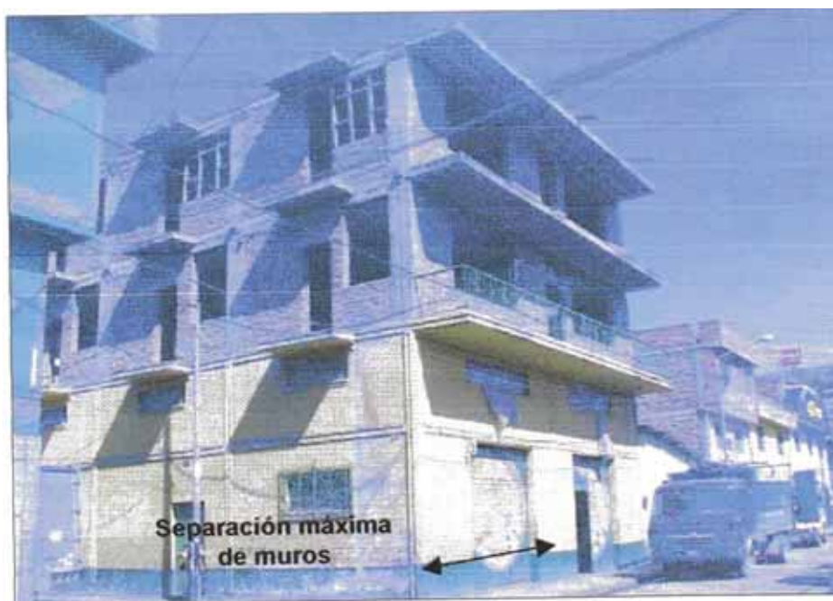
Figura 6.24: Separación máxima entre muros
