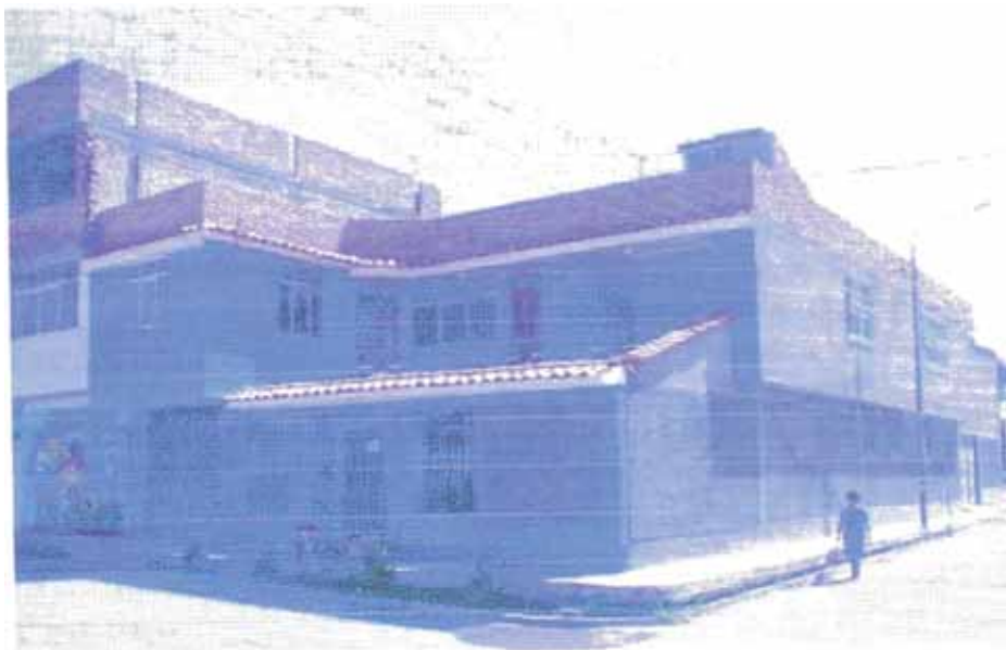
Figura 6.33: Construcción de albañilería en buenas condiciones.
