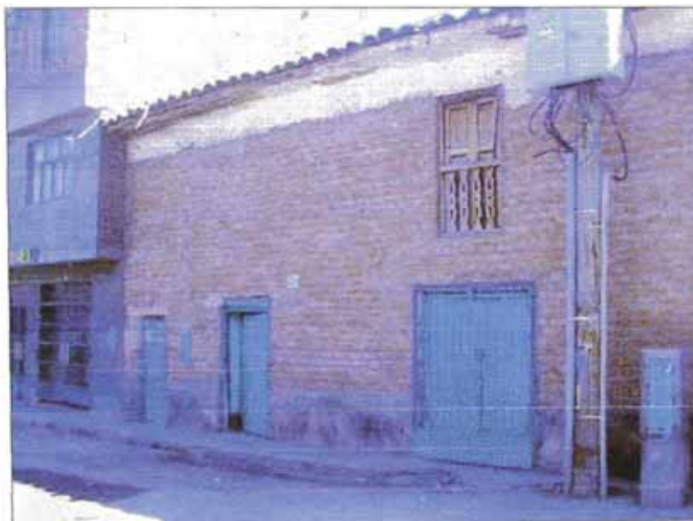
Figura 6.15: Vivienda de dos pisos sin diafragma rígido visible.
