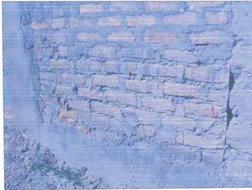
Figura 6.6: Mortero de mala calidad, con juntas irregulares.
