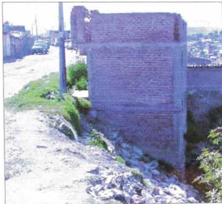
Figura 6.12: Vivienda emplazada sobre grandes pendientes.
