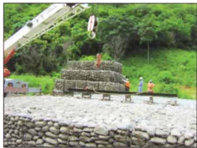
Fotos 16, 17, 18: Proceso de prefabricación de gaviones en Planta y Prueba de montaje.
