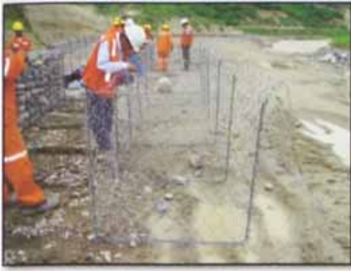
Fotos 10 y 11: Armado de canastilla de prueba con las "U" en los diafragmas y proceso de llenado manual con piedra para gavión.
