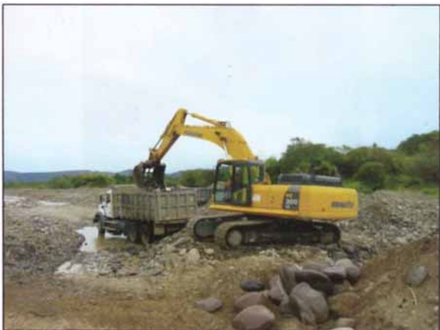
Foto N°7: Tercero, carguio a volquetes con material útil para gaviones.
