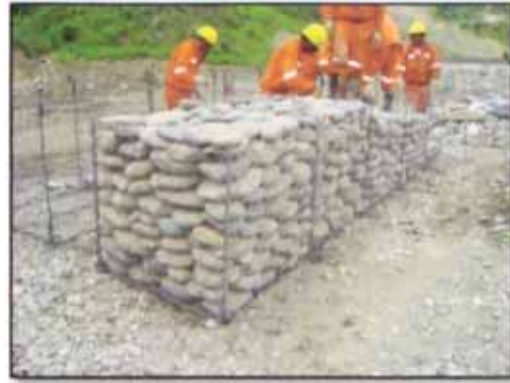
Fotos 10 y 11: Armado de canastilla de prueba con las "U" en los diafragmas y proceso de llenado manual con piedra para gavión.
