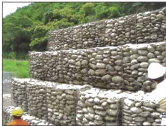
Fotos 19, 20: Montaje de cuerpos prefabricados y control de alineamiento.
