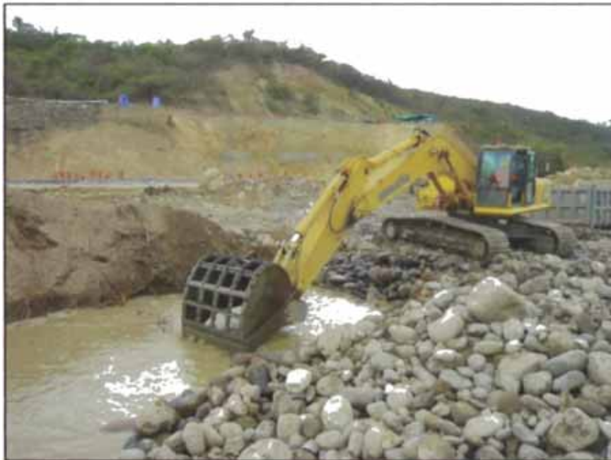
Foto N°5: Primer Paso, creación de poza de lavado en río y acopio de material.
