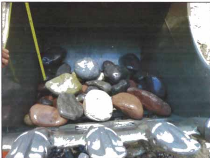
Foto N°3: El material extraído ya cumple con las dimensiones para Gavión.
