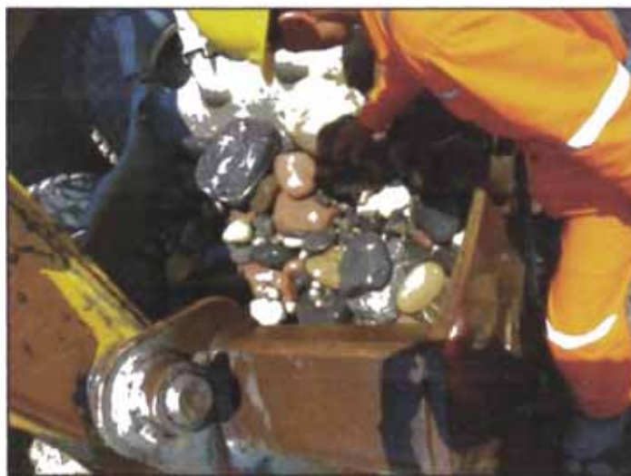
Foto N°1: Excavadora con Cuchara Zaranda en primera pruebas.
