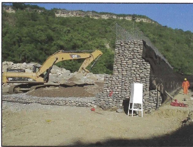
Fotos 15, 16 y 17: Ejecución de Enrocado de Protección SDT3-274 y colocación de cama de arena gravosa sobre colchón de gaviones para posterior Enrocado.
