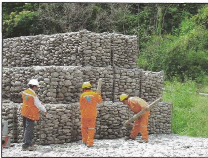
Fotos 12, 13 y 14: Prefabricación de Gaviones y Montaje en Plataforma.
