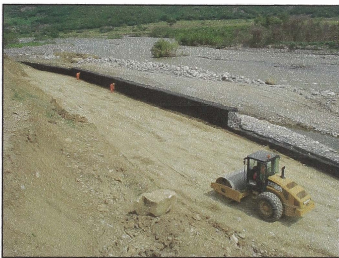
Fotos 15, 16 y 17: Enrocado, Muro de Gaviones y Relleno en SDT-246.
