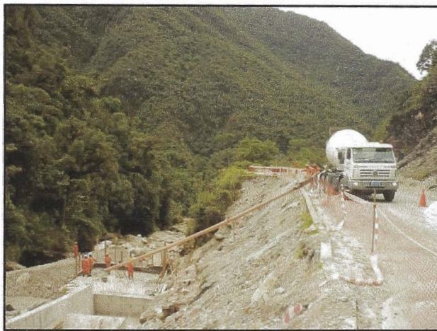
Fotos 9, 10 y 11: Muro de Concreto en Sector SDT3-277/276.
