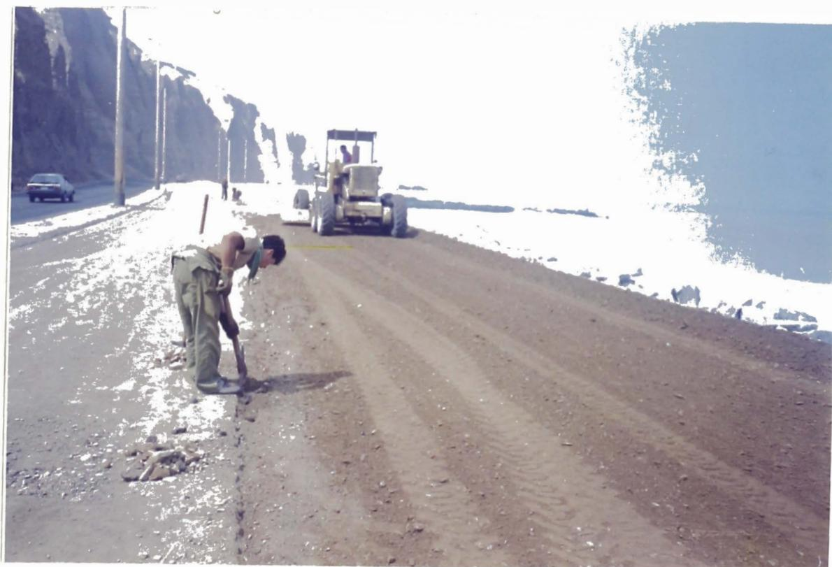
**FOTO N° 24:** *Perfilado de la carpeta existente para nivelar y facilitar la compactación en la junta.*
