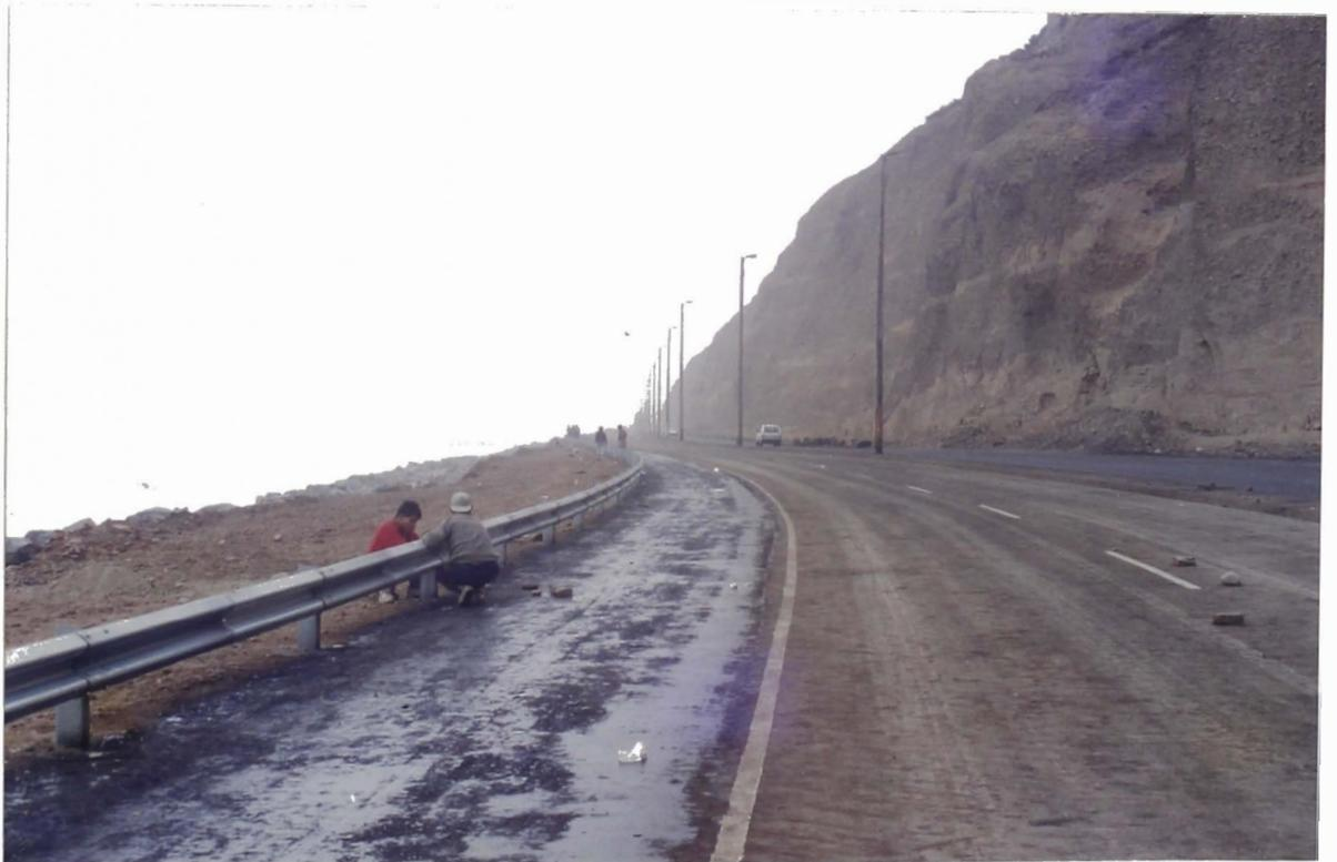
**FOTO N° 36:** *Imprimado de la berma. Prog. (0 + 00 hasta 1 + 500).*
