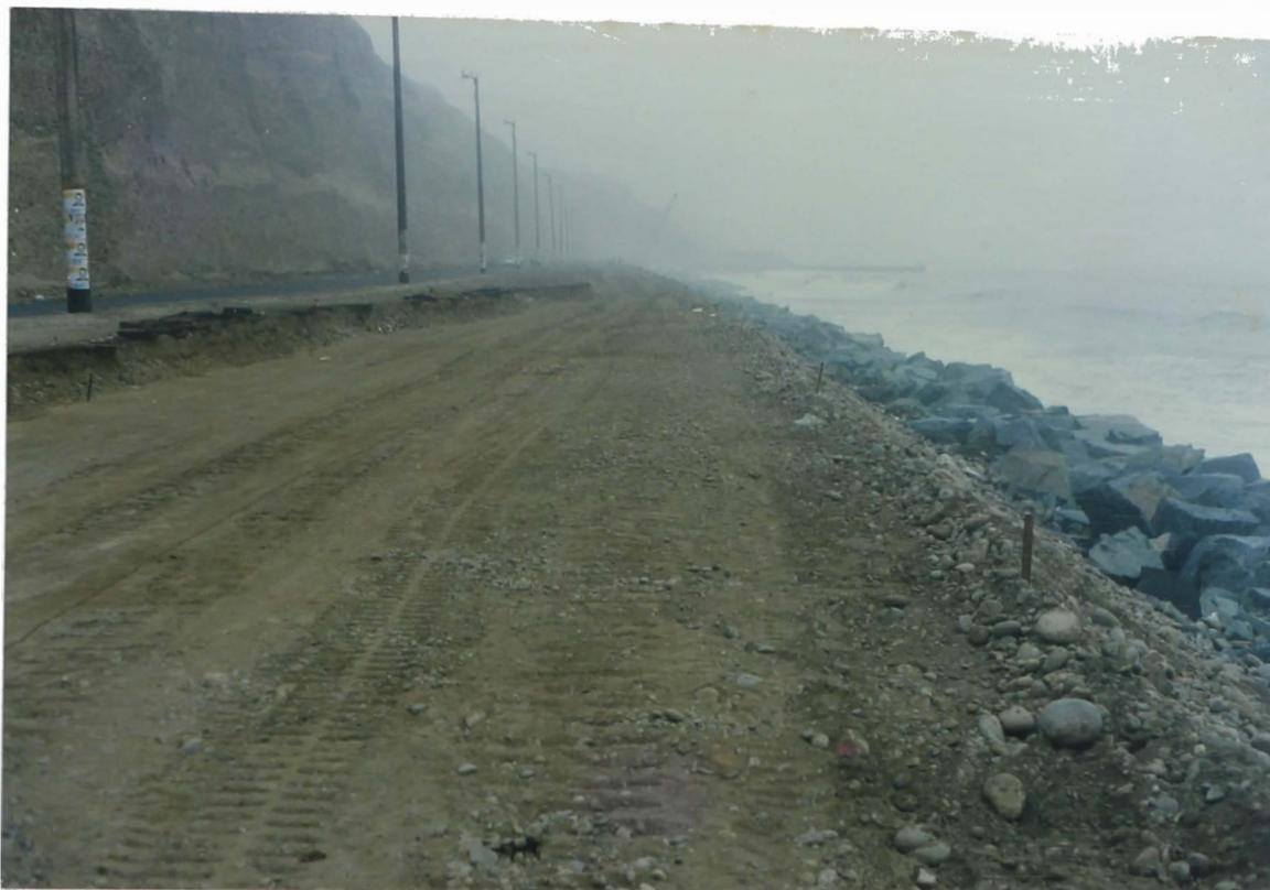
**FOTO N° 19:** Nivel de subrasante para la rehabilitación total del carril. Prog. (0 + 660 - 0+800).
