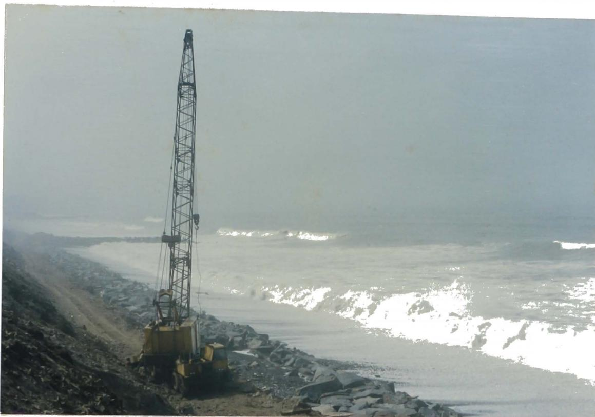
**FOTO N° 7:** Grúa de 35 ton. sobre ruedas para el izaje de unidades de roca de coraza de 4 a 5 ton.
