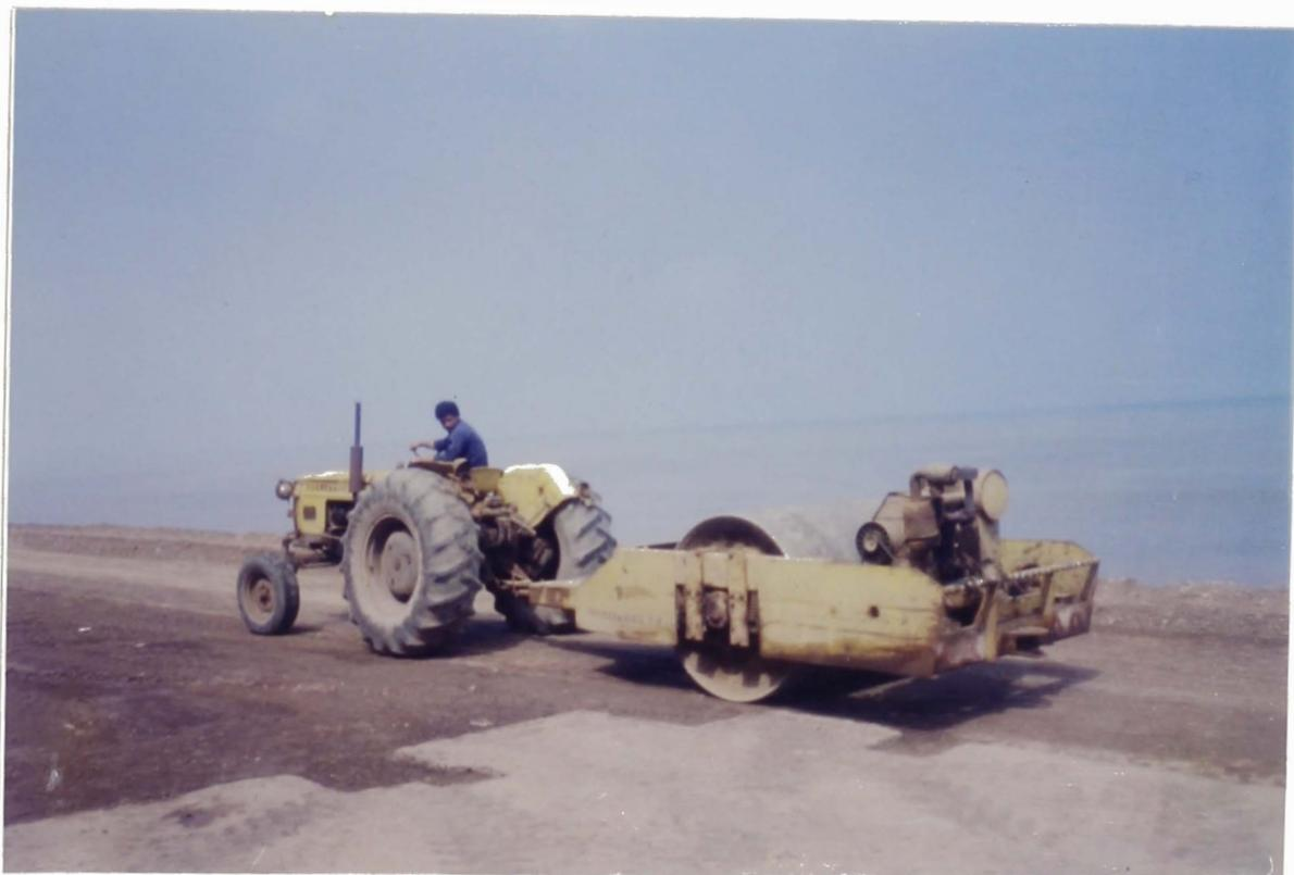
**FOTO N° 26:** *Compactación hasta obtener el 100% de la máxima densidad seca.*
