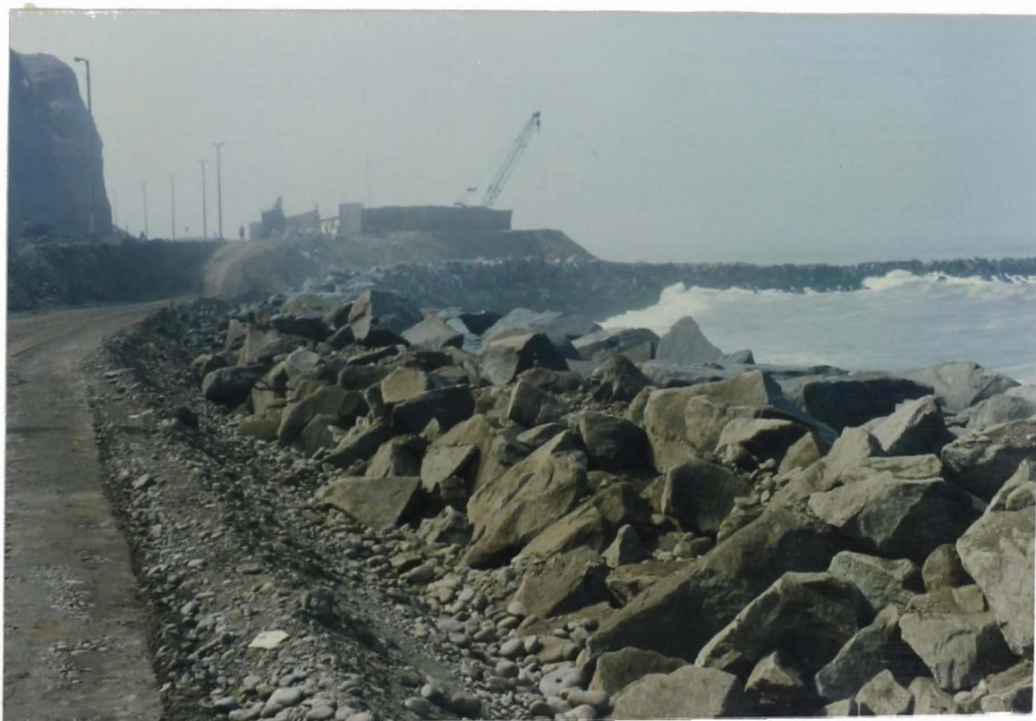
**FOTO N° 18:** *Relleno, explanación y compactación para nivelar hasta la subrasante, rimer tramo crítico, Prog. (0 + 100 - 0 + 200).*
