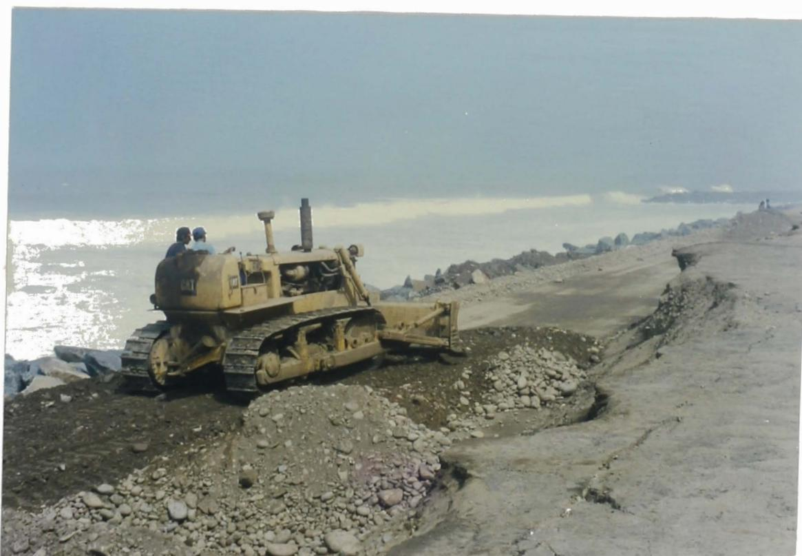
**FOTO N° 16:** *Material de préstamo de buena calidad (Conglomerado). En la explanación un tractor de orugas 190 HP.*
