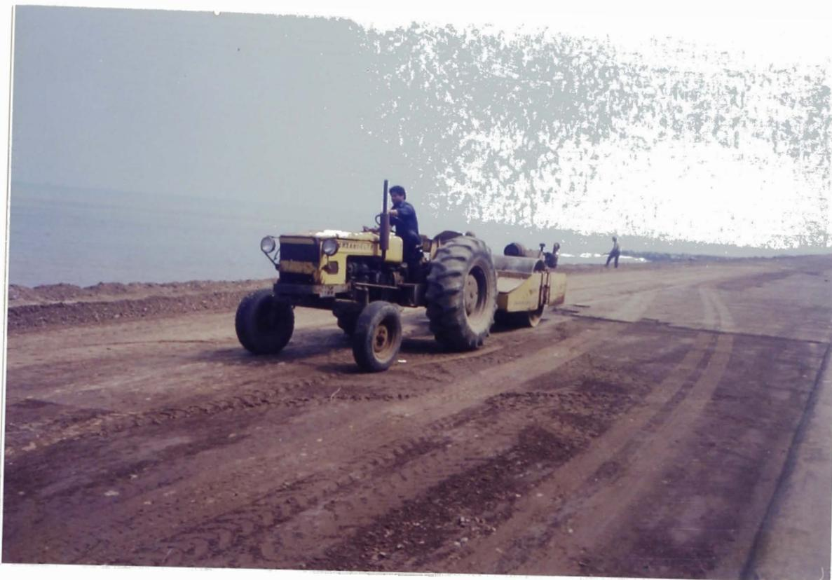
**FOTO N° 25:** *Compactación de la base con un rodillo de tiro de 5 ton. estático y 12 ton. vibrado.*
