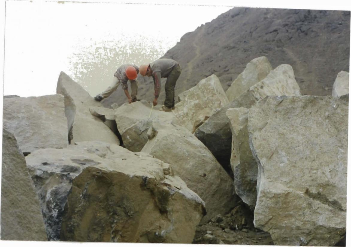
**FOTO N° 54:** *Cubicación de rocas para su seleccionamiento y medrado.*
