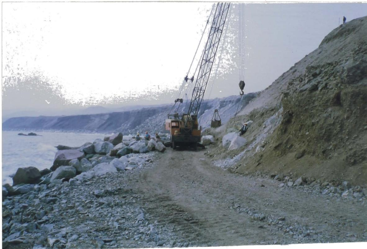
**FOTO N° 8:** Acceso necesario y complementario en el proceso constructivo. Es parte del relleno en el espaldar de la escollera.
