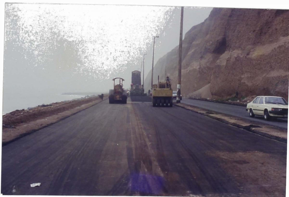
**FOTO N° 30:** *Asfaltado y compactación. Participación conjunta de la pavimentadora autopropulsada, rodillo liso de 3 ruedas de 12 ton. y rodillo neumático autopropulsado de 20 ton.*
