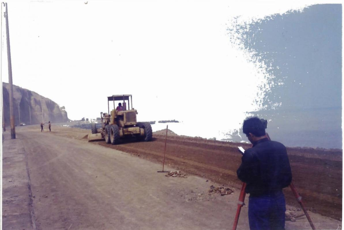
**FOTO N° 22:** *Verificación constante de los niveles para una junta perfecta de la carpeta &nueva con la existente.*
