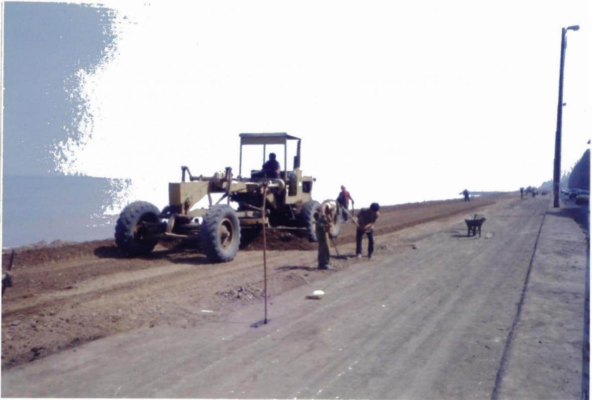
**FOTO N° 21:** *Tendido del material de base (afirmado). En la labor una motoniveladora de 125 HP.*
