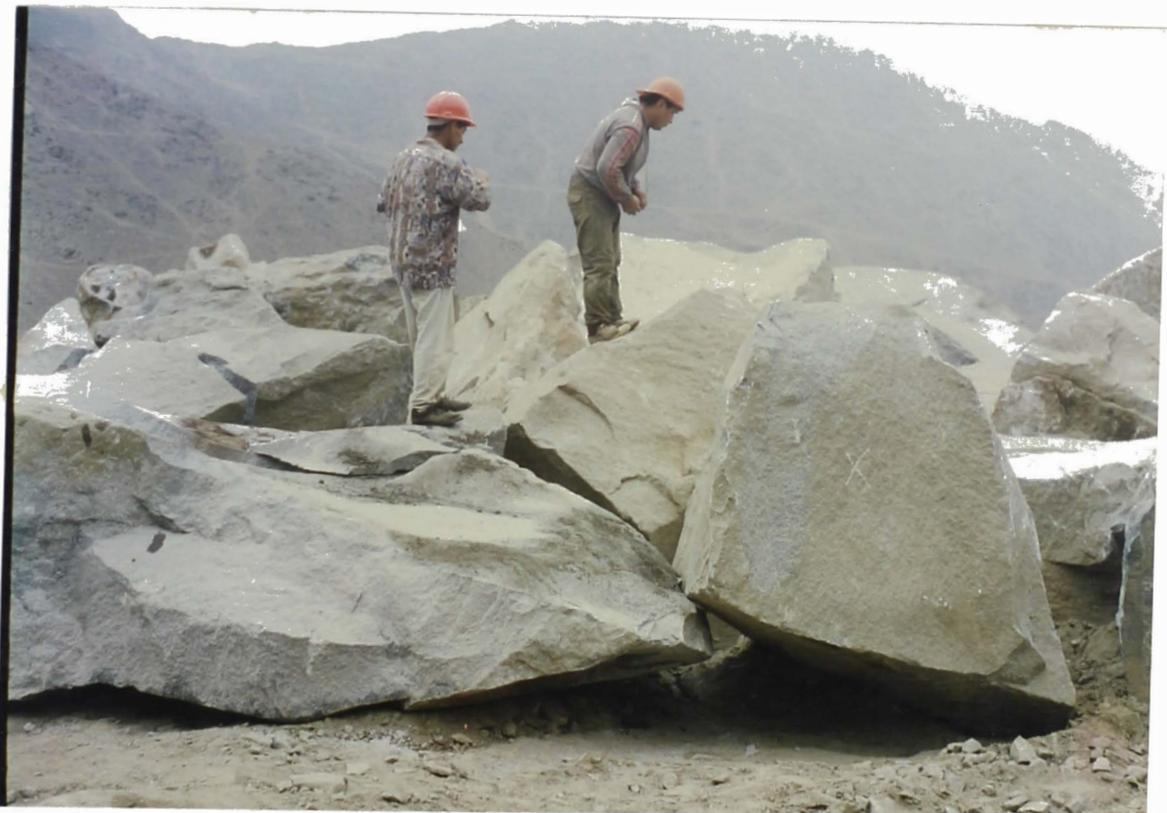
**FOTO N° 55:** *Las rocas deben reunir condiciones según especificaciones técnicas de no ser así son descartadas.*
