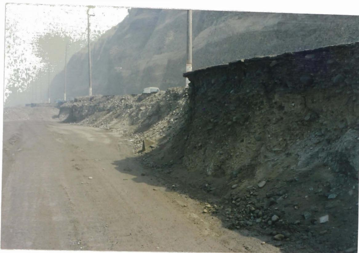
**FOTO N° 17:** *Relleno, explanación y compactación. Para nivelar hasta la subrasante. Segundo tramo crítico, Prog. (0 + 660 - 0 + 800).*
