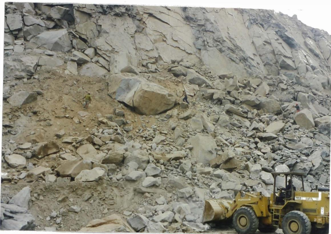
**FOTO N° 50:** *Remoción de material del talon después del corte. En plena labor un cargador frontal sobre ruedas de 125 HP y operarios con barretas en la parte alta.*
