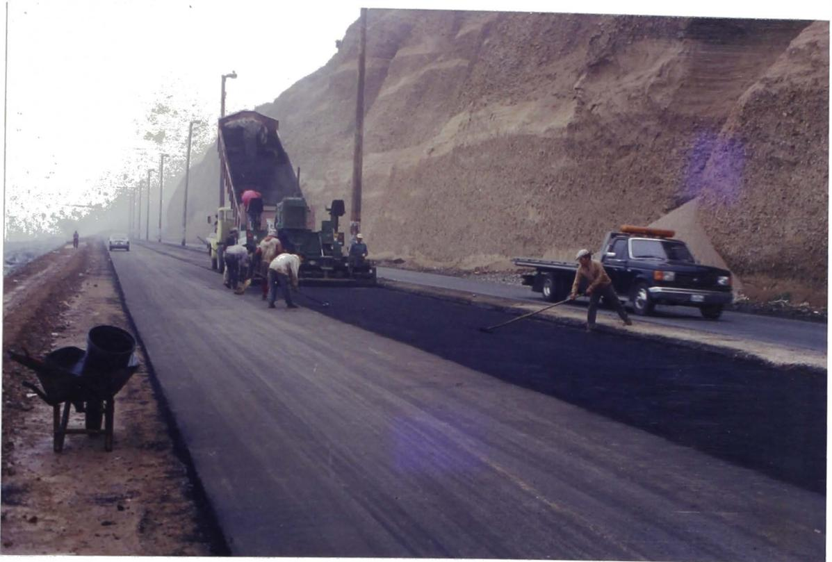
**FOTO N° 31:** Posterior a la distribución de la mezcla asfáltica es necesario el apoyo de personal en el pulido, con herramientas manuales para que la compactación sea uniforme.
