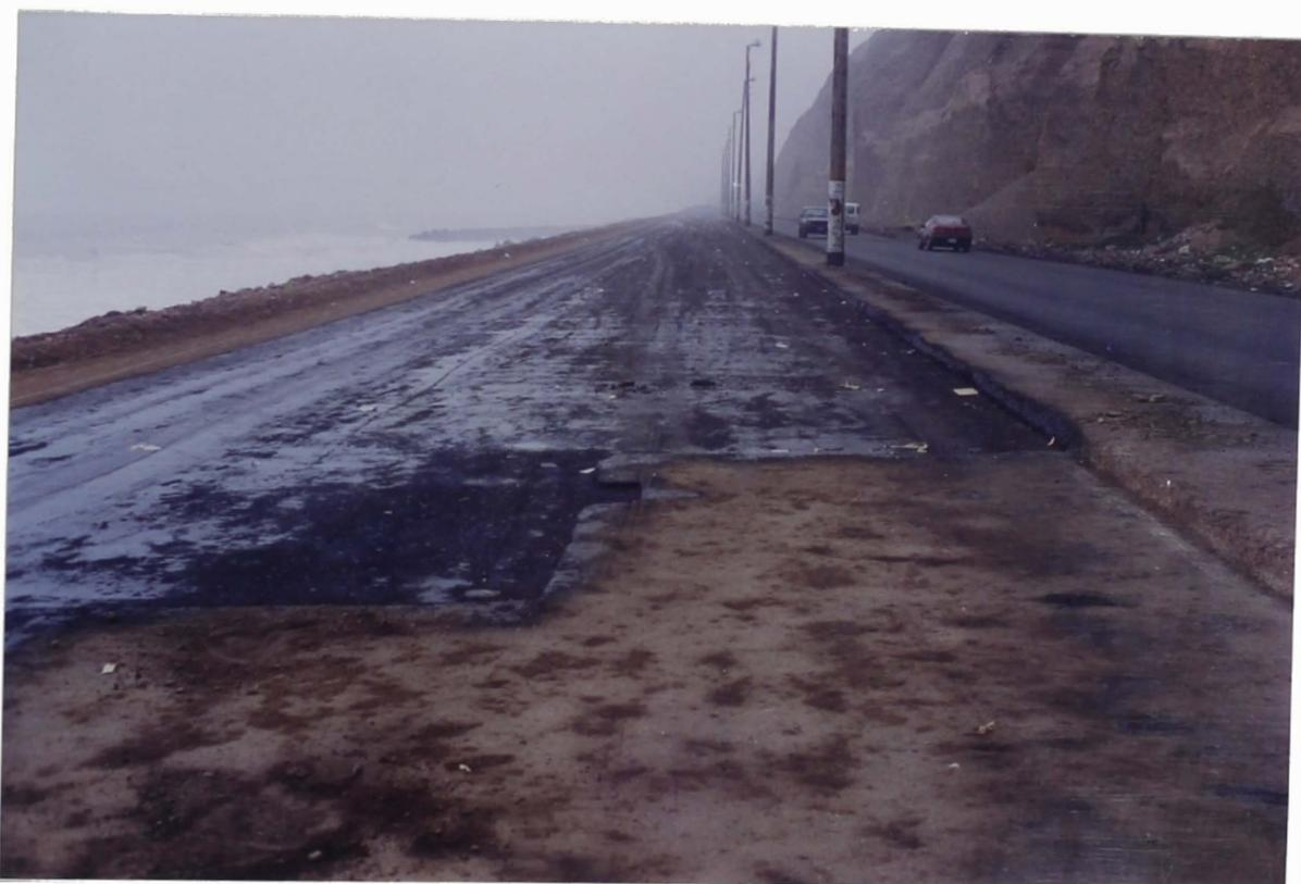
**FOTO N° 28:** *Imprimado total de la base para el carril completo. Primer tramo crítico. Prog. (0+00 hasta 0+200).*
