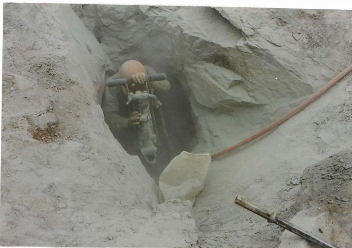
**FOTO N° 47:** *Preparación de un Calambuco para corte con voladura.*
