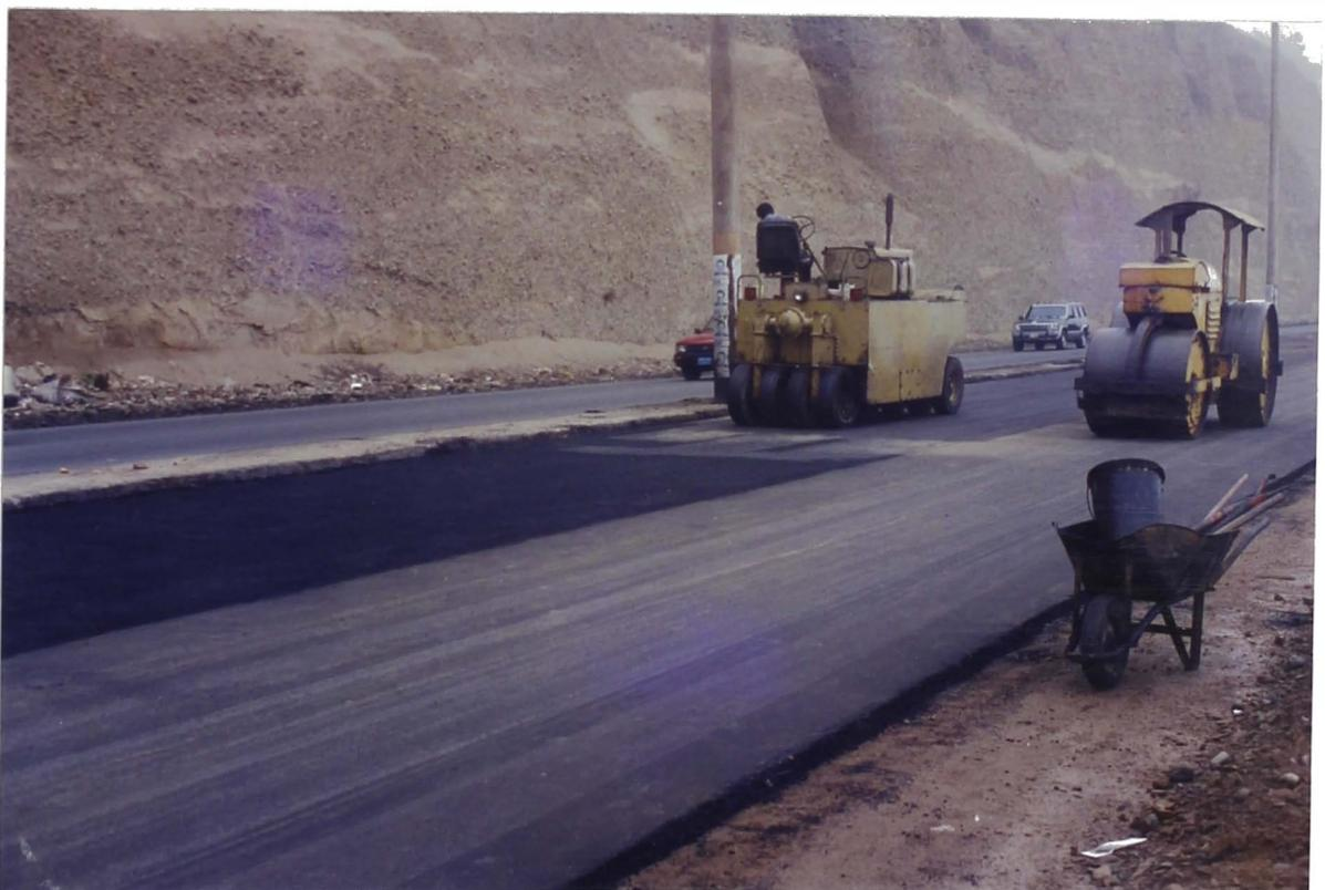
**FOTO N° 32:** La primera etapa de compactación es con un rodillo liso de 3 ruedas ( 12 ton.) y posteriormente para el acabado se compacta con un rodillo neumático de 20 ton. hasta lograr la compactación según lo especificado.
