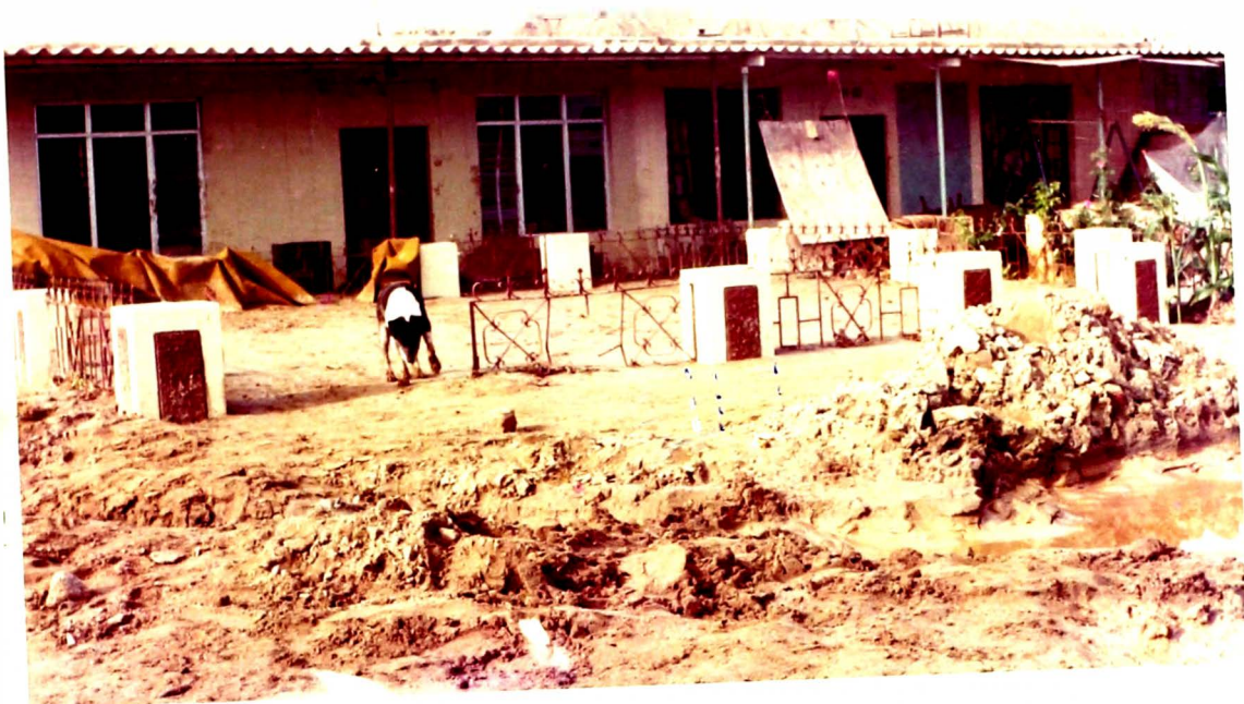
FOTO # 05: ARENAMIENTO DEL CASCO CENTRAL (AV.H)
