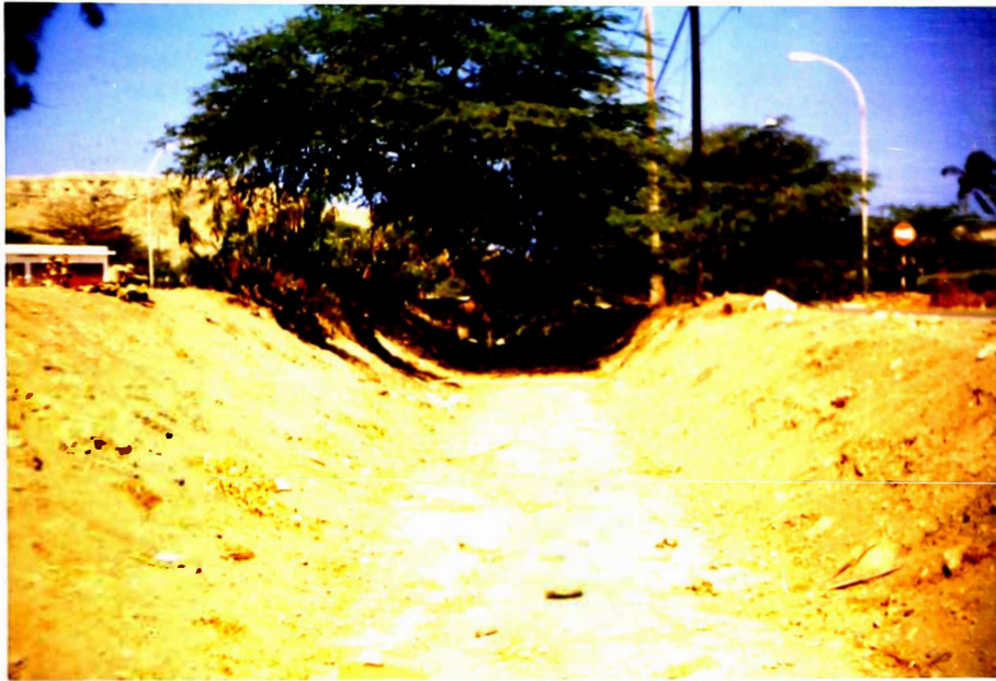
FOTO # 09: CANAL DE DRENAJE "SUR" DE PUNTA ARENAS
