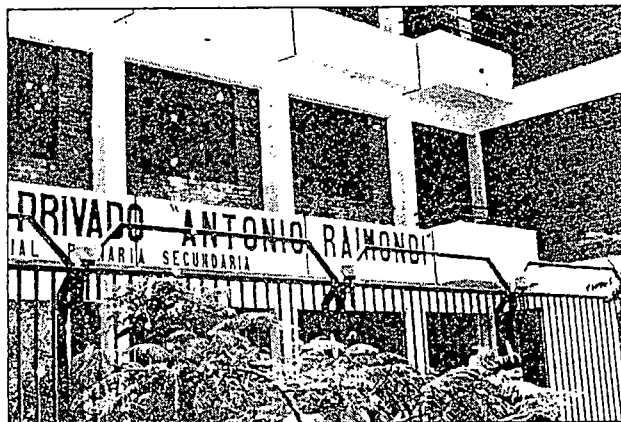
FOTO N° 40.- Colegio Antonio Raimondi. Nasca. Edificio de tres pisos de concreto armado y albañilería. No presenta daños.
