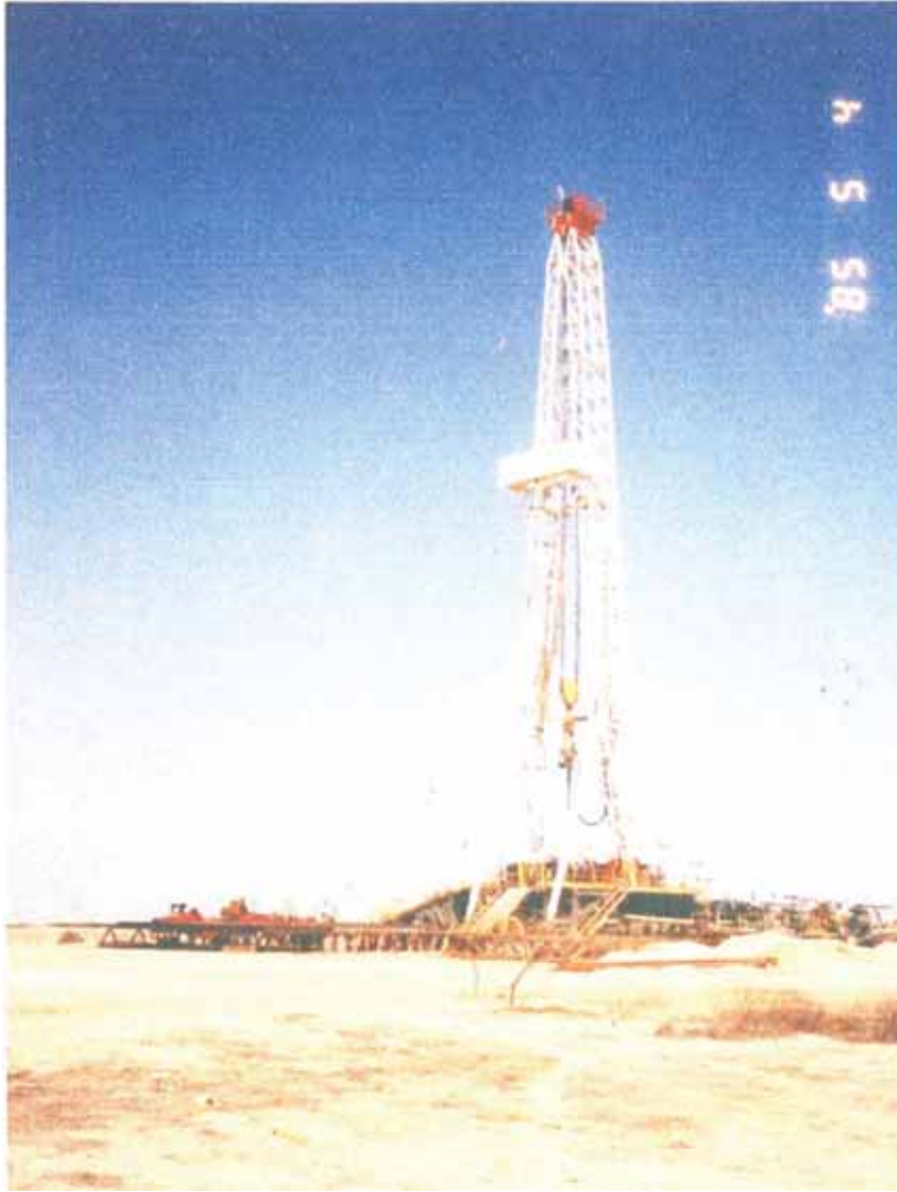
Foto I.7. Vista panorámica de un equipo de perforación.
