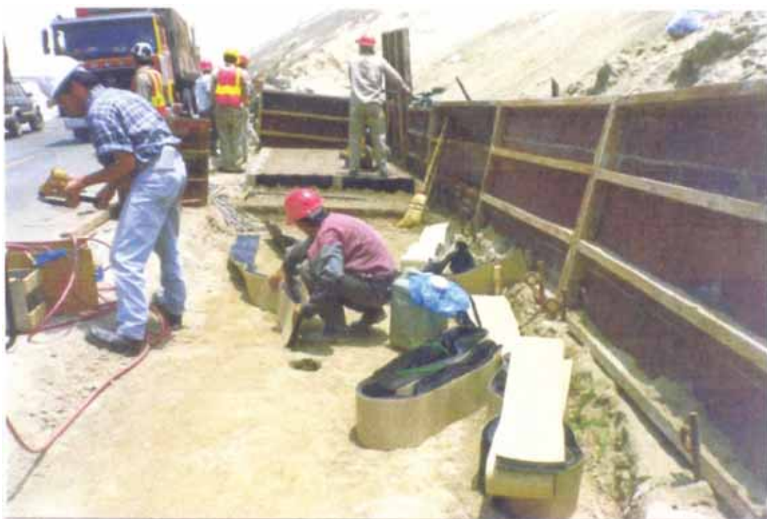
Vista 6.16.- Habilitación del Geoceldas para su colocación en el marco de madera
