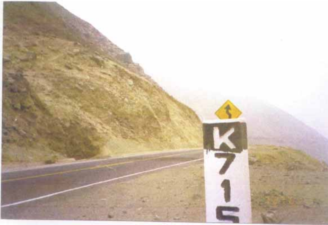
Vista 7.01.- Km. 715+00. Inicio del tramo ejecutado, se observa en buen estado el desquinche trabajado anteriormente
