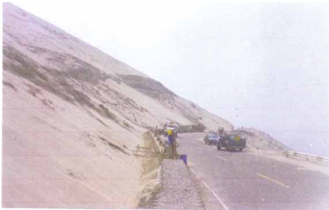
Vista 6.22.- Relleno de la ultima capa con grava.
