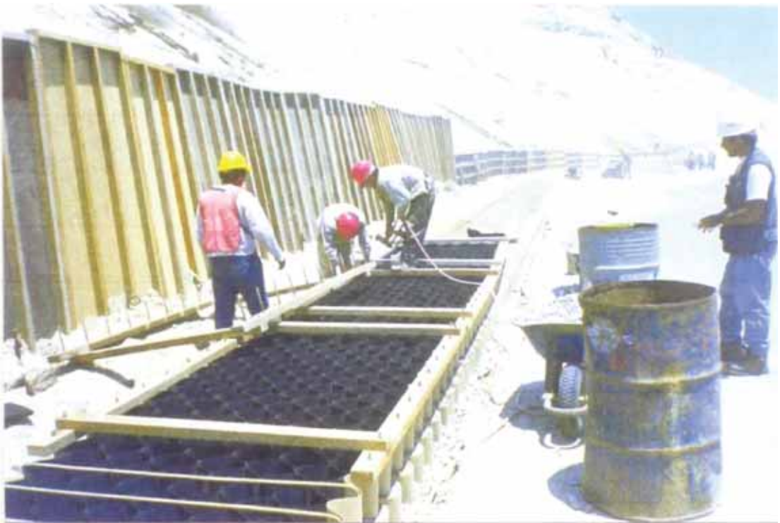
Vista 6.20.- Colocación de la segunda capa y su unión respectiva
