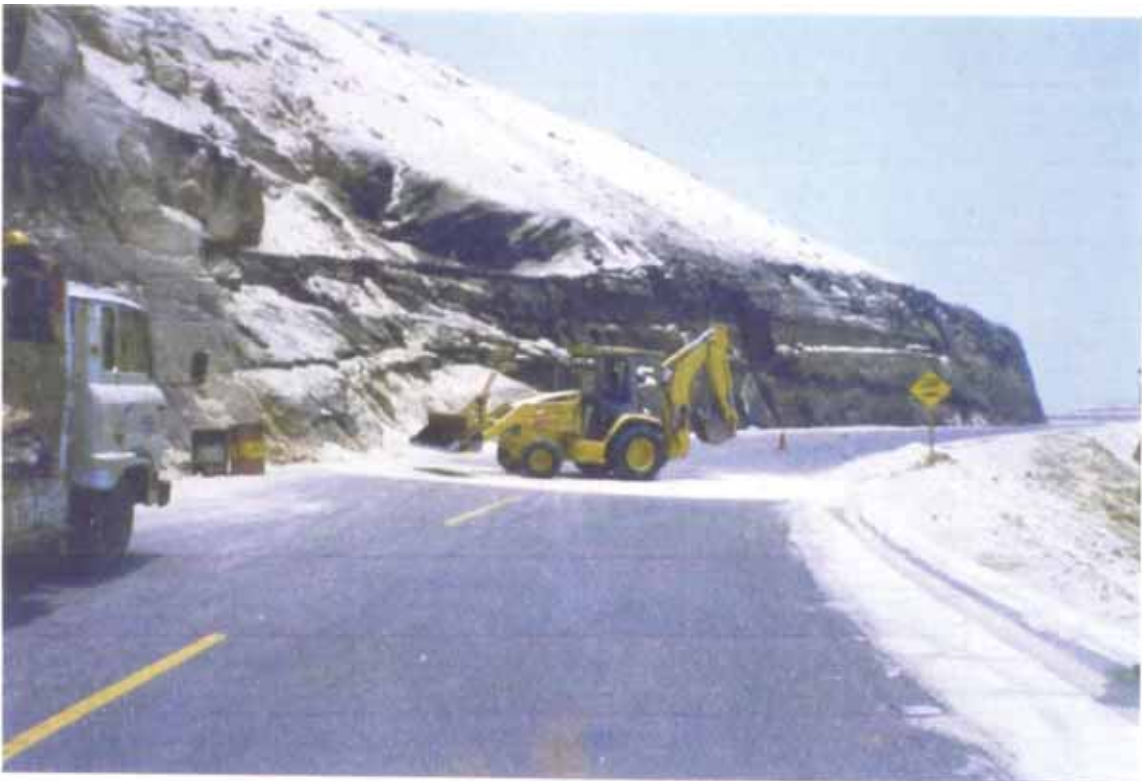
Vista 6.06.- Impregnación asfáltica en el km. 730+140 al 730+170 en talud de arena
