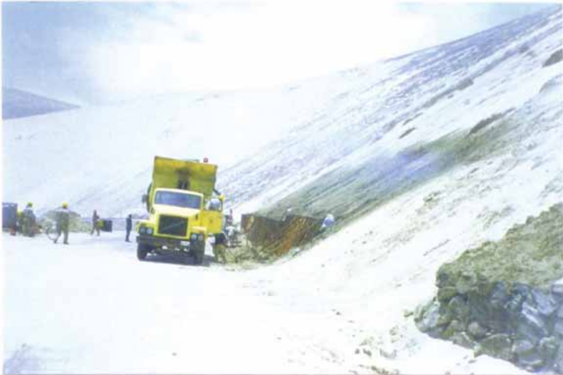
Vista 6.19.- Humedecimiento del talud para su contención momentánea
