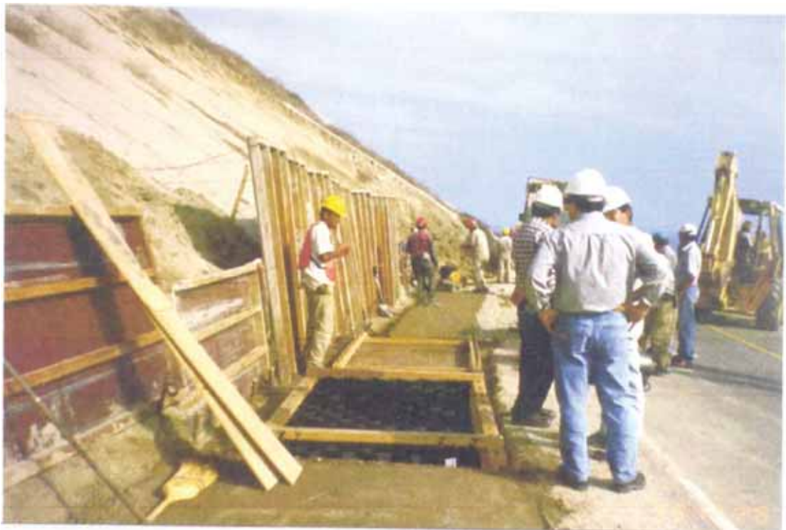
Vista 6.10.- Colocación de la base del muro de gravedad relleno con afirmado
