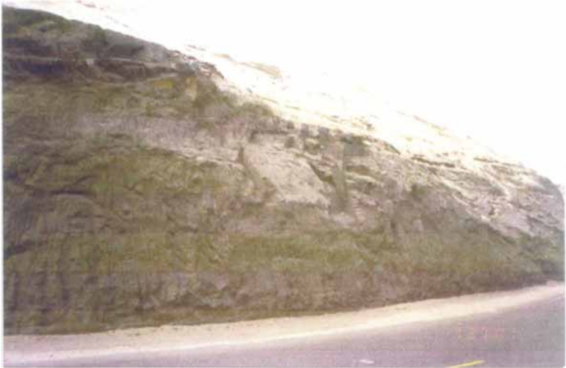
Vista 7.07.- Km. 730. Trabajo de Impregnación asfáltica intacta después del sismo
