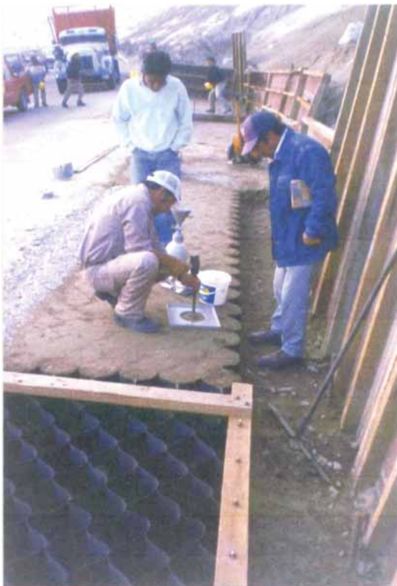
Vista 6.12.- Realización de la prueba de densidad
