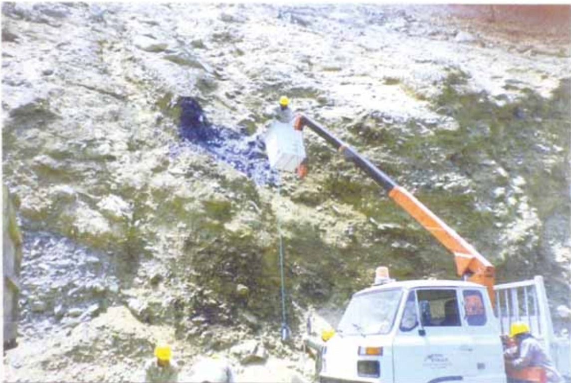
Vista 6.04.- Impregnación asfáltica en el km. 717+800 al 717+820
