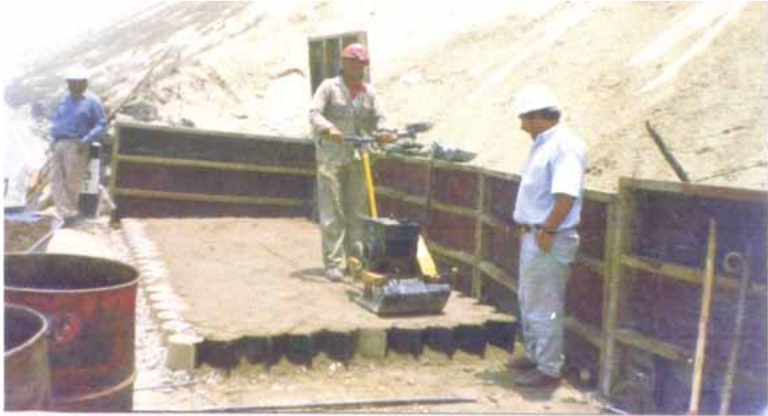
Vista 6.11.- Colocación de la primera capa rellanado y compactado con arena
