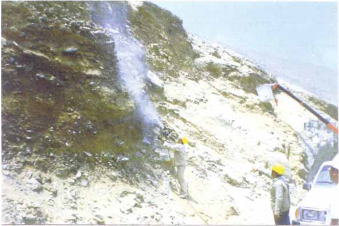
Vista 6.03.- Impregnación asfáltica en el km. 717+800 al 717+820
