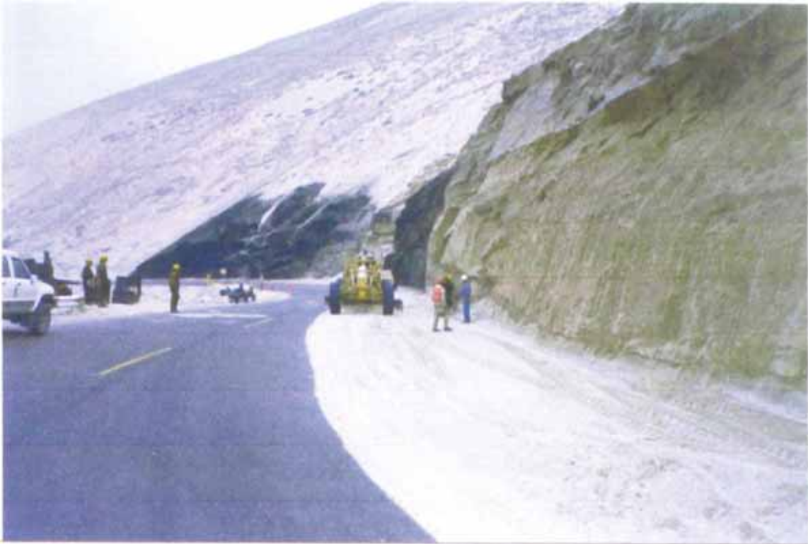
Vista 6.05.- Impregnación asfáltica en el km. 729+670 al 729+730 en talud de arena
