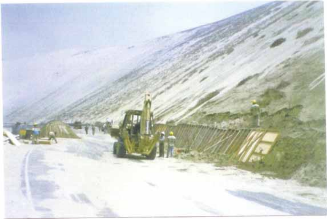
Vista 6.21.- Saturación del material para luego colocarlas en las geoceldas
