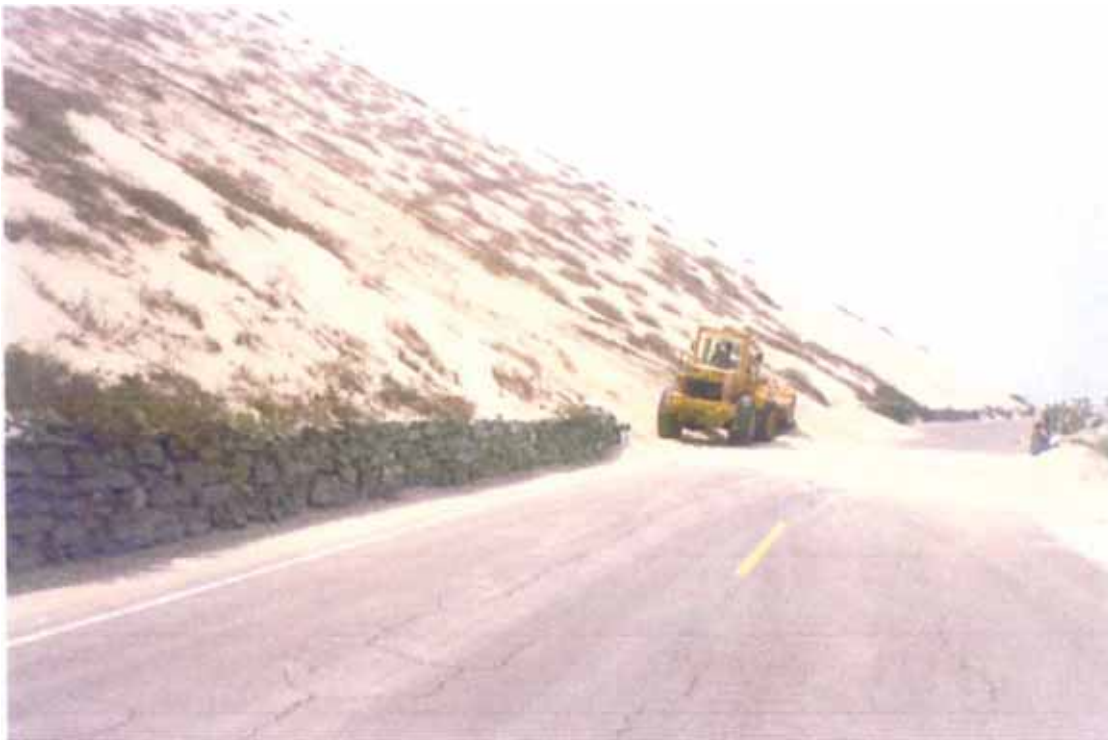
Vista 6.08.- Inicio del acarreo de material hacia el talud exterior
