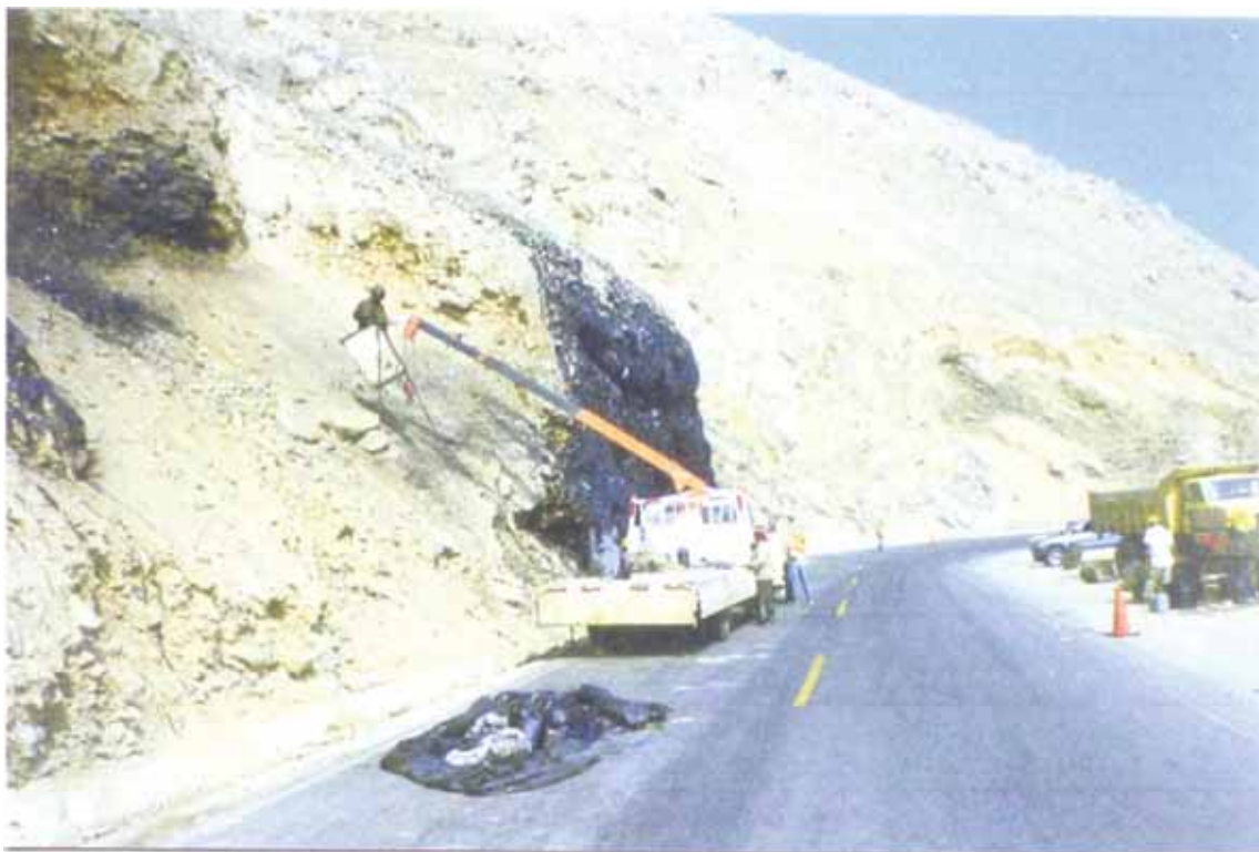
Vista 6.01.- Impregnación asfáltica en el km. 716+435 al 716+570
