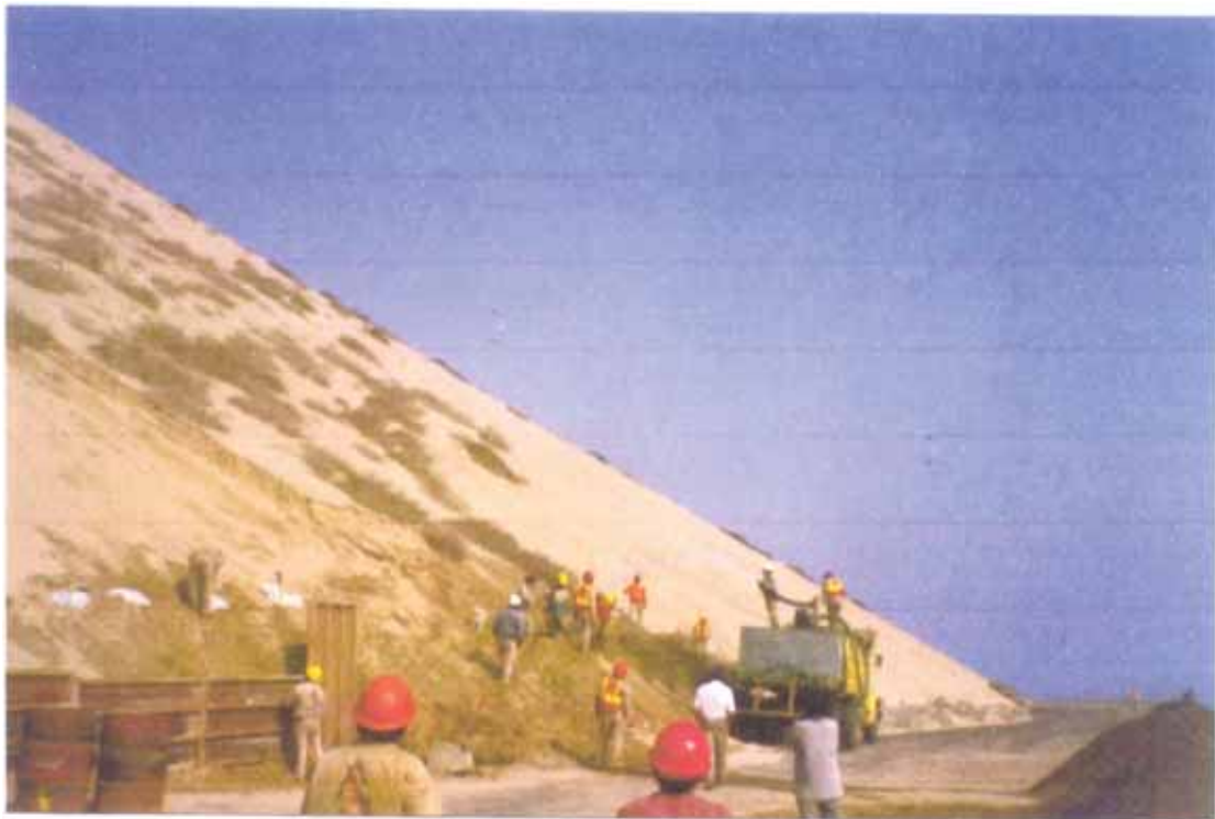
Vista 6.18.- Humedecimiento del talud para su contención momentánea
