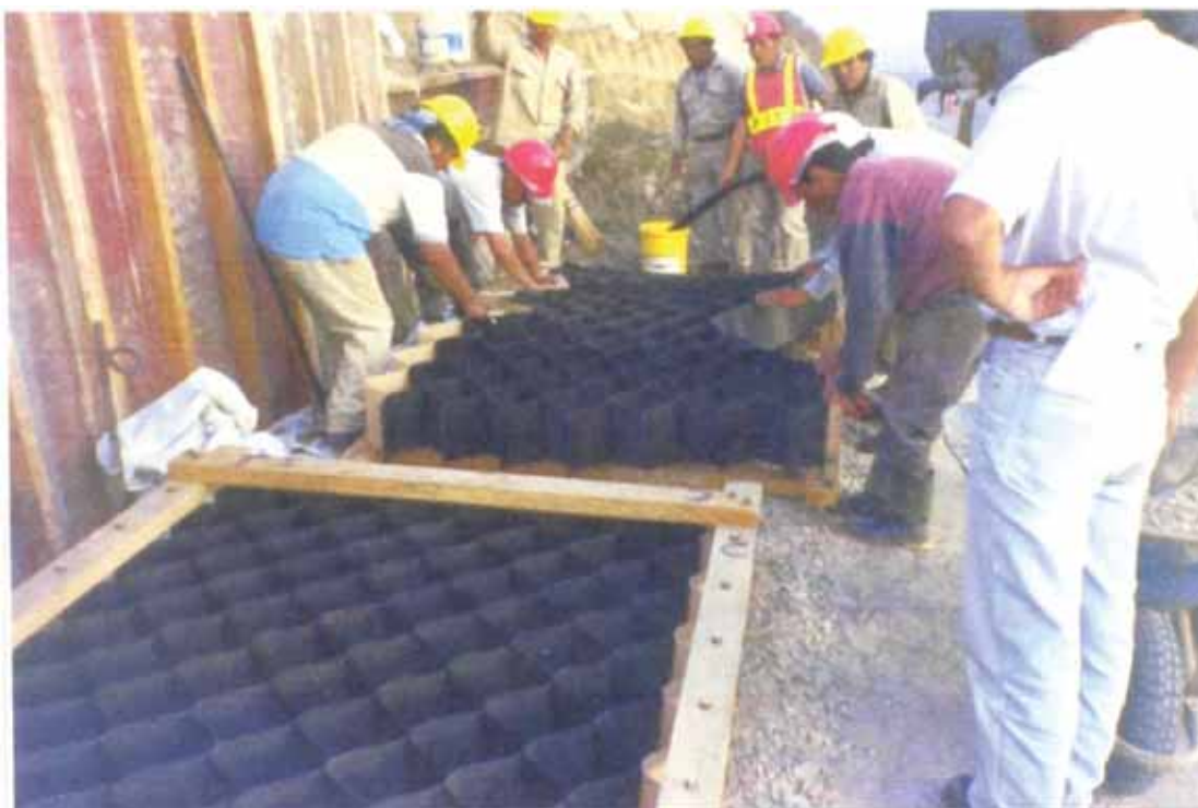
Vista 6.14.- Colocación del Geoceldas en el marco de madera para su respectiva colocación
