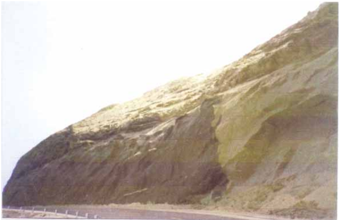
Vista 7.08.- Km. 730. Desprendimiento de la arena en la parte sin Impregnación asfáltica
