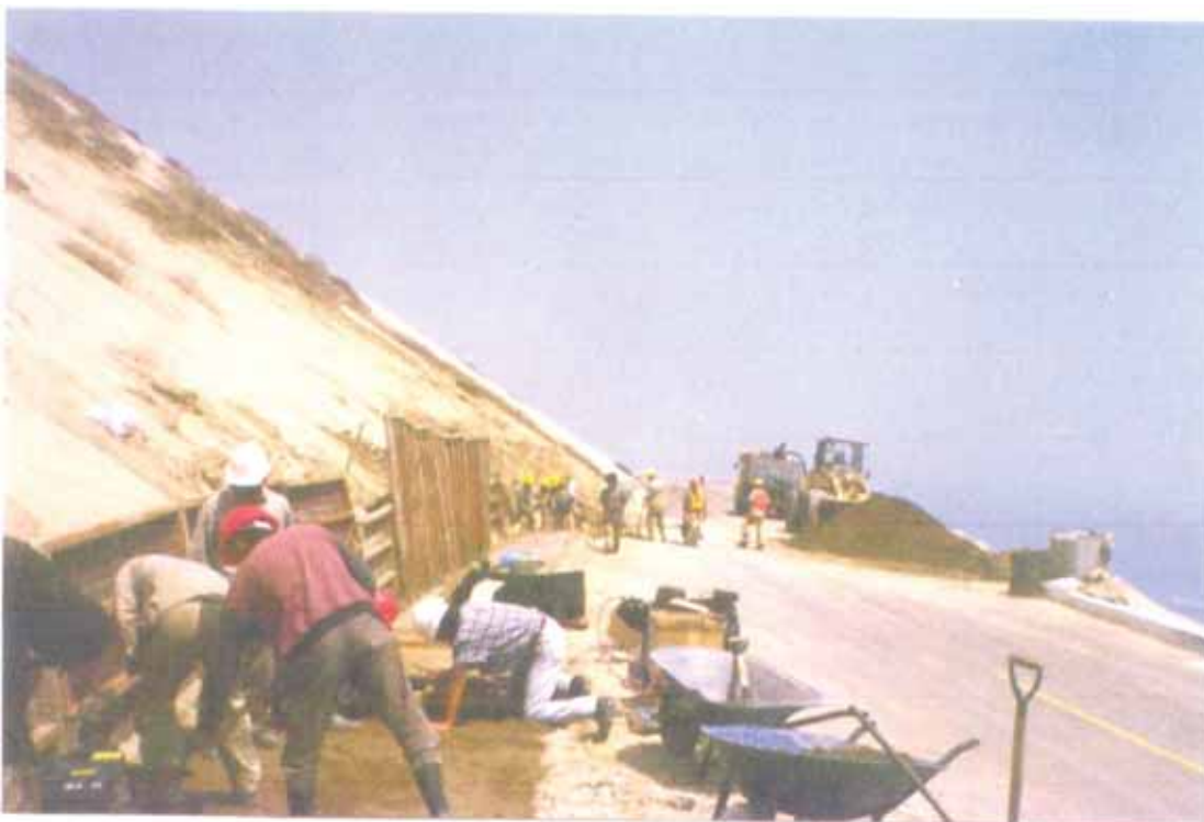
Vista 6.13.- Preparación de la base del muro
