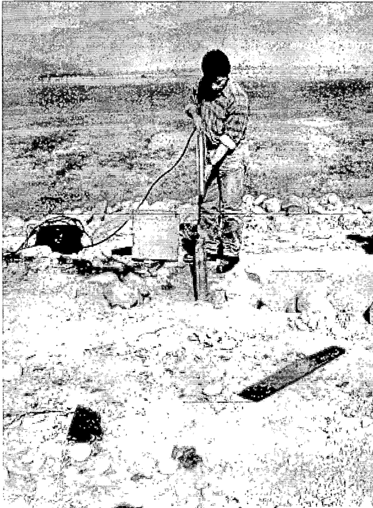
Foto 19. Colocacion del geófono triaxial dentro del pozo entubado (Presa Tinajones).
