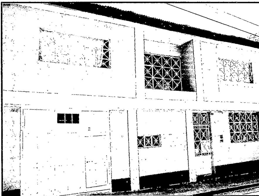
**Figura 7.20.-** Edificación de Albañilería con diafragma rígido y cobertura liviana.
