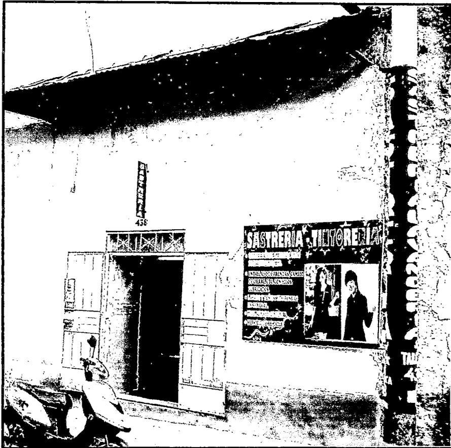
*Figura 7.28.- Edificación de Adobe con cubierta inestable de material liviano.*
