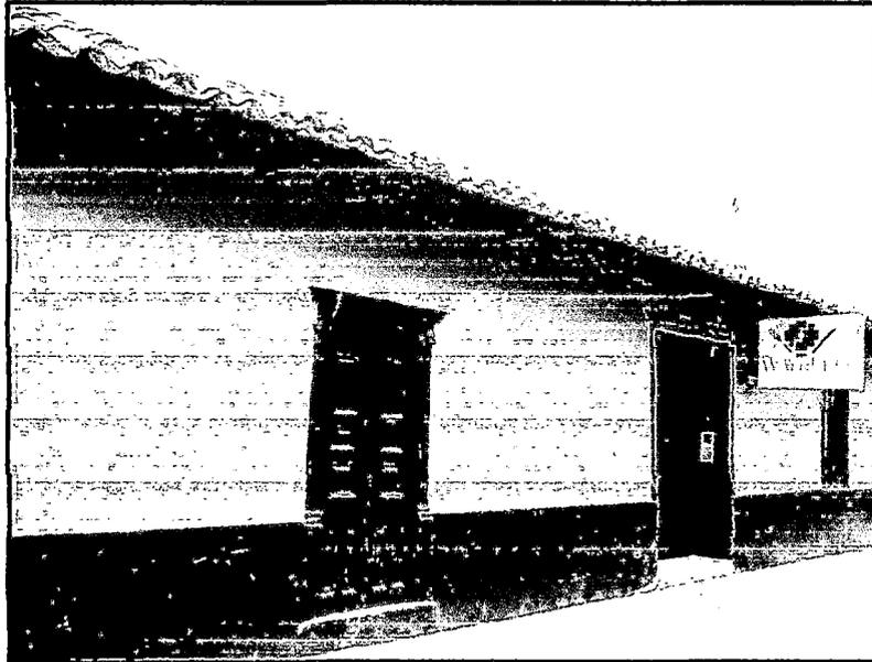
*Figura 2.2.- Edificación de adobe de 1 nivel en buen estado de conservación con cobertura liviana de teja.*
