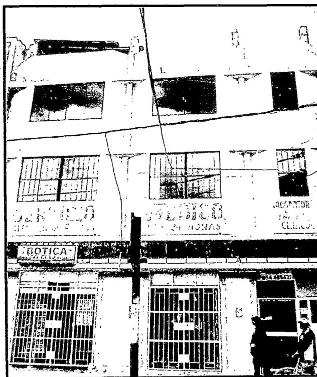
**Figura 7.24.-** Edificación de Concreto Armado con una adecuada distribución de masas en los tres niveles.
