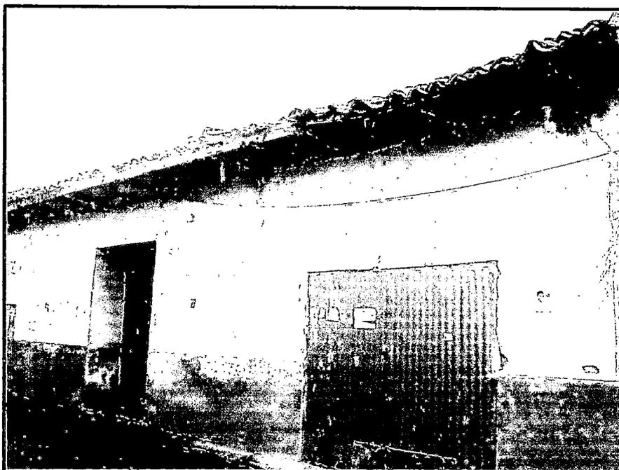
**Figura 7.19.-** Edificación de Adobe con techo conformado por un entramado de viguetas y listones de madera en estado deflectado.
