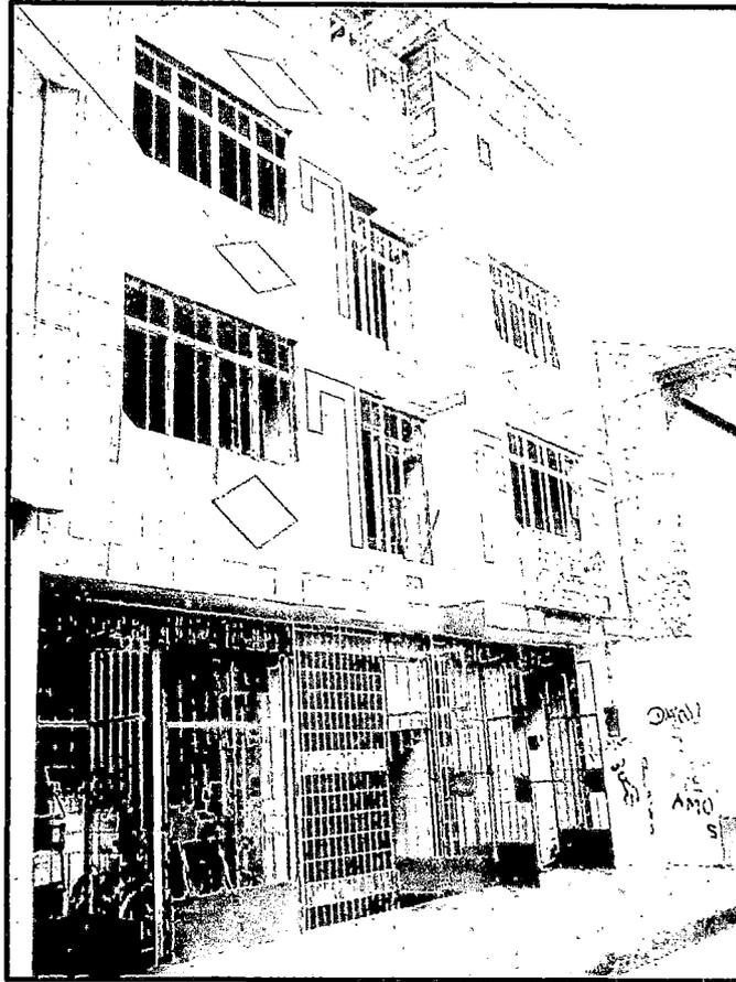
Figura 7.21.- Edificación de Concreto Armado con diafragma rígido y cobertura liviana.
