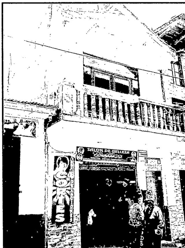
*Figura 7.32.- Edificación de Albañilería con volado y balcón con buena conexión al sistema resistente, sin embargo presenta parapetos sin confinar*
