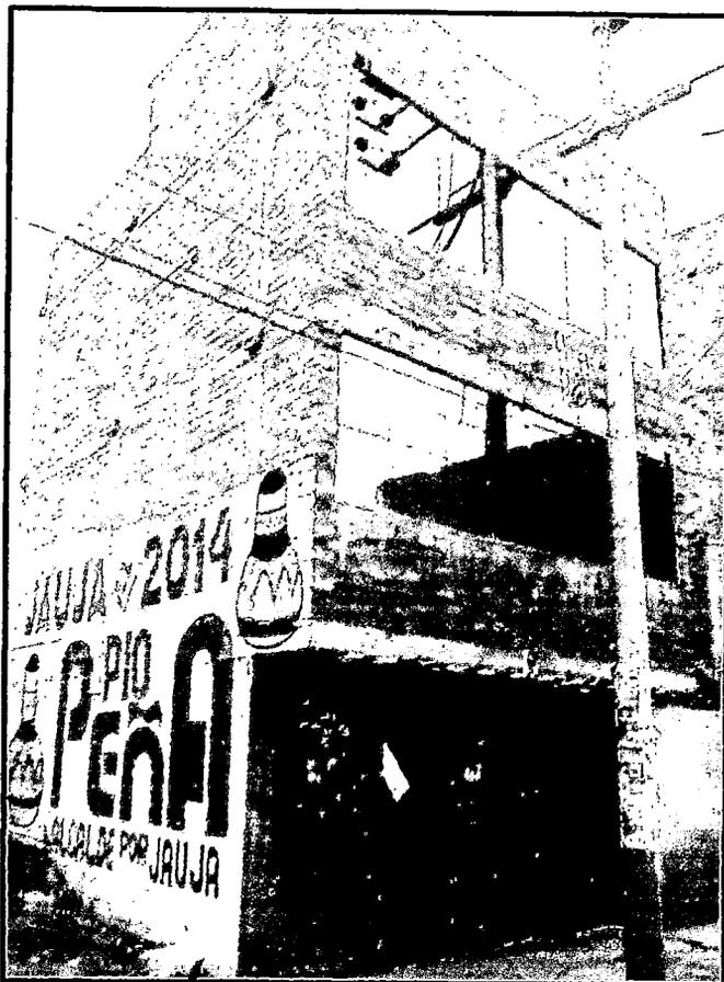
Figura 7.4.- Edificación de Albañilería adecuadamente confinada.
