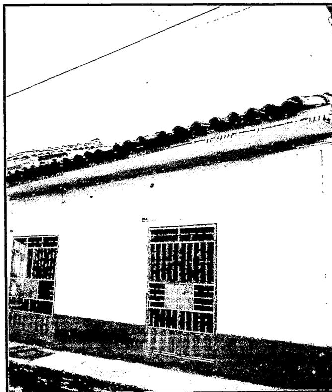
*Figura 7.18.- Edificación de Adobe con techo conformado por un entramado de viguetas y listones de madera en buen estado con pequeñas deficiencias.*
