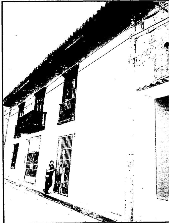
*Figura 7.17.- Edificación de Adobe emplazada sobre terreno con pendiente pronunciada.*
