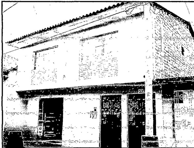
**Figura 2.5.-** Edificación de albañilería de 2 niveles sin confinamiento horizontal en el último nivel y con cobertura liviana de teja.
