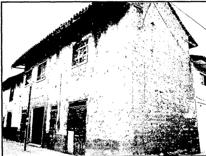
*Figura 7.34.- Edificación de Adobe en mal estado de conservación.*
