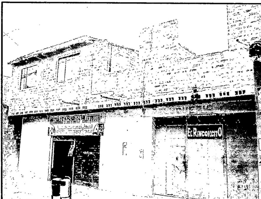
*Figura 7.31.- Edificación de Albañilería con parapetos sin confinar.*
