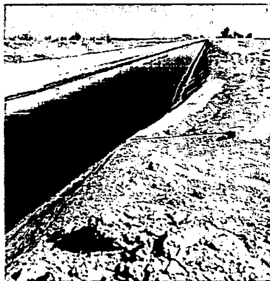
FOTOGRAFIA 1.15 Desplazamiento de paredes en canales, Valle Imperial 1979 (Foto: Base de Datos U.S. Geological Survey - USGS)
