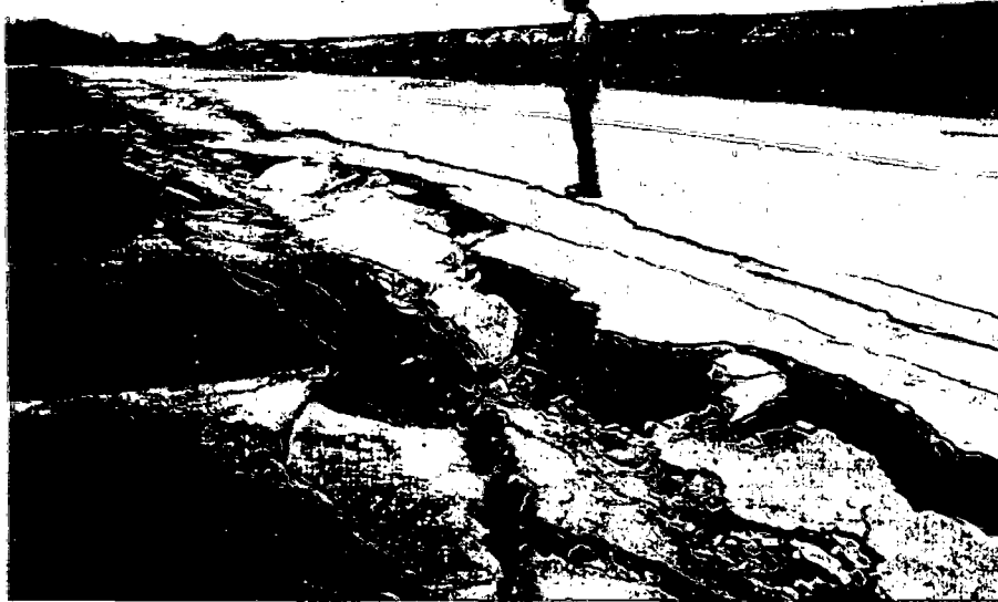
FOTOGRAFIA 1.23 Grietas post sismo en líneas viales, Loma Prieta 1987 (Foto: Base de Datos U.S. Geological Survey - USGS)
