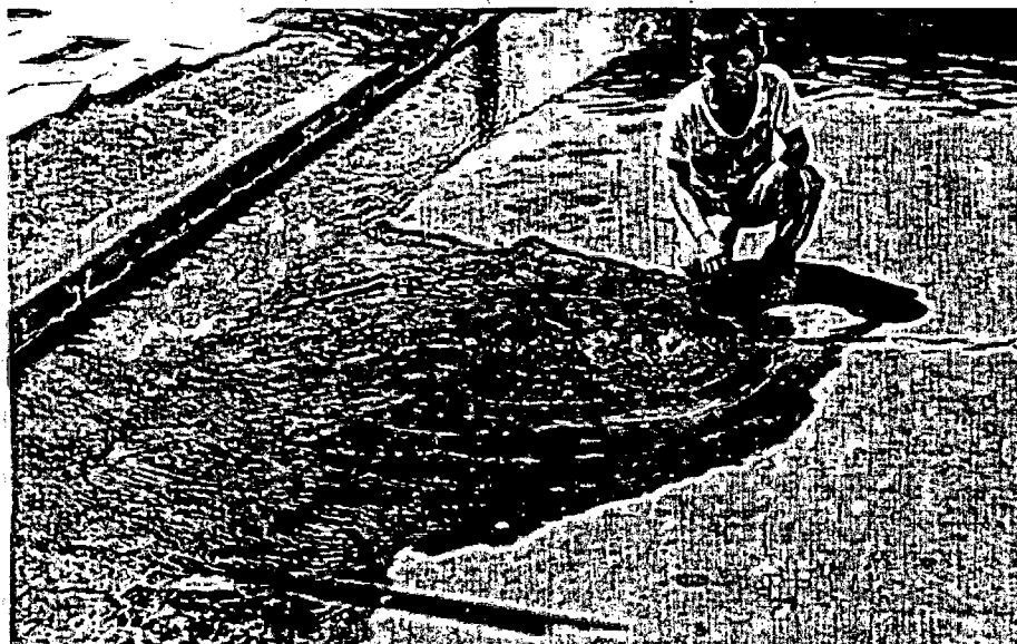
FOTOGRAFIA 1.10 Rupturas de tuberías en el sistema de agua, Managua 1972 (Foto: Base de Datos U.S. Geological Survey - USGS)
