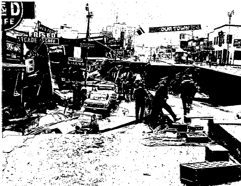
FOTOGRAFIA 1.6 Hundimiento del suelo en el centro de Anchorage, Alaska 1964 (Foto: Base de Datos U.S. Geological Survey - USGS)
