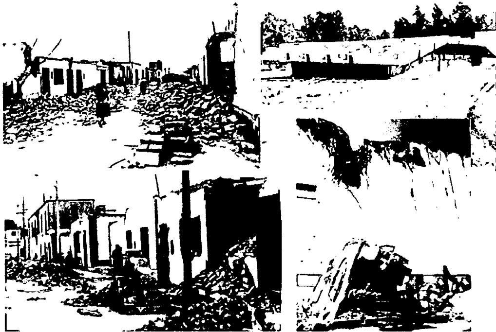
Figura 4.12: Daños ocurridos durante el sismo de Lima del 03/10/1974.
