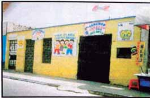
Figura 5.23 C.E.I. Sagrada Familia de Breña, con tipología conformado por albañilería sin refuerzo.
