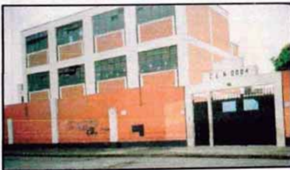
Figura 5.20 C.E. Primaria Mariano Melgar con tipología conformado con estructuras de concreto armado con placas.
