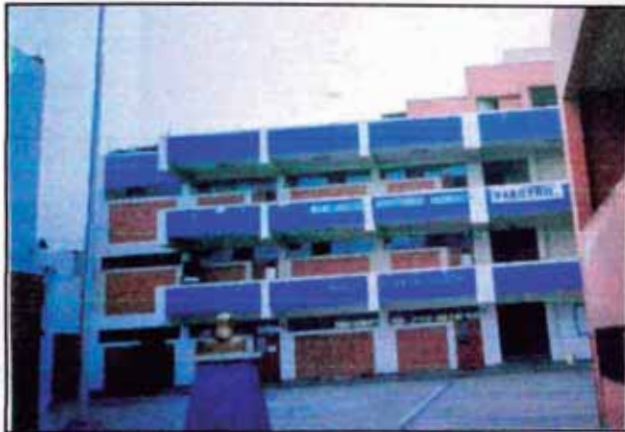
Figura 5.19. C.E. Secundaria Micaela Bastida con tipología conformado por pórticos con muros portantes.
