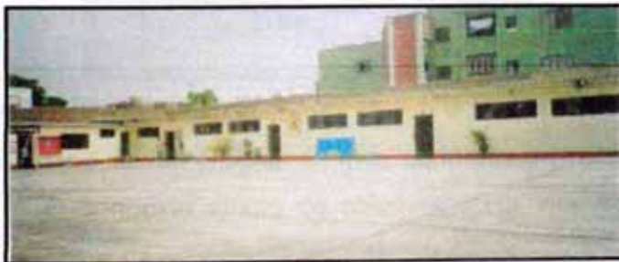
Figura 5.22 C.E. Yolanda Prieto con tipología conformado por albañilería confinada con diafragma flexible.
