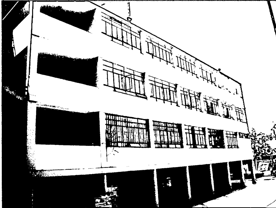
Fig. 2.5: Edificio G4. Actualmente en el primer piso funcionan los Laboratorios de Hidráulica, en el segundo piso oficinas, en el tercer piso biblioteca y cuarto piso sala de lectura. El último nivel también fue añadido en el proyecto de 1969.
