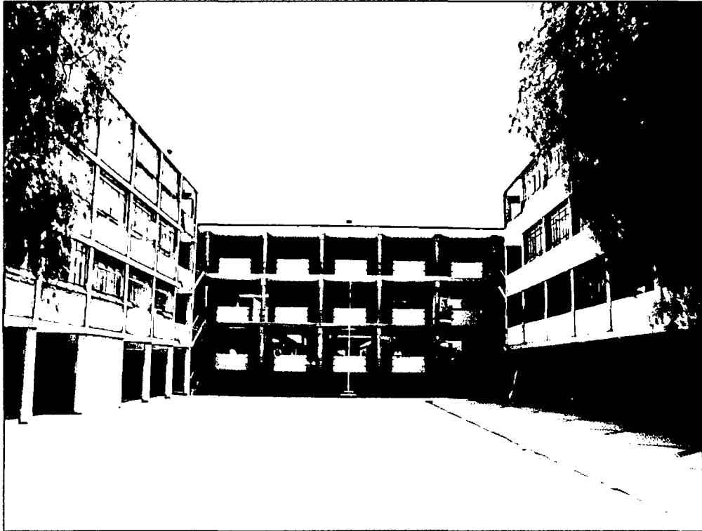
Fig. 2.3: Edificio G2. Pabellón de aulas. Inicialmente también de dos pisos. En 1969 se construyó el tercer nivel.
