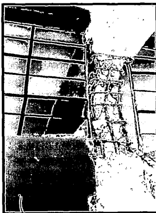
Fotografía 2.2: Falla por columna corta
