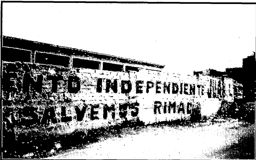
Fotografía N° AV.2: CE N° 3012 (El Altillo), Muro de cerco con peligro de volteo hacia el patio de recreo, deterioro por causa de caídas de aguas de las viviendas ubicadas frente al CE; no tiene arriostramiento, construcción informal de mala calidad.
