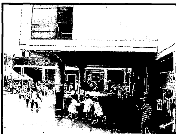
Foto N° 3.11: Patio de recreo, se observa un cambio de rigidez entre el segundo y el primer nivel
