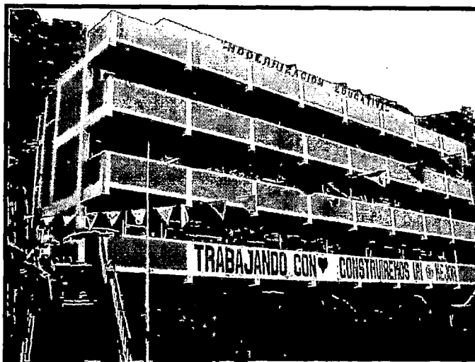
Foto N° 4.1: Módulo de 4 Niveles, construido en los años 80
