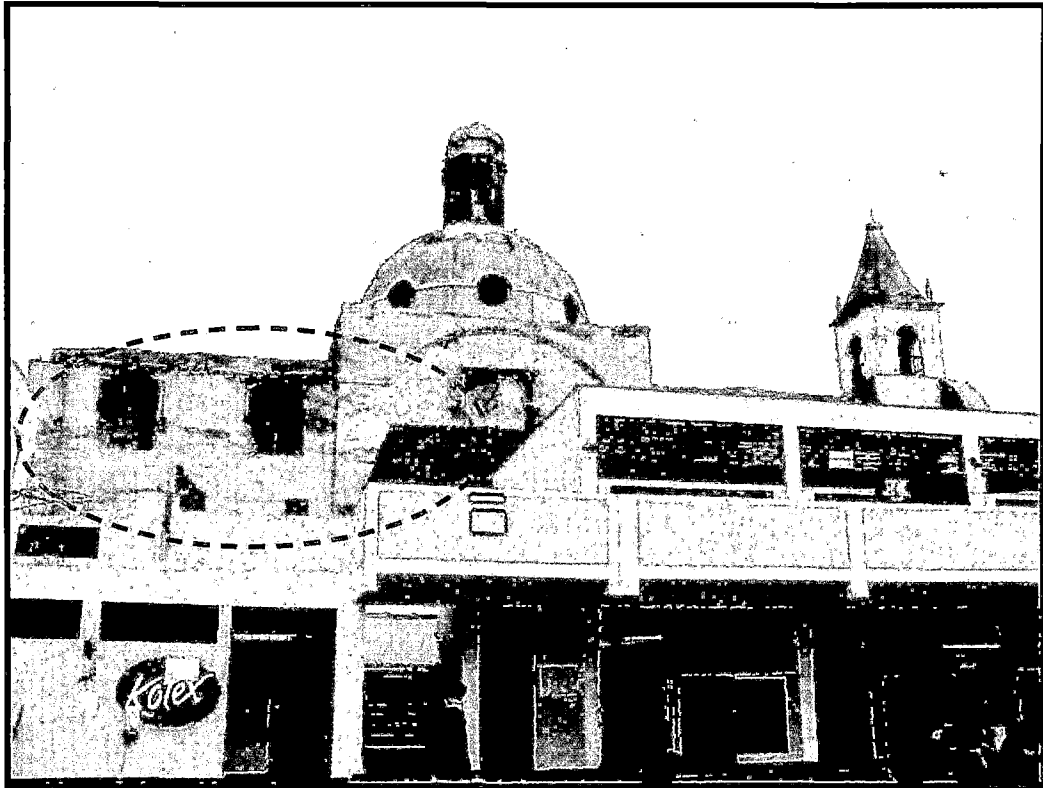
CE LUCIE RYNNING: Fotografía N° AV.13 (arriba): Peligro de desplome de los muros de adobe de la iglesia que están junto al pasadizo de ingreso al colegio; Fotografía N° AV.14 (abajo): los muros principales de la iglesia están afectados en toda su base por problemas de humedad.
