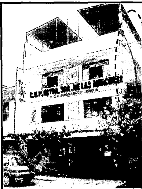
Foto N° 3.7: CEP Ntra. Sra. de las Mercedes, en los muros perimetrales de los niveles superiores se ha utilizado ladrillos tipo pandereta
