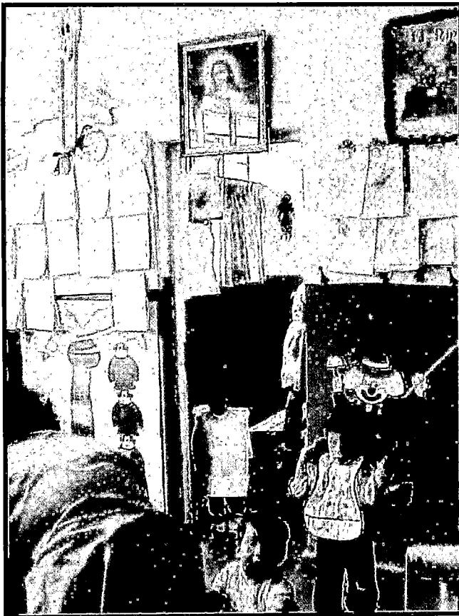
CEI 392-2 (Cuna Madrid): Fotografía N° AV.16: Anteriormente estos ambientes pertenecieron a una posta médica, en caso de un sismo no tienen los espacios necesarios para poder evacuar a los niños que ocupan este CE.
