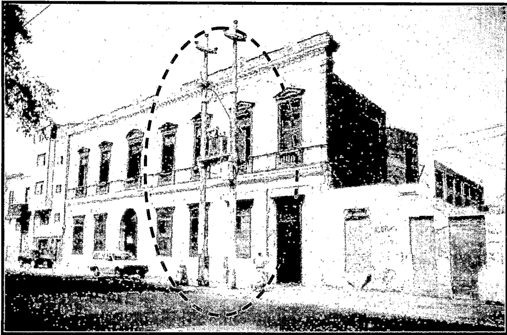
Fotografía N° AV.3: CE Manuel Pardo : para tener acceso al centro hay que pasar por una edificación muy antigua que es amparada por el INC, que evita su demolición. La edificación es de madera en muy mal estado de conservación. Como se puede apreciar existe una Sub-estación de Luz que se encuentra frente a la edificación.
