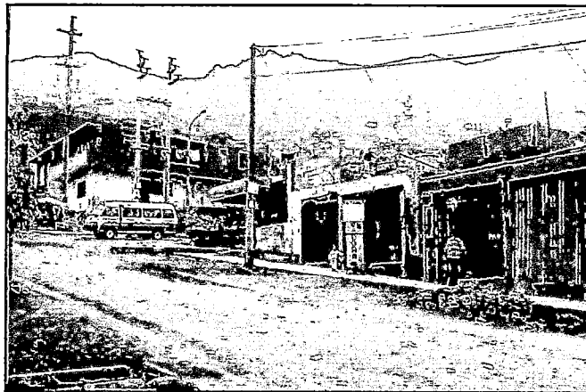
Fig.7-9 En esta zona, las viviendas se construyen sobre terrenos con pendiente pronunciada.
