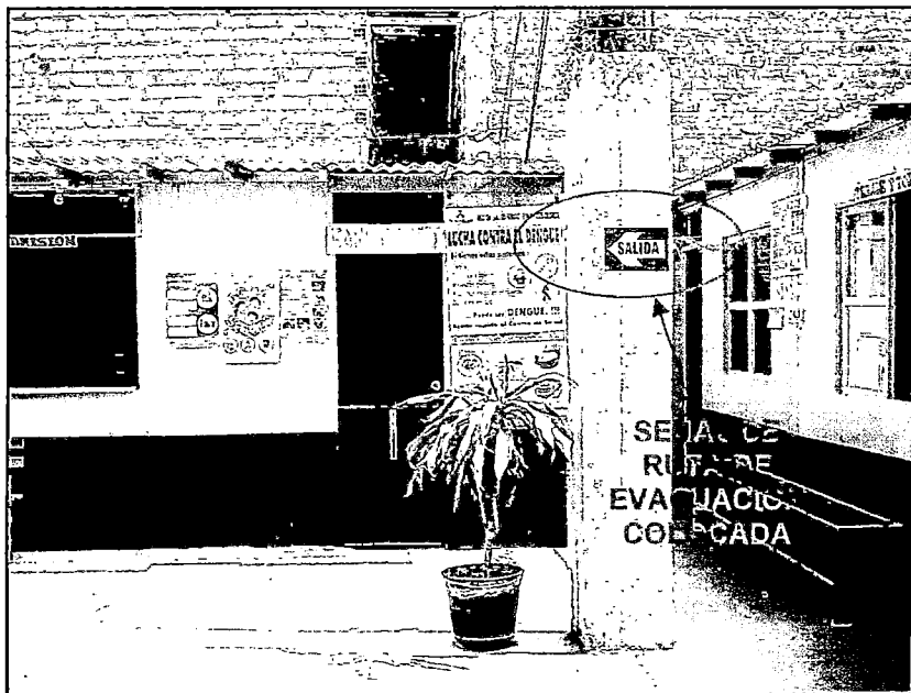
Fig. 8-11 PUESTO DE SALUD LOS ANGELES Se observa la señalización de las rutas de evacuación. Fuente: Elaboración Propia
