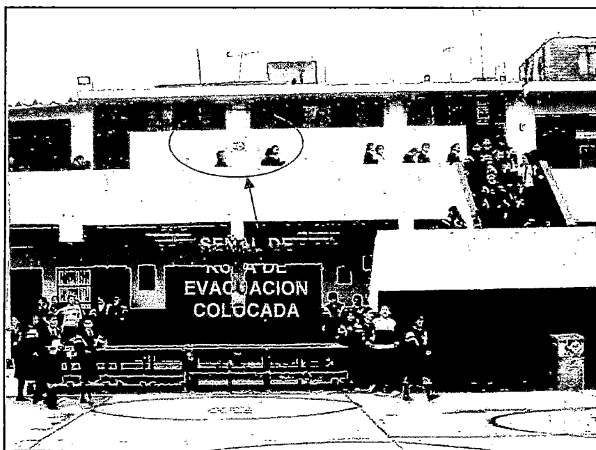
Fig. 8-21 I.E. ESTHER CACERES Se observa la señalización de las rutas de evacuación. Fuente: Elaboración Propia
