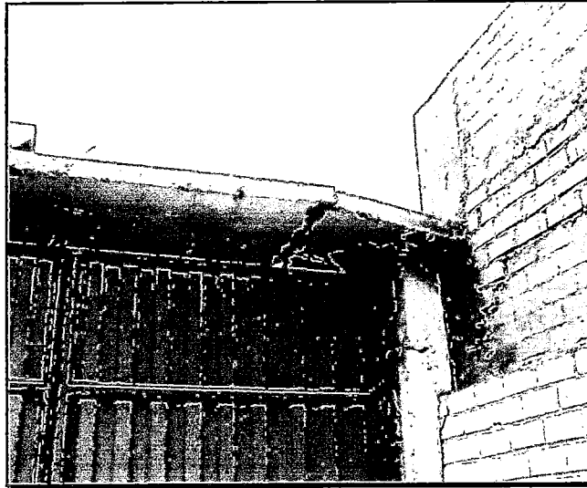
Fig.7-33 INSTITUCION EDUCATIVA “ESTHER CACERES SALGADO” La salida de emergencia cercana a la Av. Alcázar en muy insegura y podría quedar inhabilitada en cualquier momento. Fuente: Elaboración Propia
