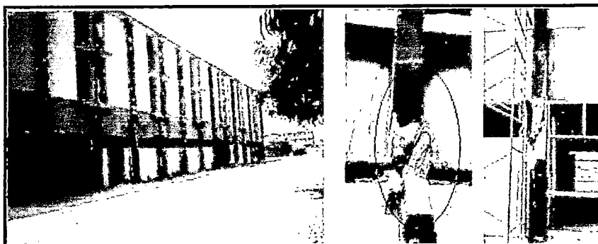
Fig. 5-7 Fallas por columna corta.
