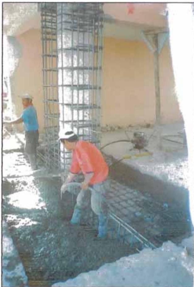
Figura 4.3.1-10 Fundas de concreto armado en columnas.
