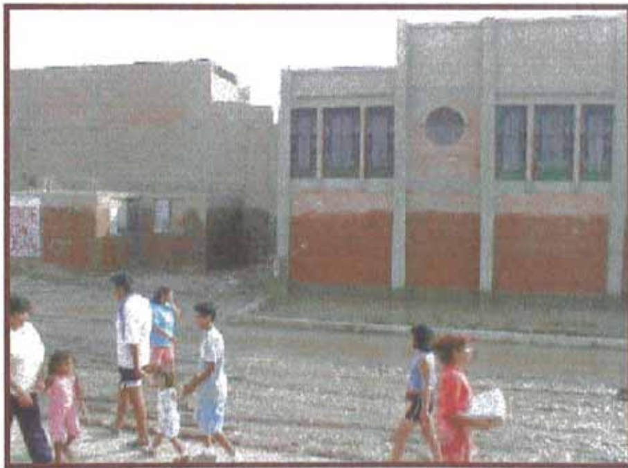
Foto 10: Iglesia en calle Copacabana Obsérvese la marca del máximo nivel de agua alcanzado
