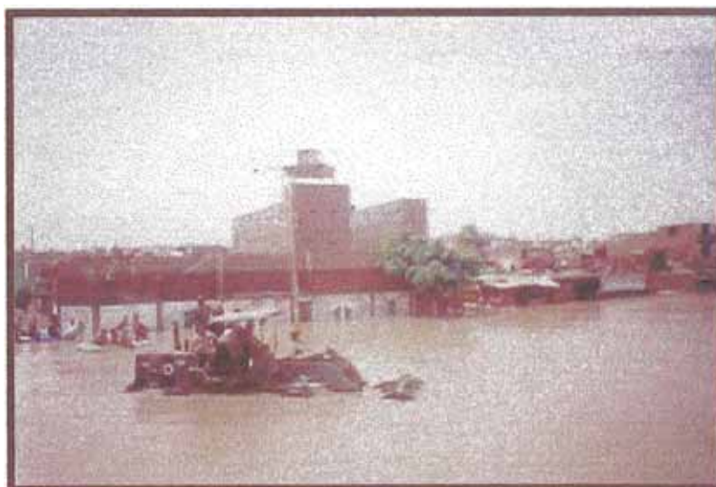
Foto 14: Zona crítica de inundación
