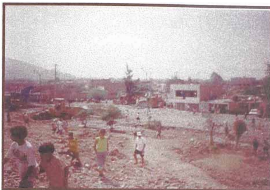
Foto 11: Acumulación de Material Sólido frente a la fisura del dique
