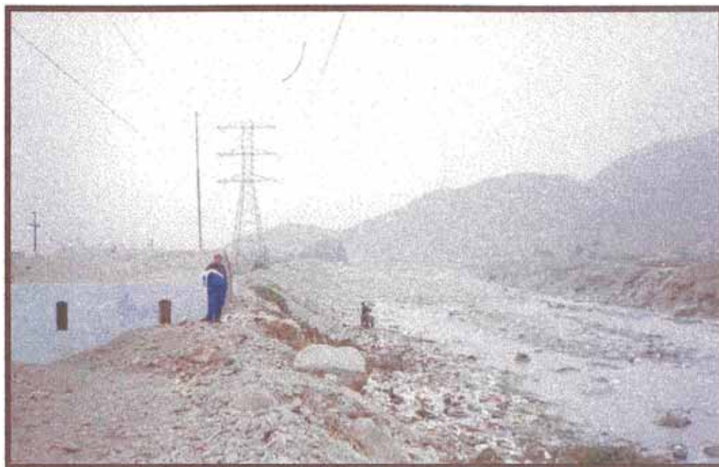
Foto 7 “Zona de Ruptura de Dique”
