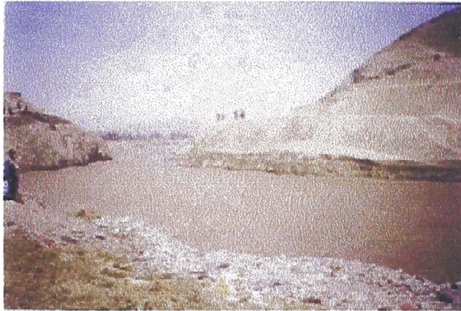
Foto 7. Estrangulamiento del cauce – Puente Inca
