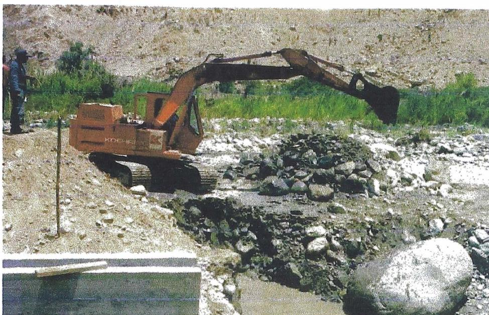
EXCAVACIÓN PARA LA UÑA DE EMPOTRAMIENTO DEL ENROCADO|||
