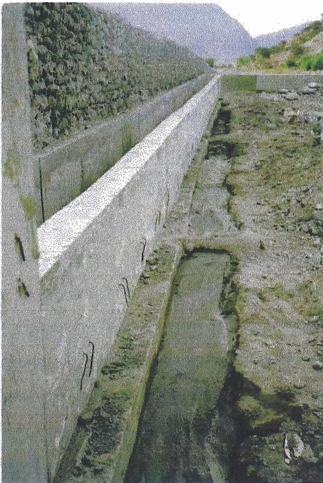
**VISTA DEL TRAMO DEL CANAL RECONSTRUIDO EN SU TOTALIDAD ASEGURANDO SU CIMENTACIÓN CON CONCRETO CICLOPEO**
