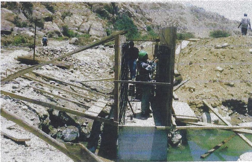
CIMENTACIÓN Y ENCOFRADO DE MUROS EN LA BOCATOMA
