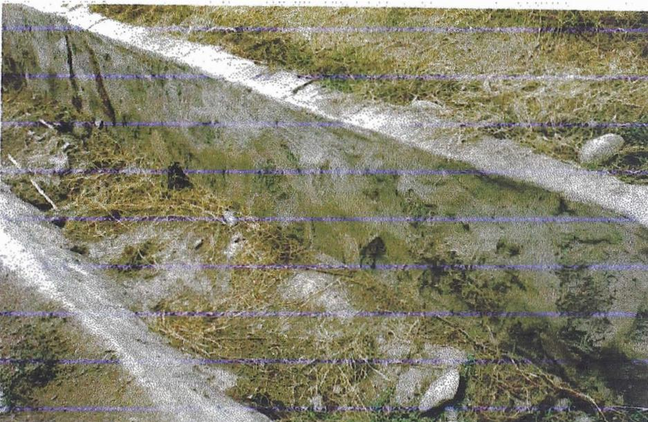
**CANAL EXISTENTE DE MAMPOSTERÍA DE PIEDRA EN BUEN ESTADO, AL CUAL SE HARA EL EMPALME EN LA PROGRESIVA FINAL DEL PROYECTO**
