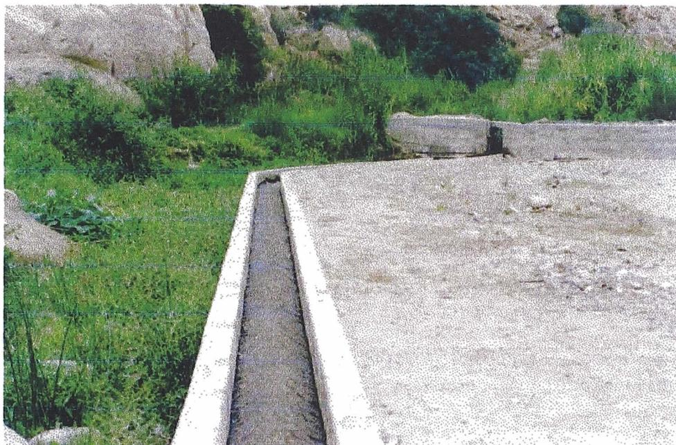
VISTA DEL RELLENO COMPACTADO LATERAL AL CANAL, AL FINAL DE LA PROGRESIVA DEL PROYECTO
