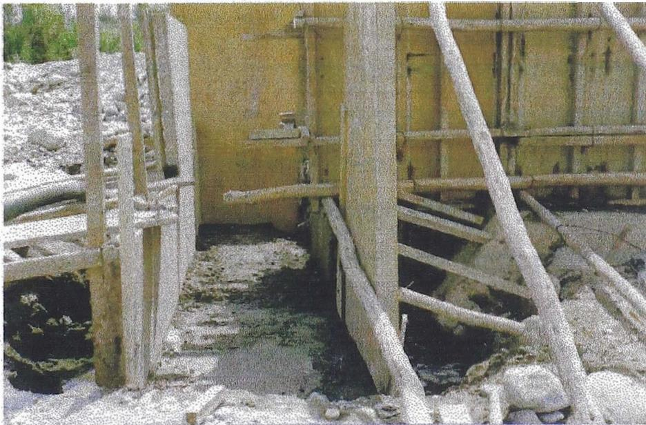
**VISTA DEL VACIADO DE CONCRETO CICLÓPEO BAJO LA ZONA DE CIMENTACIÓN DONDE DESCANSARAN LOS RIELES**
