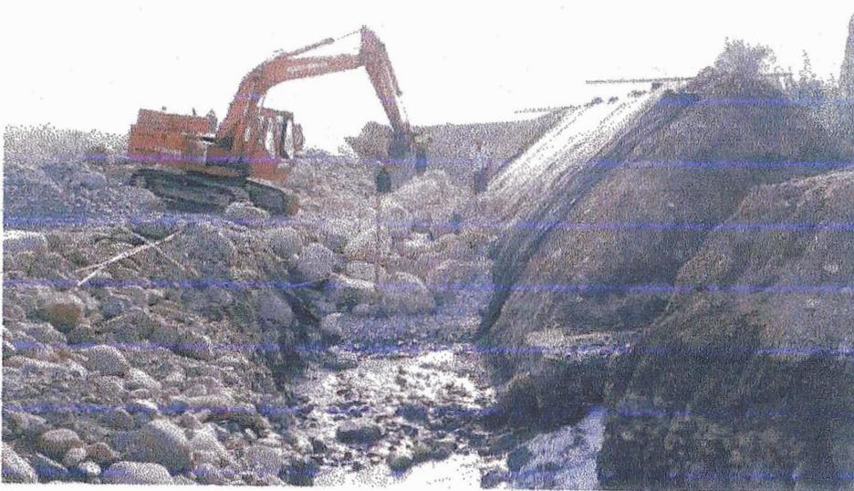
**COLOCACIÓN DEL ENROCADO SOBRE EL GEOTEXTIL Y FILTRO DE GRAVA**
