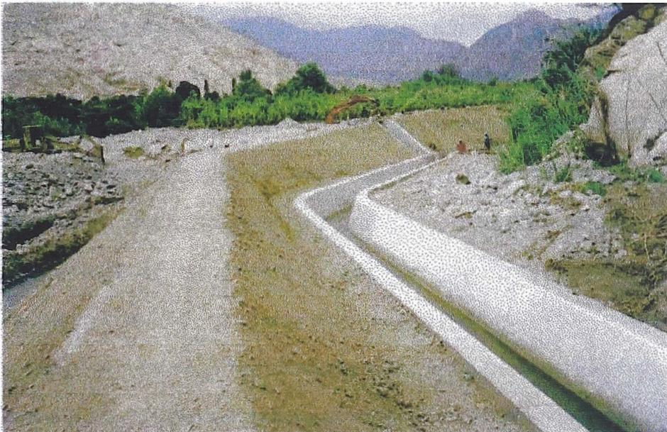
VISTA GENERAL DE LA CONFORMACIÓN DEL DIQUE DE PROTECCIÓN, CON EL DESARROLLO DEL CANAL PENCO EN EL SECTOR BOCATOMA
