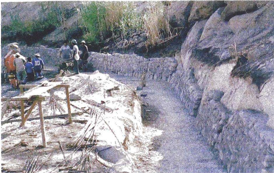
OBSERVESE LA CONFORMACIÓN DE RELLENOS LATERALES DE CONCRETO CICLÓPEO PARA LA CONSTRUCCIÓN DE MUROS DEL CANAL
