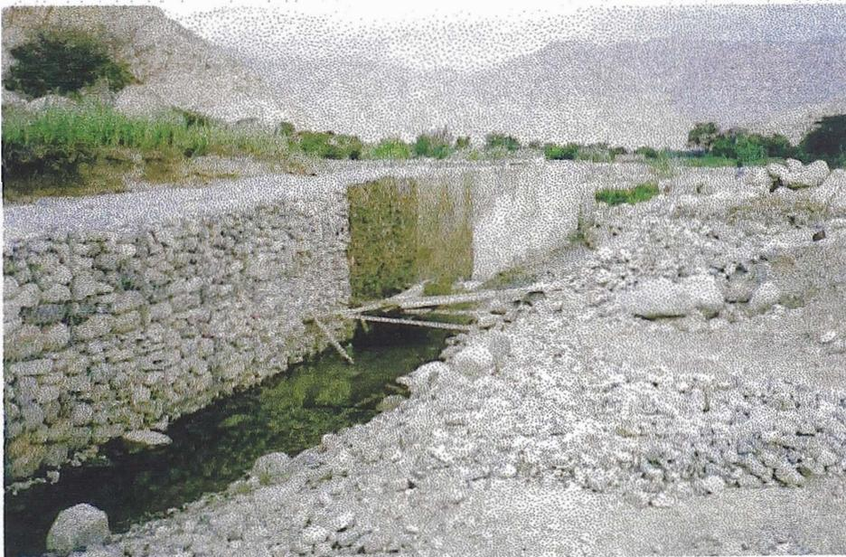
**VISTA DEL PROCESO DE PROTECCIÓN DE GAVIONES , MEDIANTE EL COLOCADO DE RECUBRIMIENTO DE CONCRETO**
