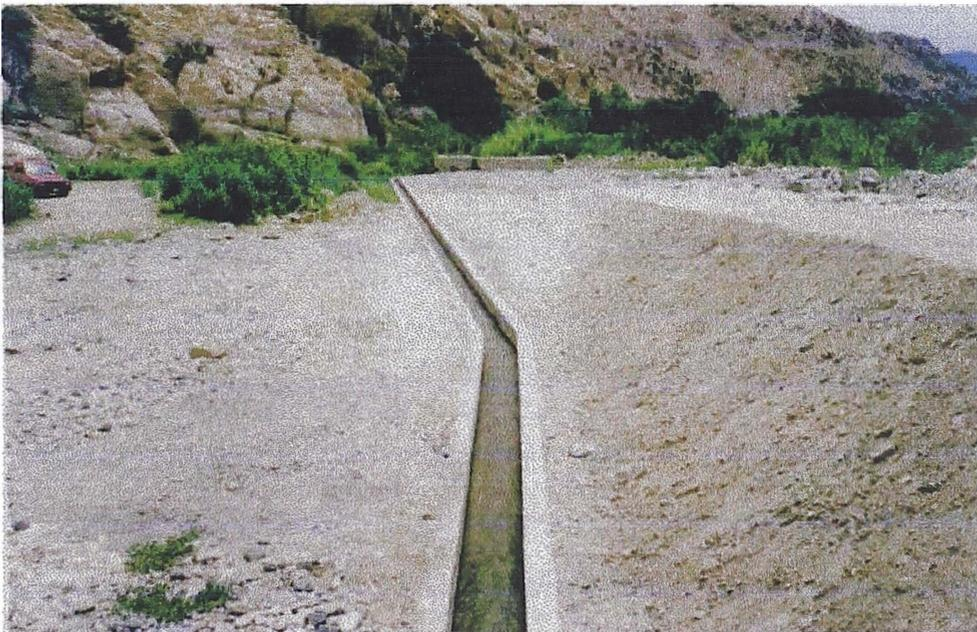
**VISTA DEL CANAL JAIVA, RELLENO COMPACTADO LATERAL Y
