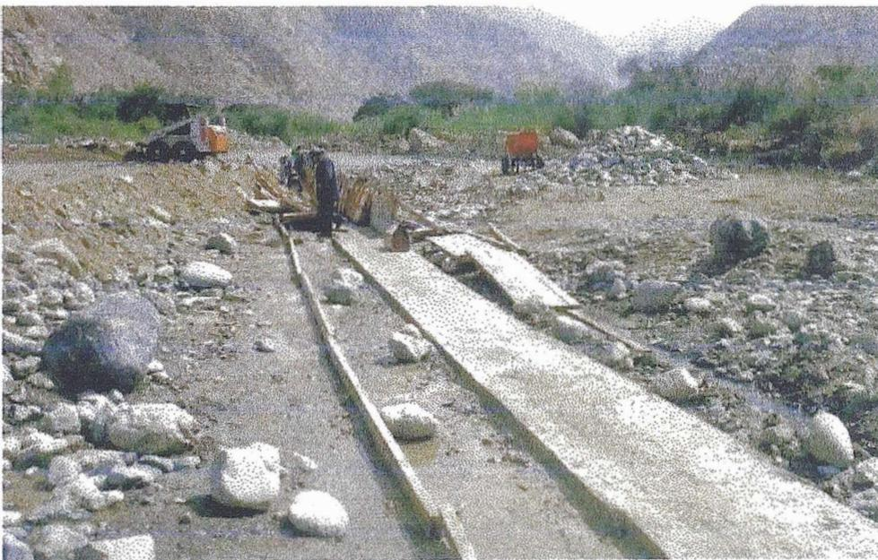
VISTA DEL SOLADO Y COLOCACIÓN DE ENCOFRADO PARA EL CANAL
