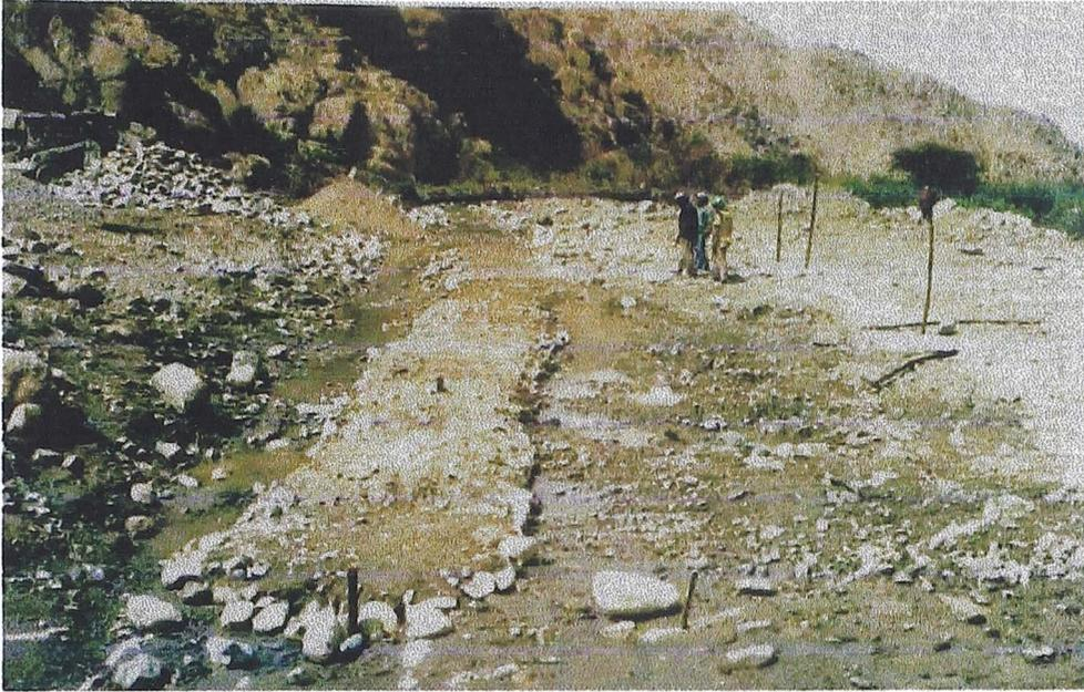
CONFORMACIÓN , ALINEAMIENTOS Y RASANTE DEL CANAL JAIVA
