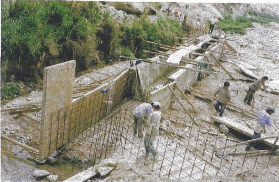
VISTA DEL ENCOFRADO EN LA ZONA DE TRANSICIÓN ENTRE LA BOCATOMA Y EL CANAL PEÑICO
