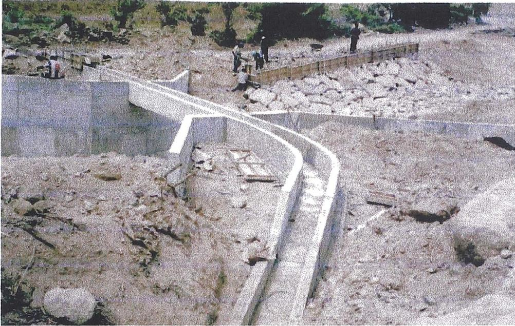
VISTA DEL EMPALME DEL CANAL DEL PROYECTO CON EL DE FONCODES, OBSERVESE LA TRANSICIÓN (AGUAS ABAJO DEL ACUEDUCTO)
