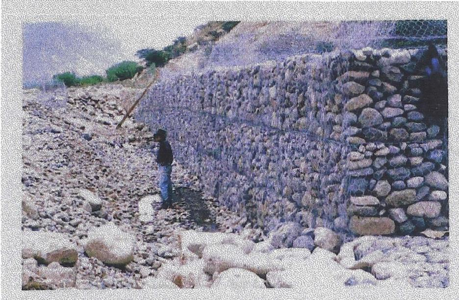
**VISTA DE GAVIONES DE PROTECCIÓN A LA BOCATOMA Y CANAL LIMONCILLO, UBICADO EN LA MARGEN DERECHA DEL RIO SUPE**
