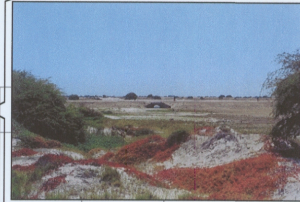
Foto: Vista del km.853+000(corte) desde la quebrada, en la etapa de transitabilidad (se observa una alcantarilla asentada).
