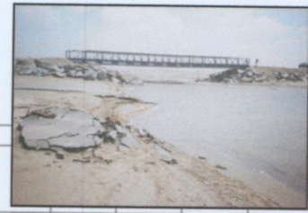
Foto: Vista del flujo de la quebrada EL SARCO II (corte), Km. 822+800 (puente bayil provisional). Puntos: Ingreso de transabilidad
